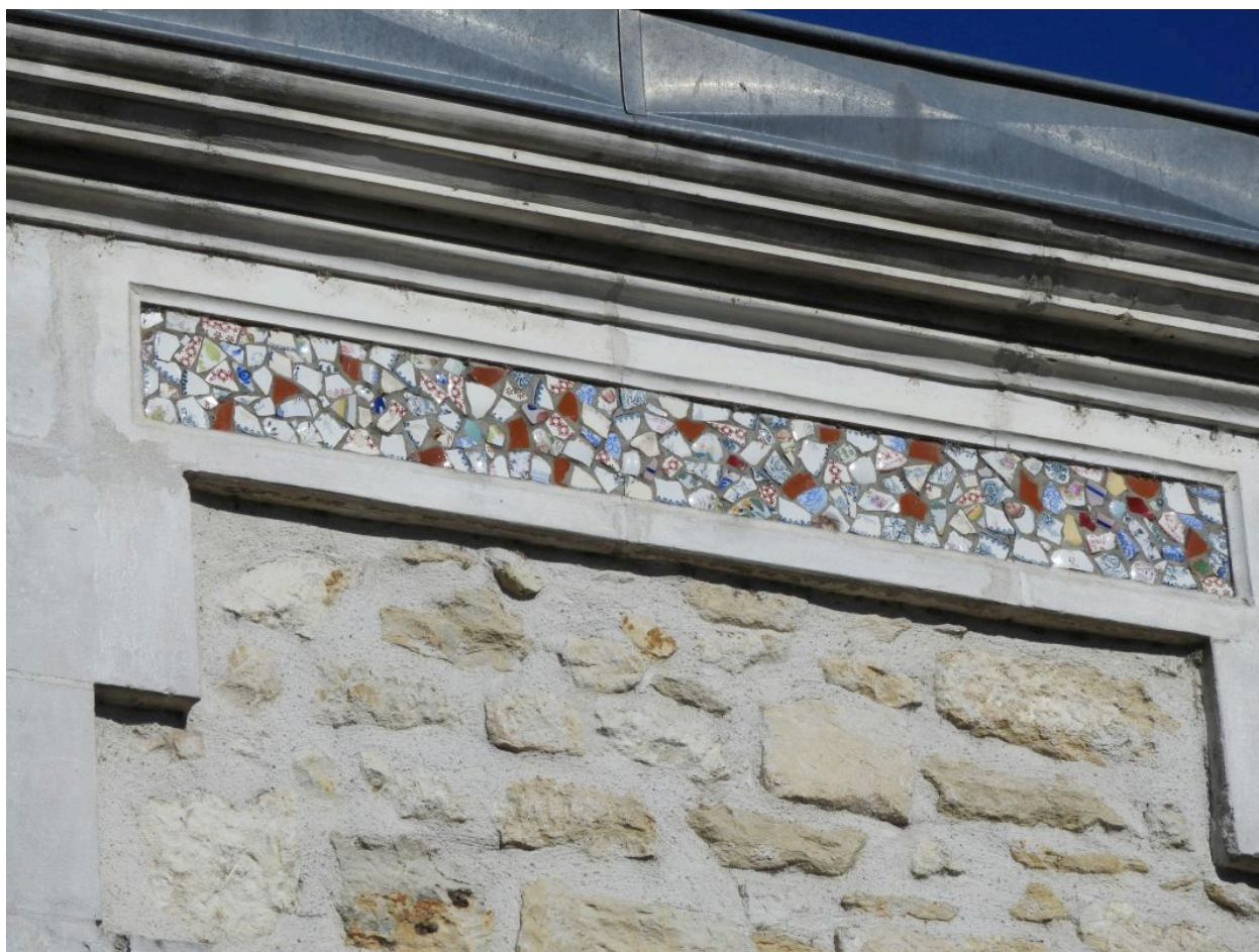
Détail de la frise constituée de morceaux de faïence, au sommet de la façade.
