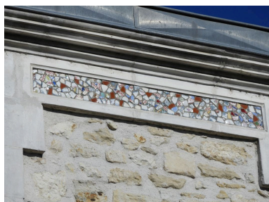
Détail de la frise constituée de morceaux de faïence, au sommet de la façade. Phot. Yannis Suire IVR52_20198500091NUCA
