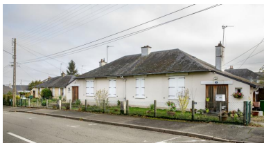
Vue des maisons du Camp d'Etat avenue du Maine. Phot. Pierre-Bernard Fourny IVR52_20197202590NUCA
