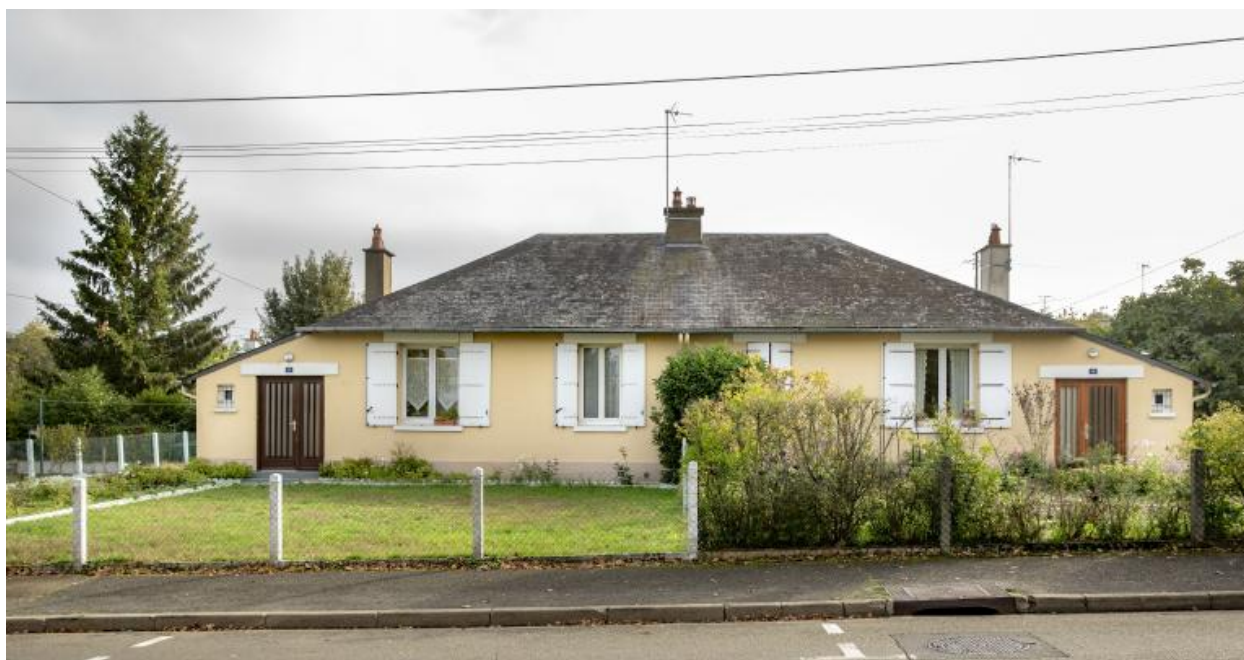
Vue de la façade côté rue d'une maison du Campe d'Etat avenue du Maine.
