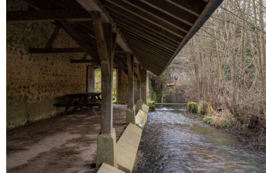
L'intérieur du lavoir et le cours d'eau avec la vanne en arrière-plan. Phot. Jeanne Minier IVR52_20267200105NUCA
