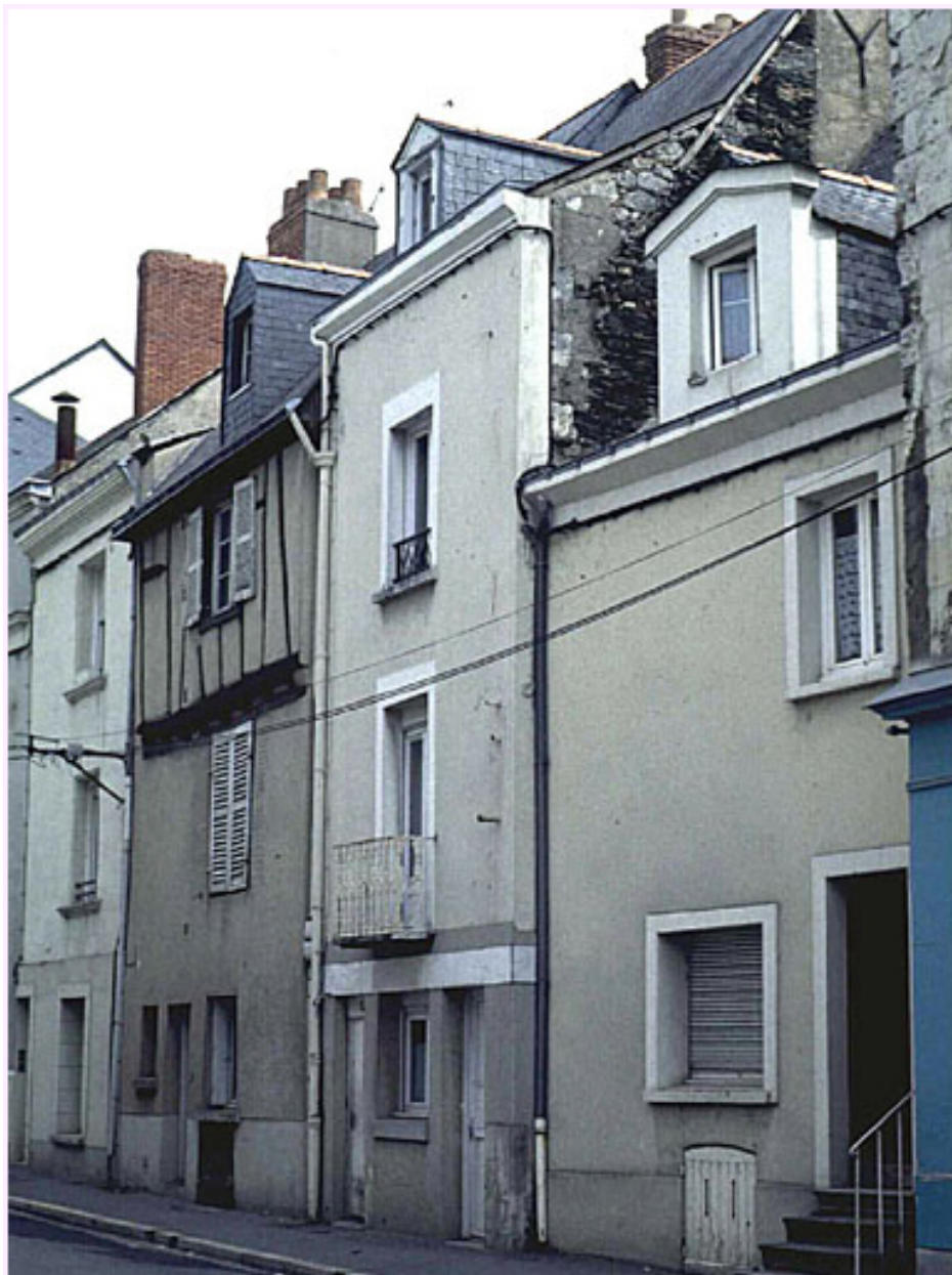
Vue d'ensemble sur rue.
