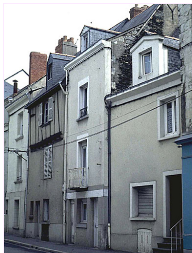
Vue d'ensemble sur rue. Phot. Dominique Letellier IVR52_20004900468ZA
