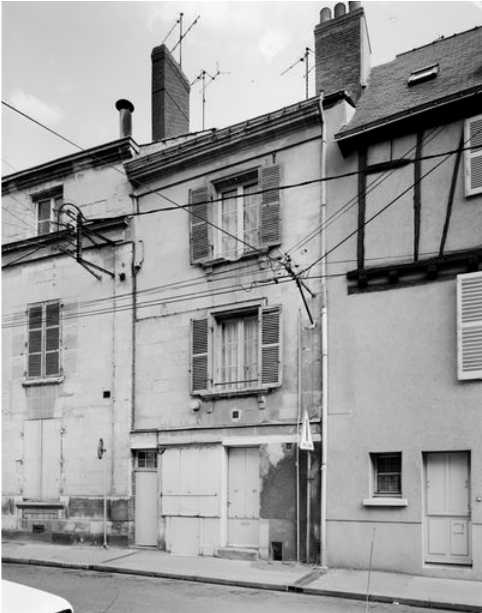
Elévation sur rue (n° 27).
