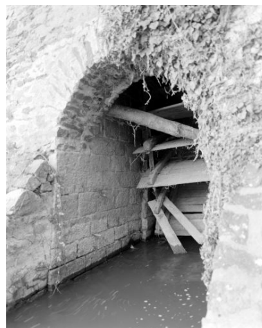
La roue et le coursier vus d'aval. Phot. François Lasa IVR52_20015300735X
