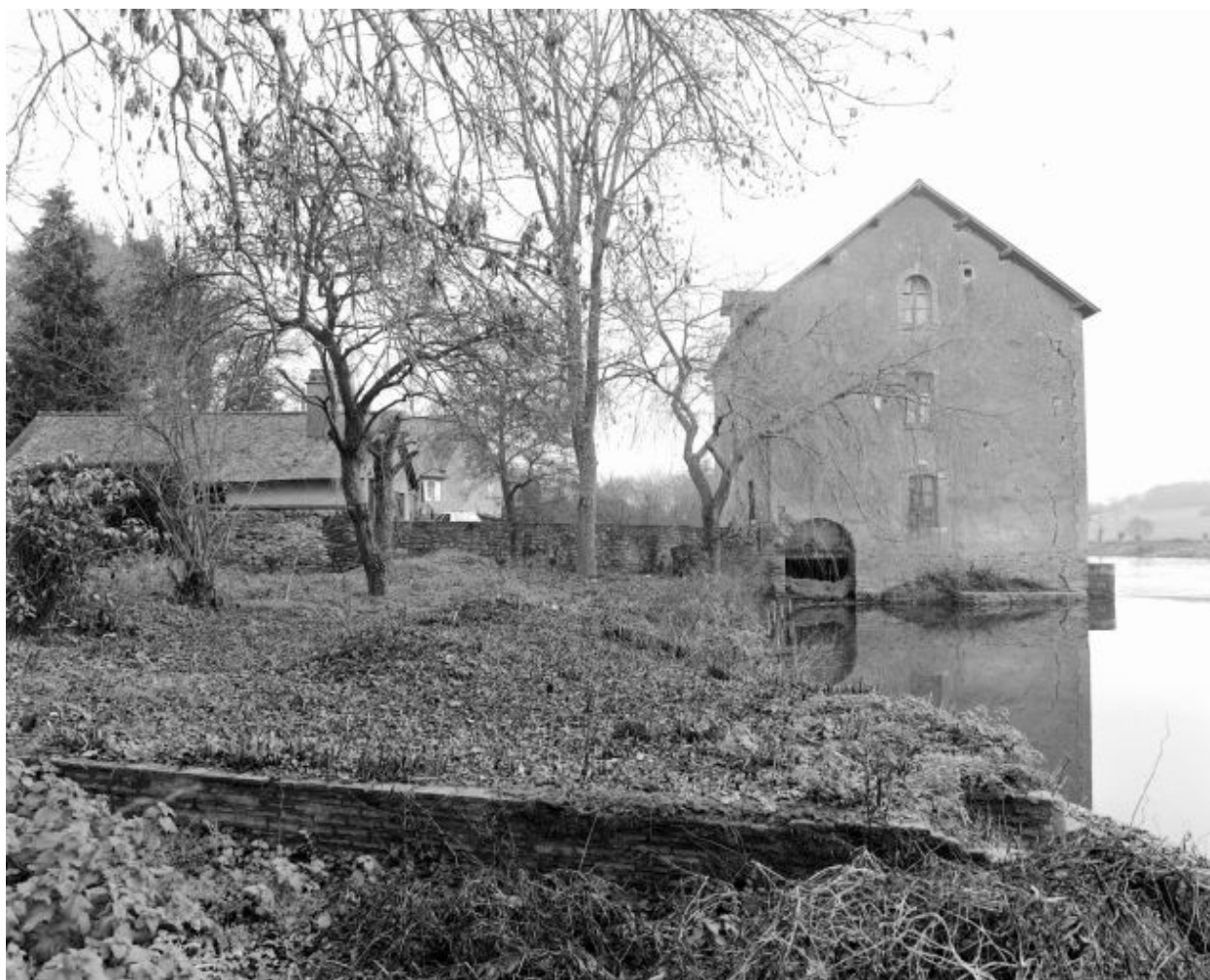
Vue d'amont : façade nord-ouest et entrée du coursier du moulin. A gauche l'ancien hangar, transformé en maison. Au second plan, l'ancienne maison du meunier.
