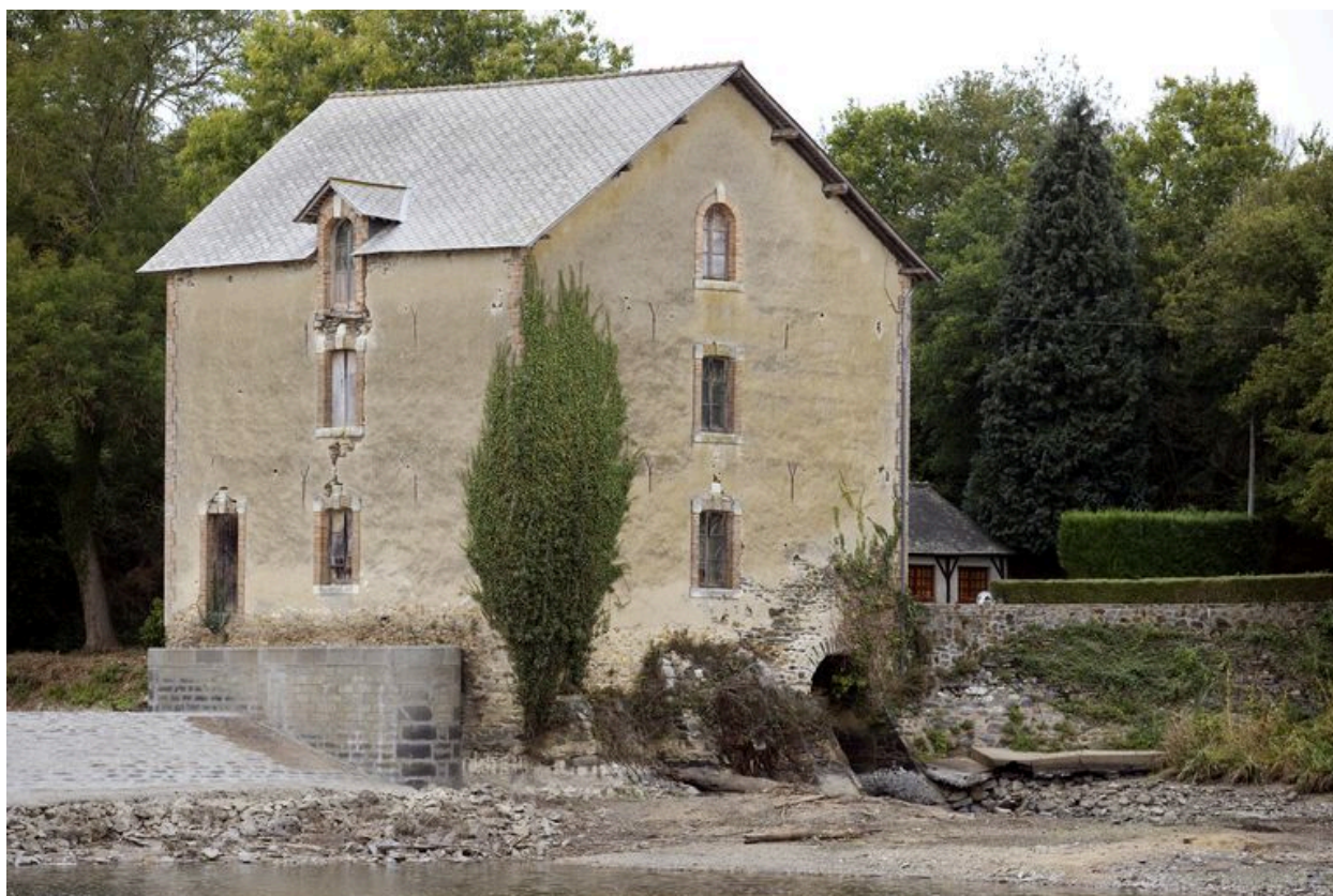
Vue depuis le sud pendant les écourues de 2009 : façades sud-ouest et sud-est (d'aval).
