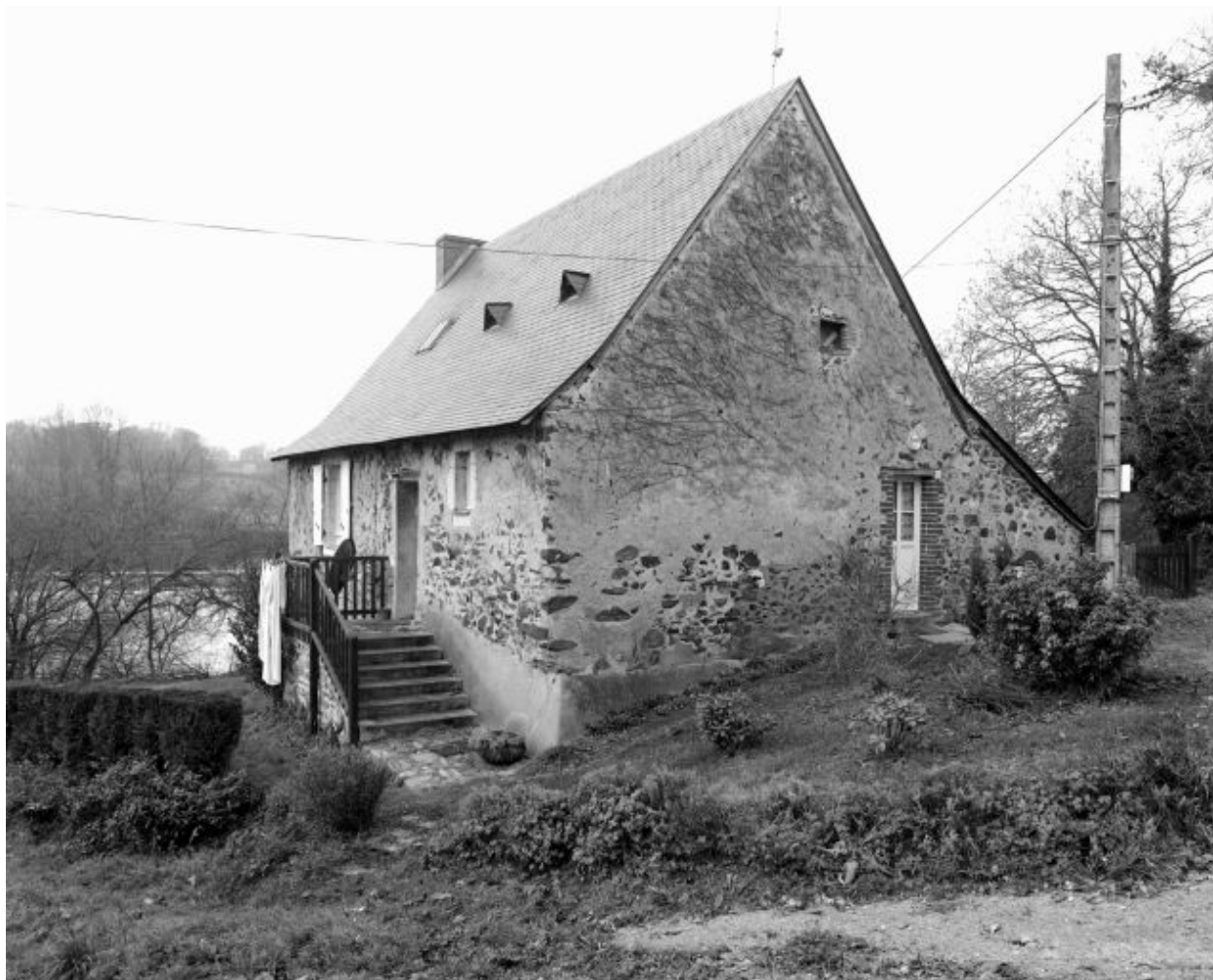
L'ancienne maison du meunier vue de l'est : façade principale (au sud-est) et façade nord-est.
