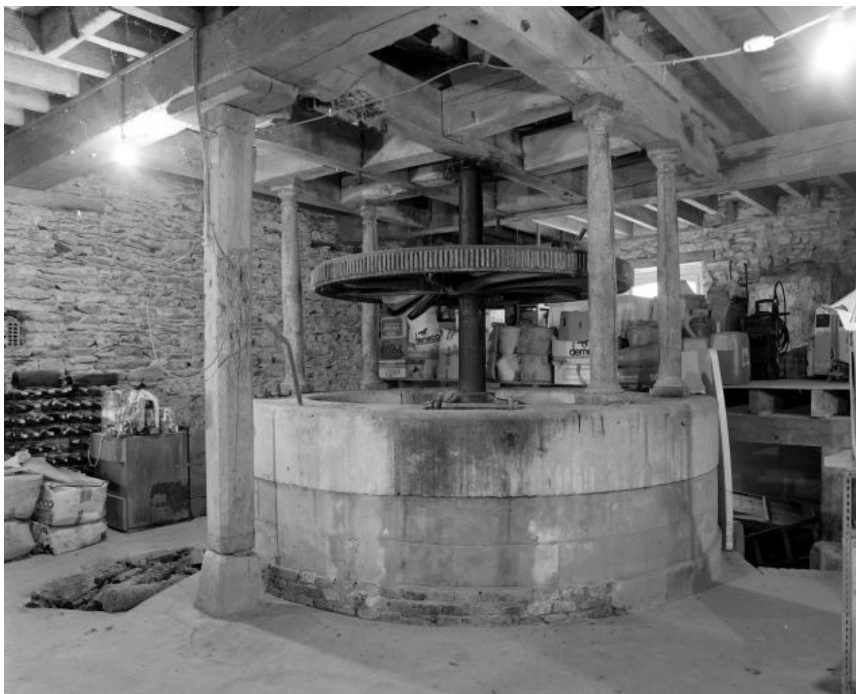
La poquerie, contenant le mécanisme de transmission de la force motrice.
