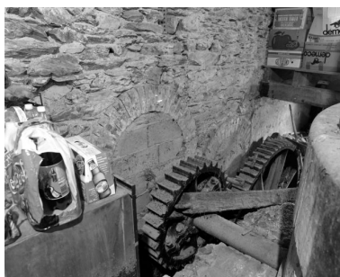
Roues de transmission : la première à droite est entraînée par l'arbre moteur de la roue hydraulique. S'engrenant sur elle, la seconde transmet le mouvement de rotation à l'axe horizontal (au premier plan) relié à l'axe vertical de la poquerie. Phot. François Lasa IVR52_20015300738X
