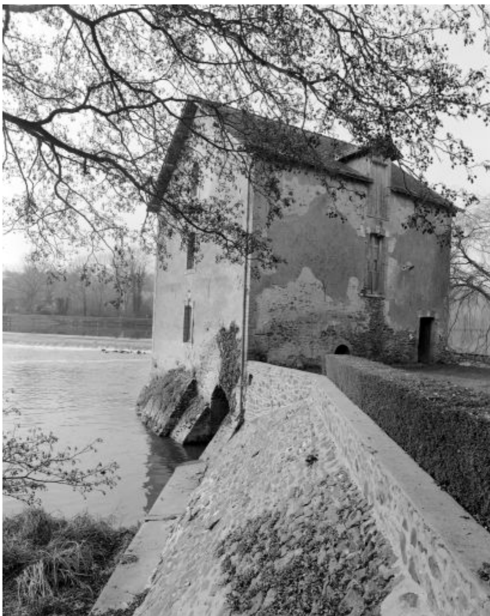
Vue de l'est : façades sud-est (d'aval) et nord-est.
