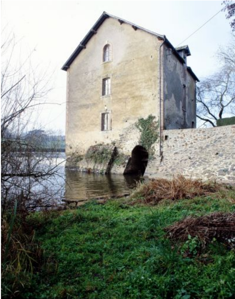
La façade sud-est et la sortie du coursier.
