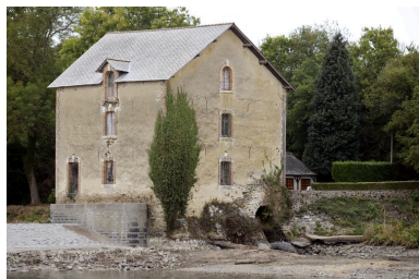
Vue depuis le sud pendant les écourées de 2009 : façades sud-ouest et sud-est (d'aval). Phot. Yves Guillotin IVR52_20095300482NUCA
