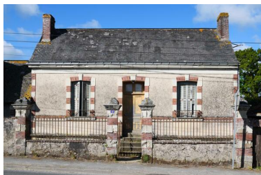
Façade principale. Phot. Armelle Maugin IVR52_20254900613NUCA
