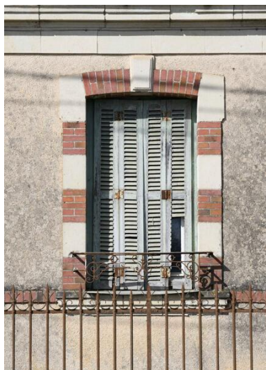
Détail d'une fenêtre. Phot. Armelle Maugin IVR52_20254900616NUCA
