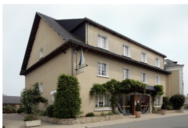
Vue depuis la rue au sud-ouest. Phot. François Lasa IVR52_20075302196NUCA
