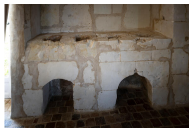
Logis : potager. Phot. Thierry Seldubuisson IVR52_20247200503NUCA
