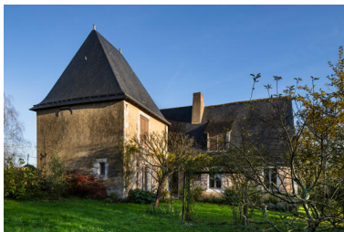
Logis : élévation sud-ouest. Phot. Thierry Seldubuisson IVR52_20247200497NUCA
