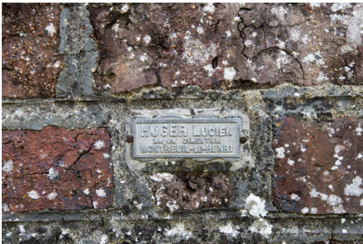
Lieux d'aisance extérieurs : marque de maçon.
