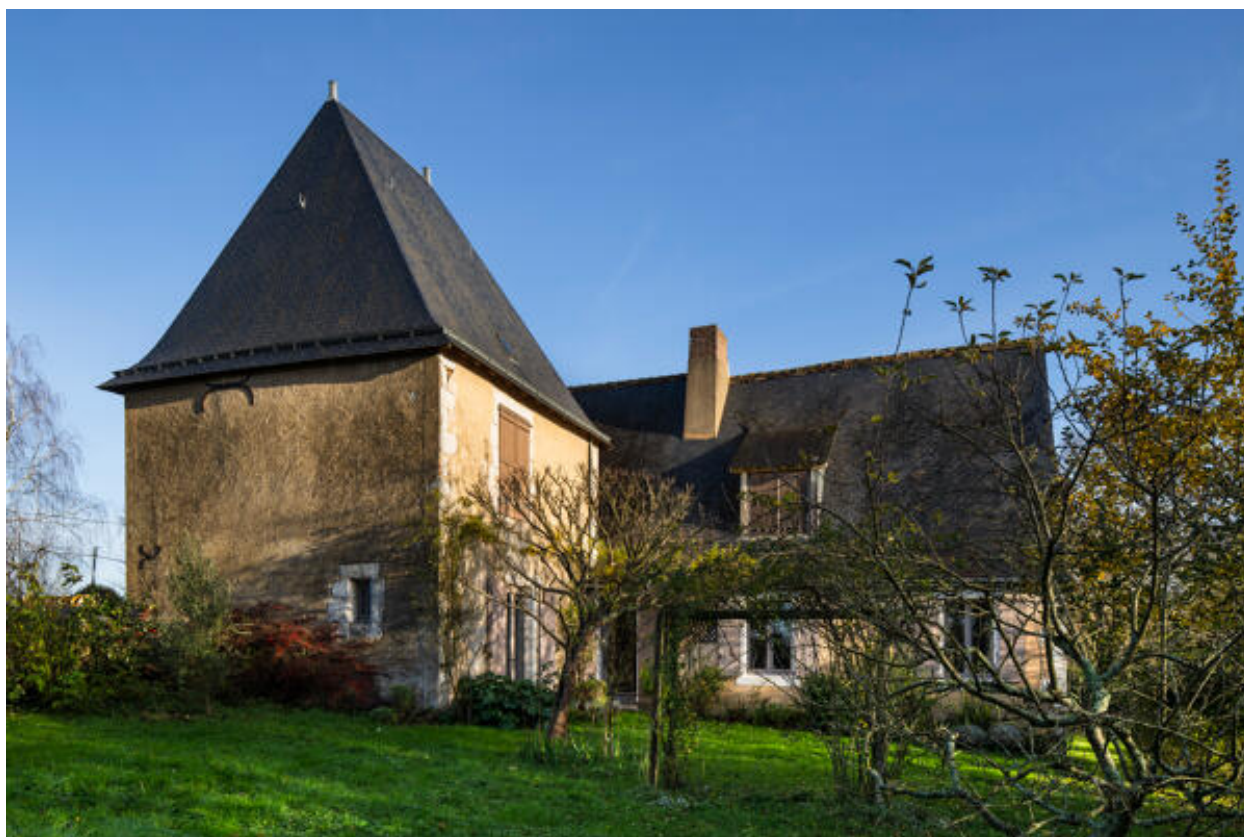
Logis : élévation sud-ouest.
