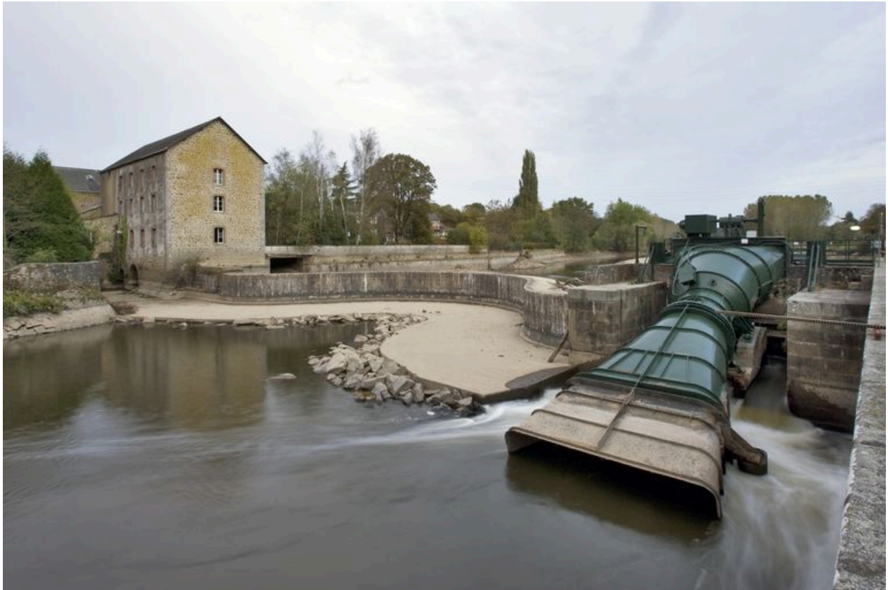
Vue d'ensemble depuis l'aval pendant les écourues de 2009 : moulin, barrage, centrale hydroélectrique.
