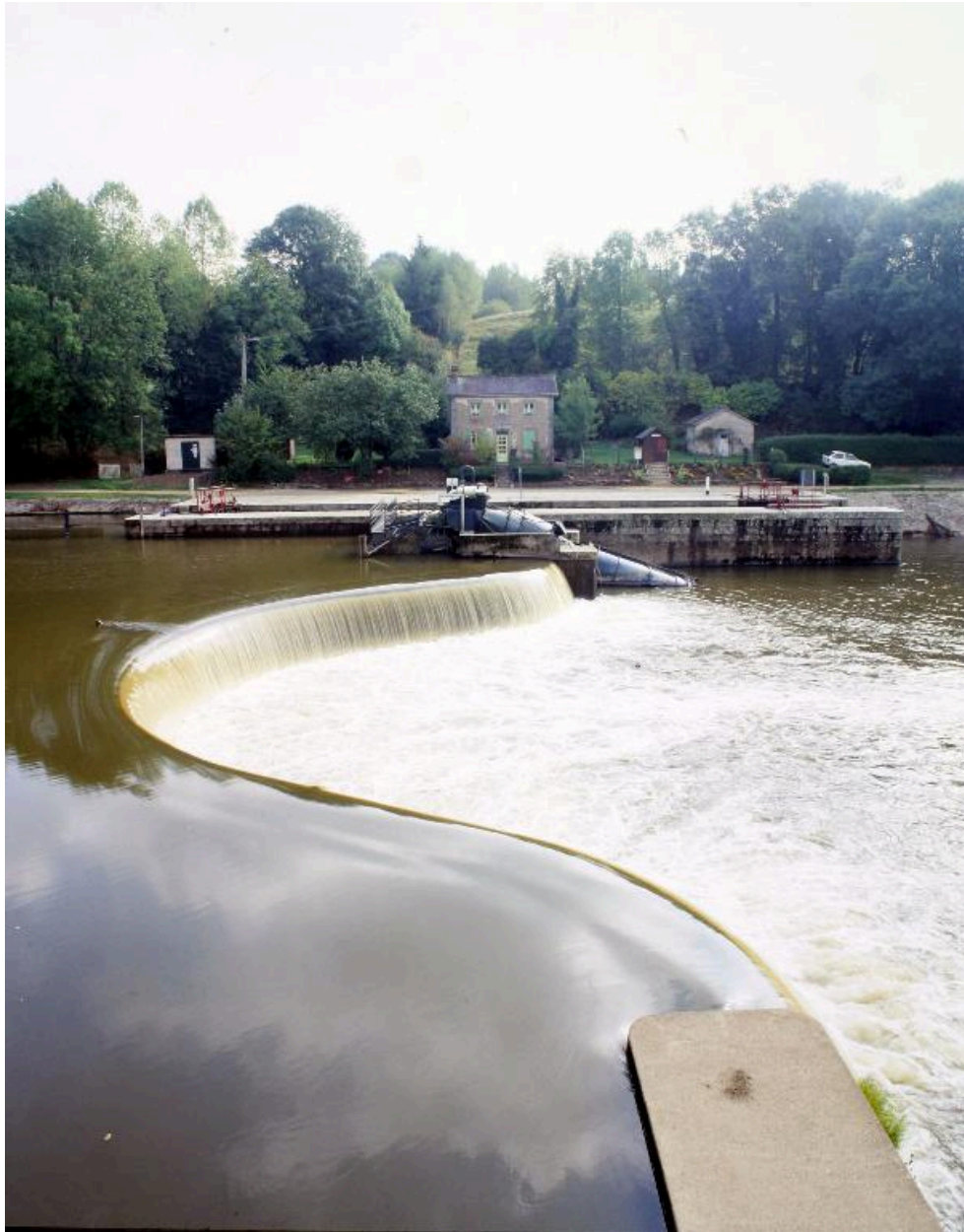
Le barrage, la centrale hydroélectrique, l'écluse, le transformateur, la maison éclusière et le fournil, vus depuis le premier étage du moulin .
