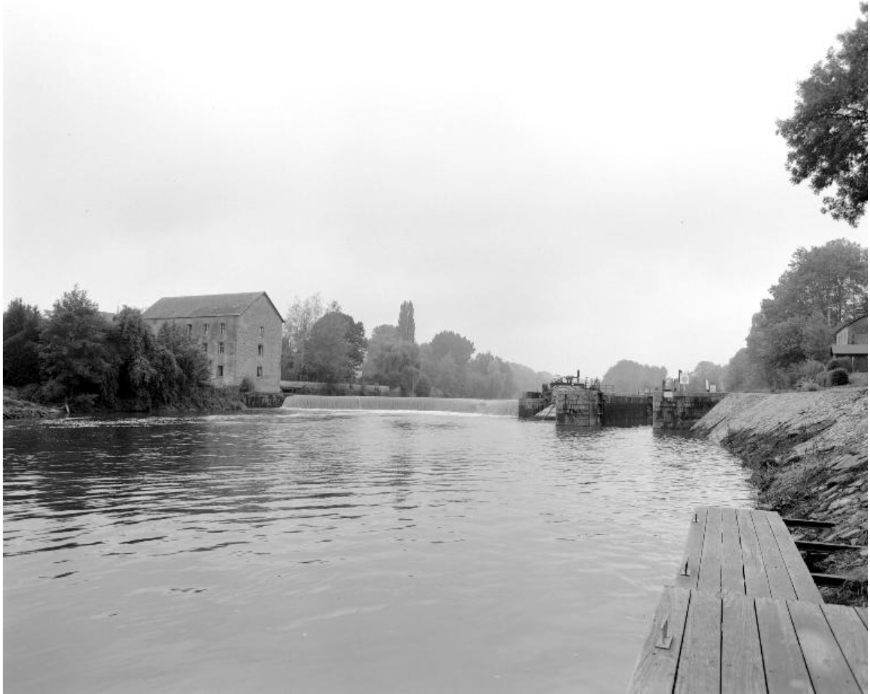
Vue d'ensemble du site d'écluse depuis le ponton situé en aval : moulin, barrage, centrale hydroélectrique, écluse, maison éclusière.
