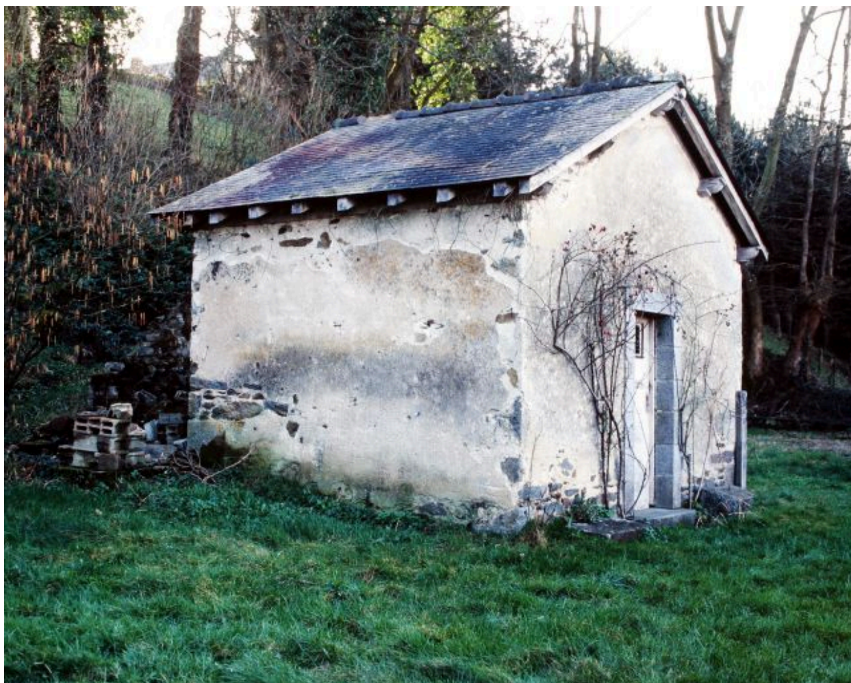
Le fournil vu du nord-ouest.
