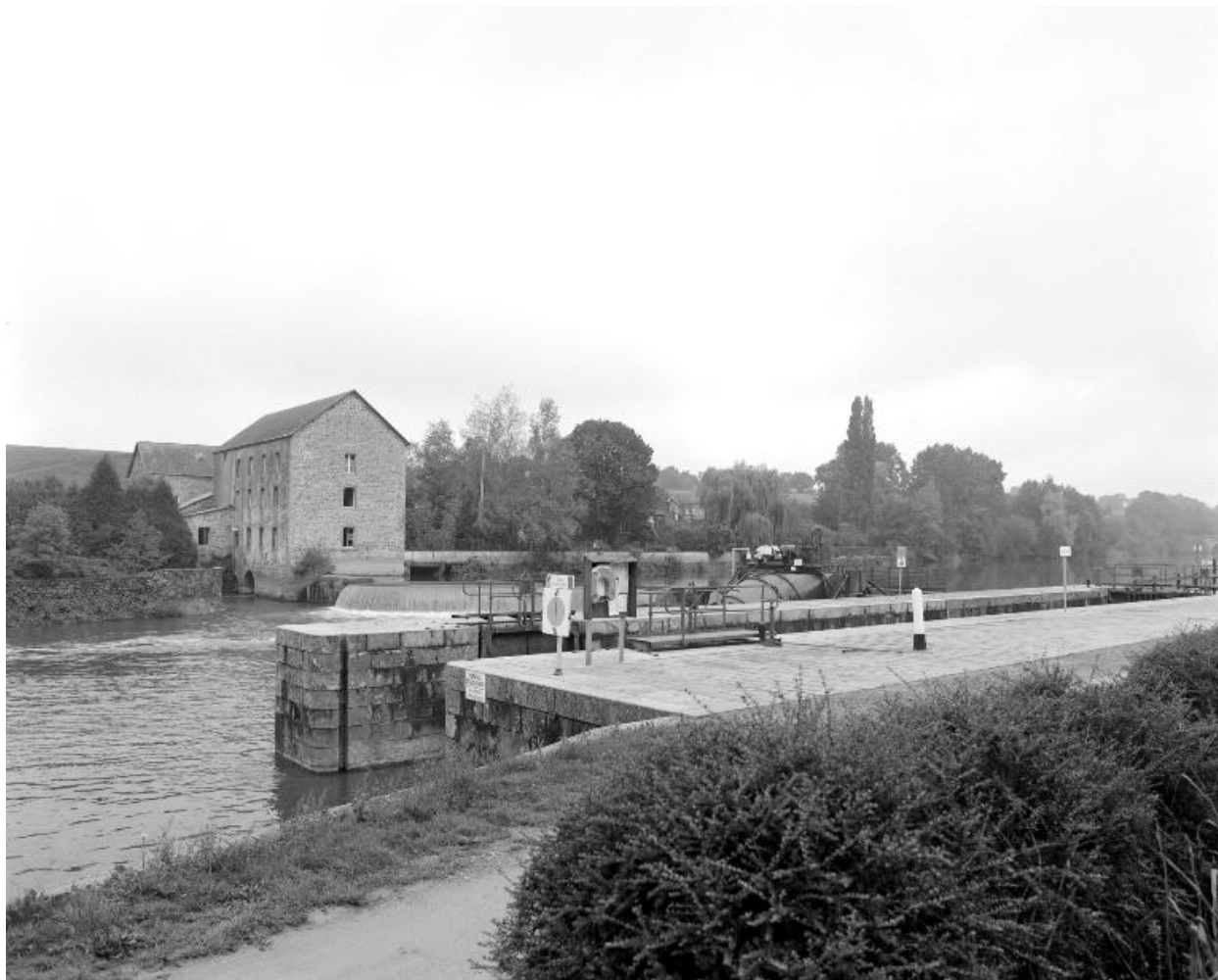
Vue d'ensemble du site depuis la rive gauche : moulin, barrage, centrale hydroélectrique, écluse.
