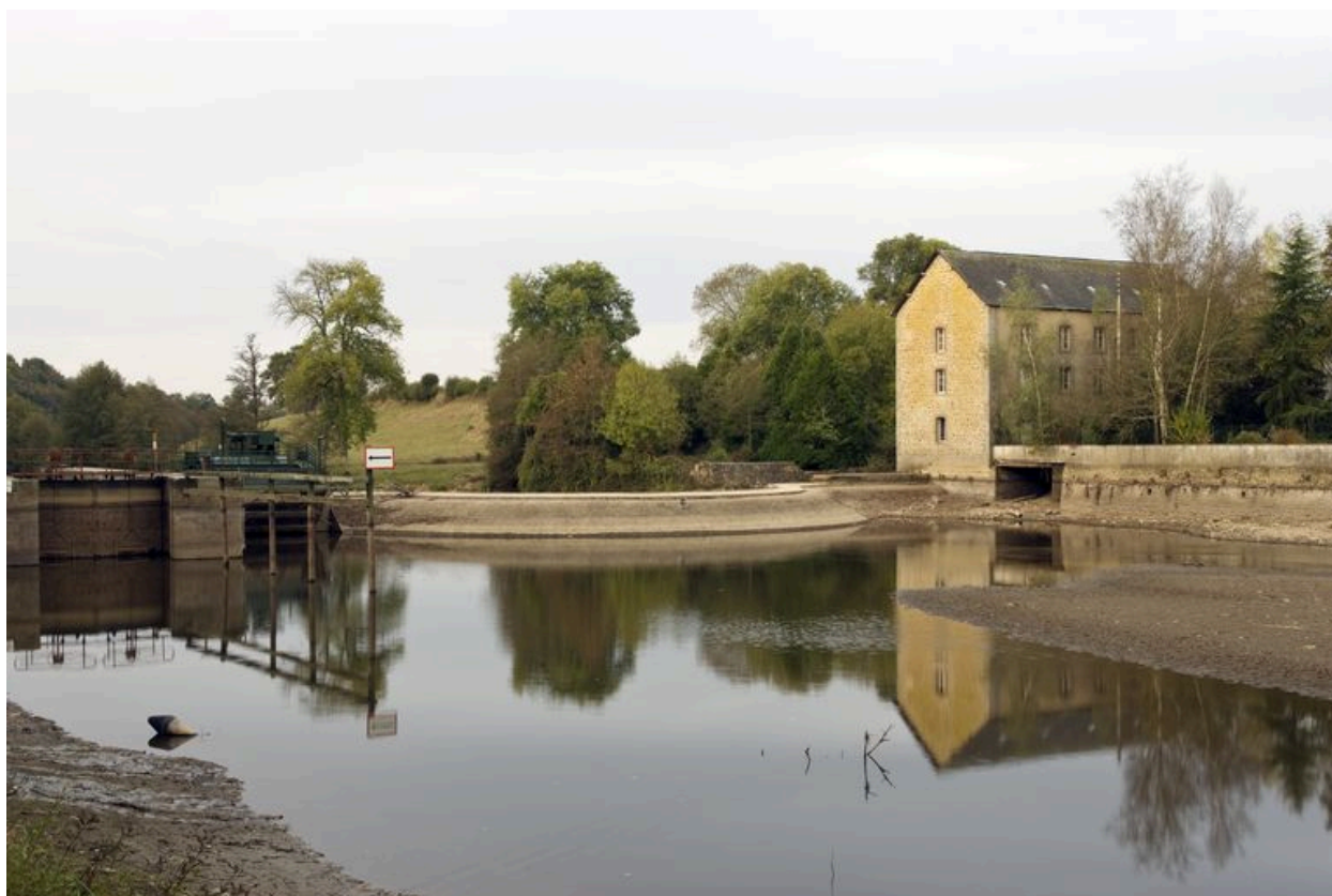
Vue d'ensemble depuis l'amont pendant les écourues de 2009 : écluse, pertuis, barrage, moulin.
