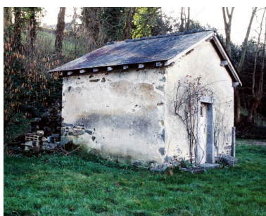
Le fournil vu du nord-ouest. Phot. François Lasa IVR52_20025300364XA
