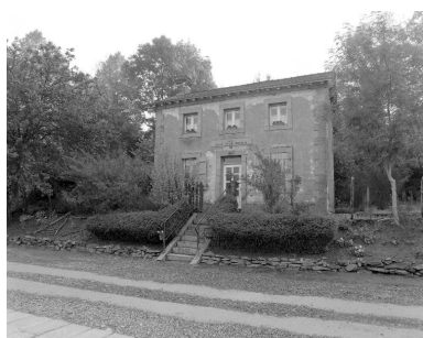
La maison éclusière. Phot. François Lasa IVR52_20015300421X
