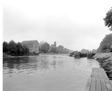
Vue d'ensemble du site d'écluse depuis le ponton situé en aval : moulin, barrage, centrale hydroélectrique, écluse, maison éclusière. Phot. François Lasa IVR52_20015300418X
