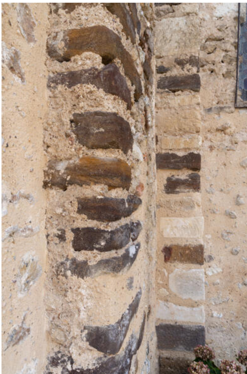
Chaînes en grès roussard et pierre de taille calcaire, entre l'abside et la nef, côté sud-est.
