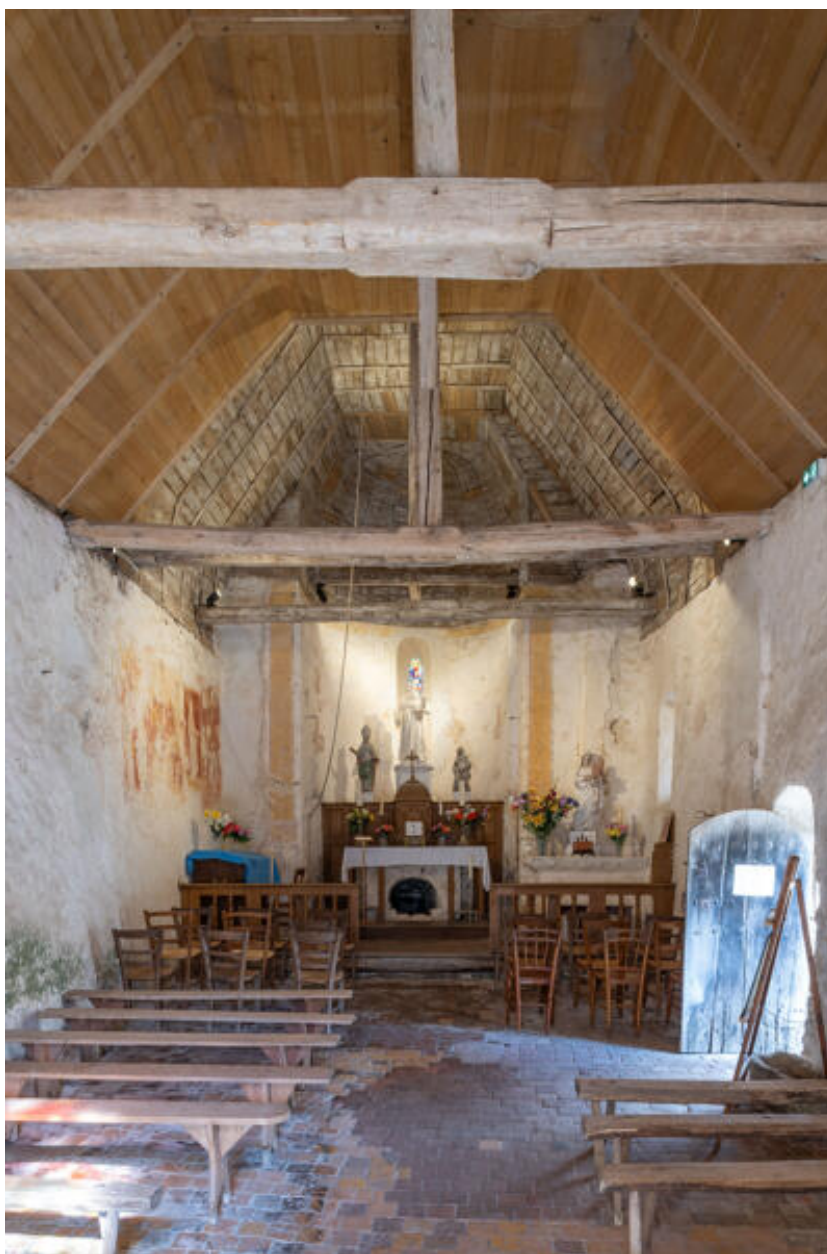
La nef, vue depuis l'entrée ouest.
