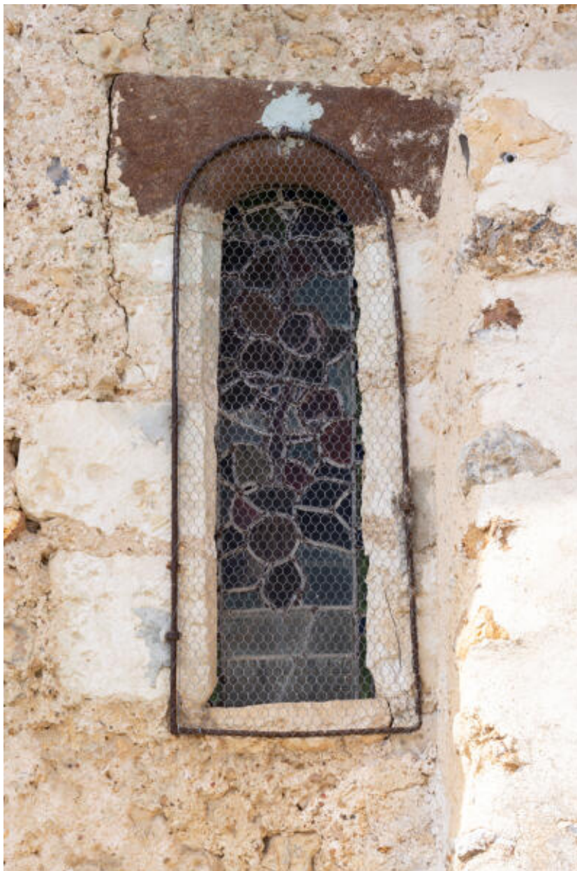
Fenêtre de la nef, côté sud-est.
