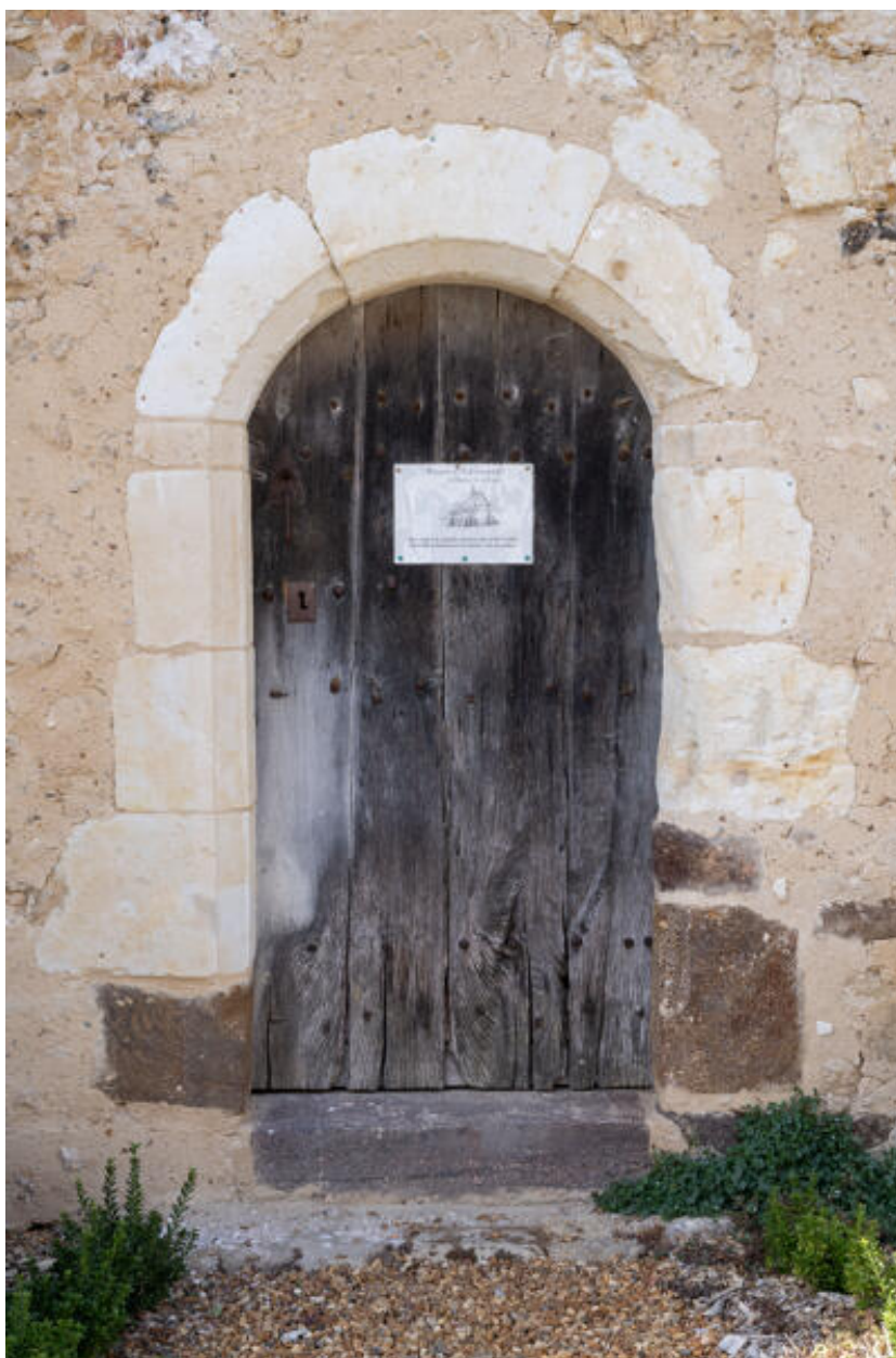
Porte latérale de la nef, côté sud-est.
