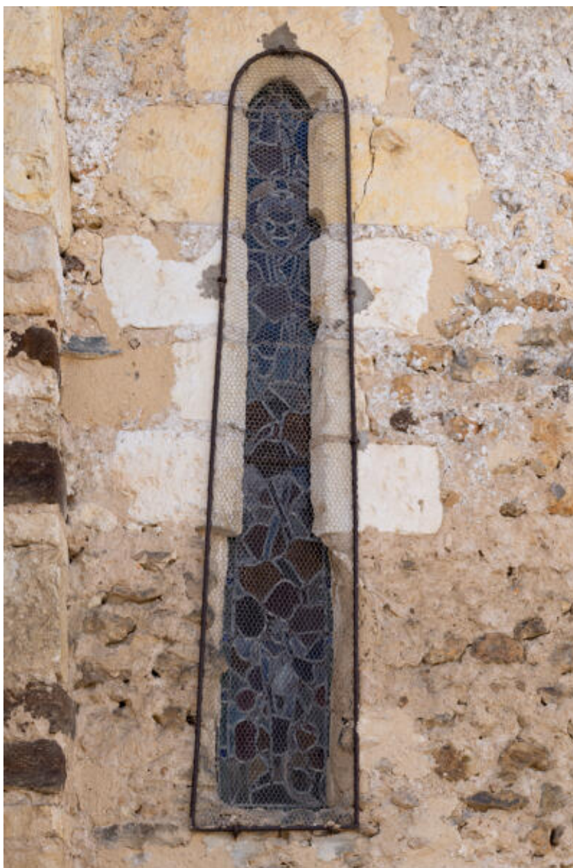
Fenêtre de l'abside, côté sud-est.
