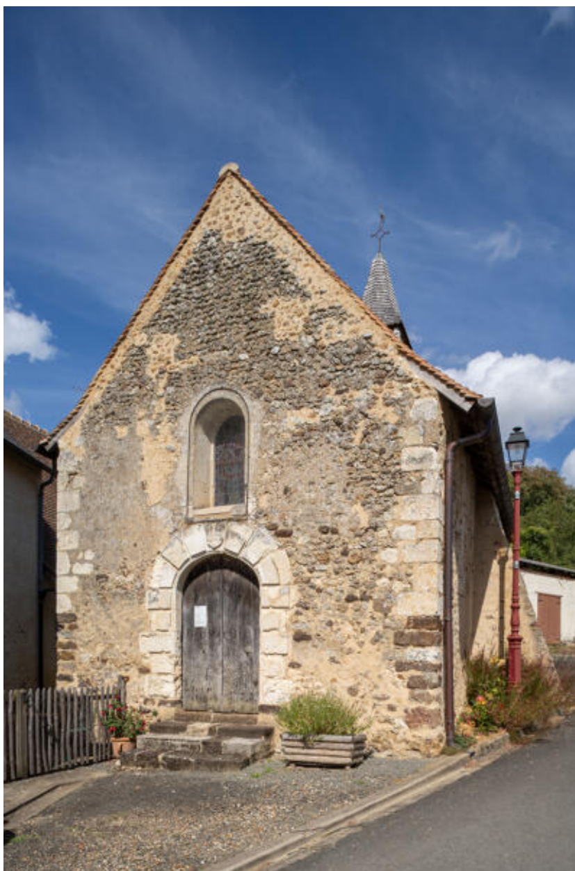
Pignon, vue depuis le sud-ouest.
