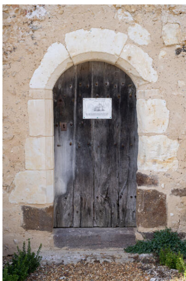
Porte latérale de la nef, côté sud-est. Phot. Jeanne Minier IVR52_20257200484NUCA
