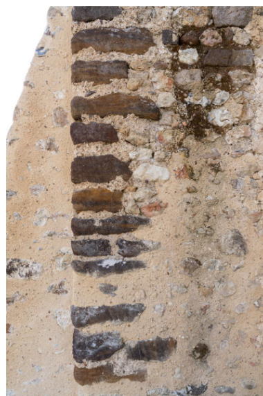
Chaîne en grès roussard, entre l'abside et la nef. Phot. Jeanne Minier IVR52_20257200486NUCA
