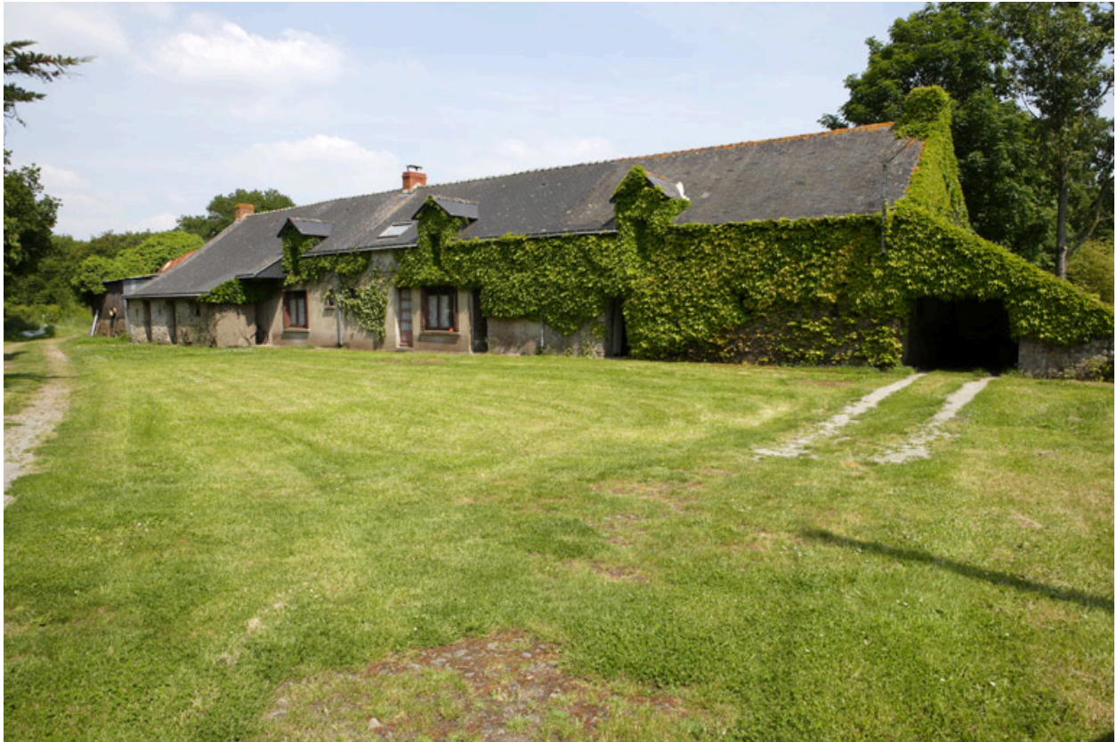
Vue d'ensemble de la rangée.
