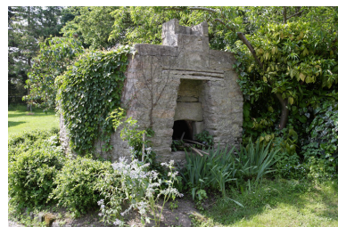
Vue du four à pain. Phot. Denis Pillet IVR52_20084401741NUCA
