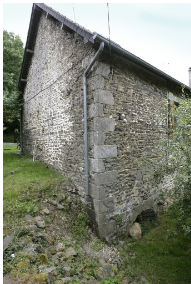
L'angle nord-est du moulin et la sortie du coursier. Phot. François Lasa IVR52_20075300417NUCA
