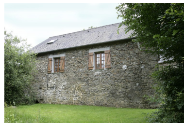
La façade postérieure du moulin vue depuis le nord. Phot. François Lasa IVR52_20075300418NUCA
