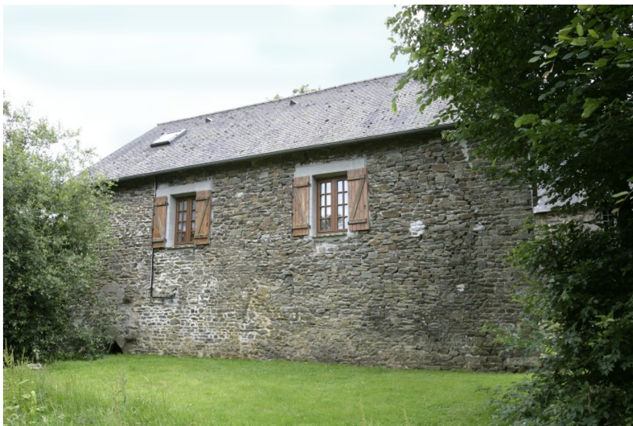
La façade postérieure du moulin vue depuis le nord.
