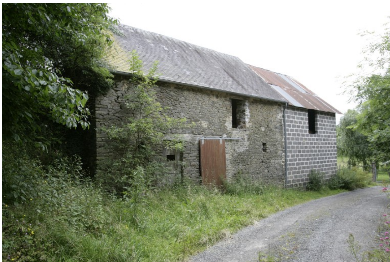
L'étable-écurie-grange vue depuis le chemin au nord-est.
