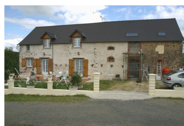
L'ancienne étable- grange vue depuis le sud. Phot. François Lasa IVR52_20035301726NUCA
