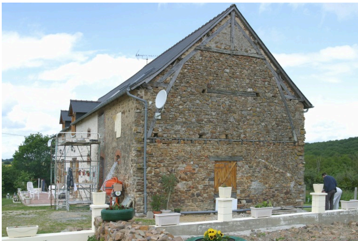
L'ancienne étable-grange vue depuis le sud-est.
