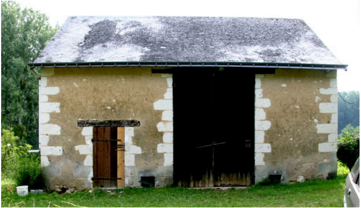
La grange : façade antérieure.
