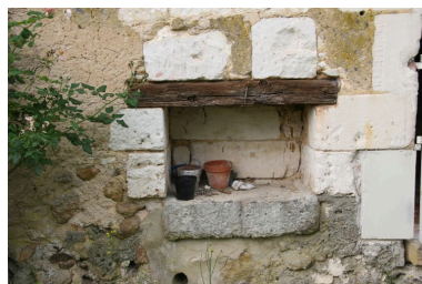
La maison, détail : niche ouverte vers l'extérieur. Phot. Jean-Baptiste Darrasse IVR52_20077201542NUCA
