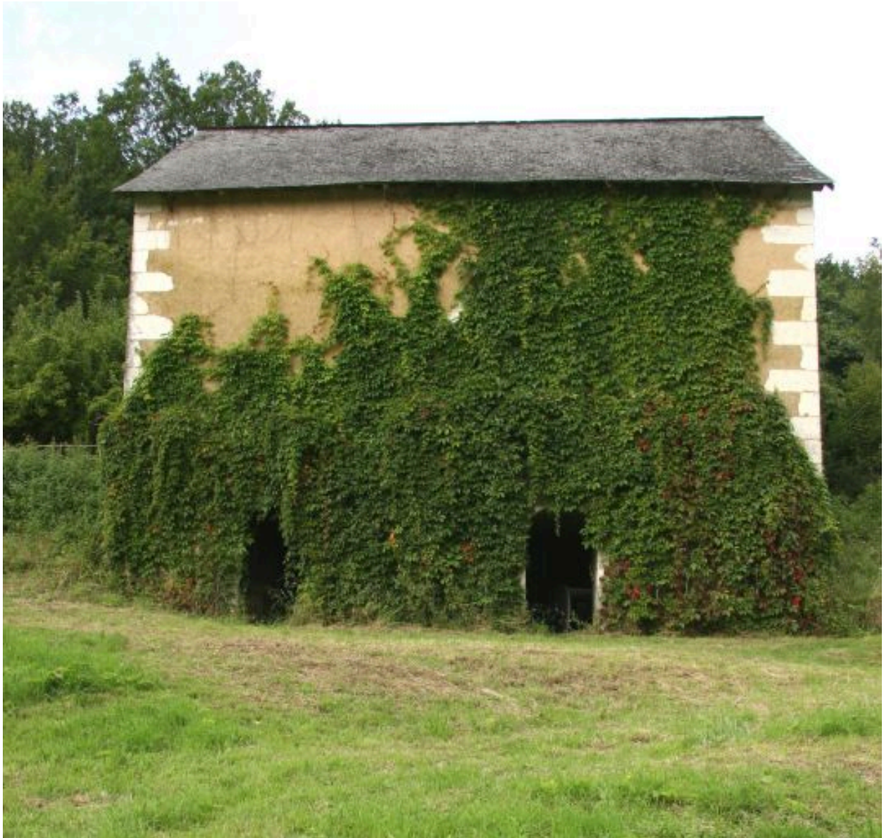
La grange, face postérieure : deux entrées de caves transversales.
