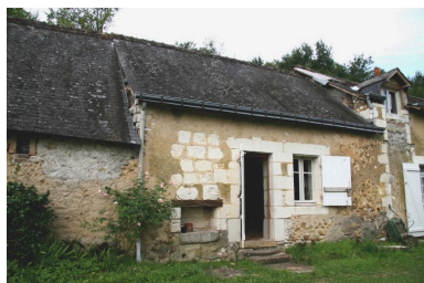
La maison, détail. Phot. Jean-Baptiste Darrasse IVR52_20077201541NUCA
