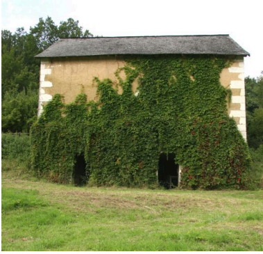
La grange, face postérieure : deux entrées de caves transversales. Phot. Jean-Baptiste Darrasse IVR52_20077201544NUCA
