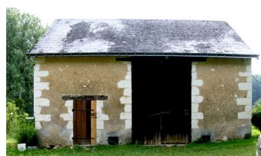
La grange : façade antérieure. Phot. Jean-Baptiste Darrasse IVR52_20077201546NUCA
