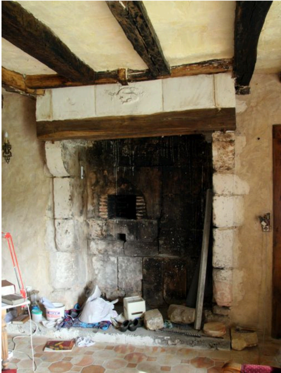
La maison, première salle : cheminée.
