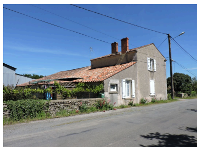
Les anciennes dépendances en appentis à l'arrière du logis, vues depuis le nord-ouest. Phot. Yannis Suire IVR52_20198501485NUCA
