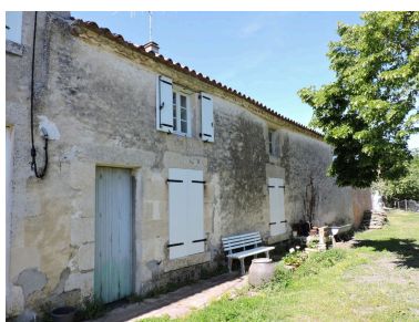
La partie du logis construite en 1850. Phot. Yannis Suire IVR52_20198501483NUCA
