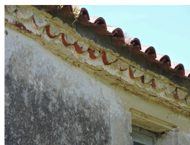
Détail de la génoise. Phot. Yannis Suire IVR52_20198501484NUCA
