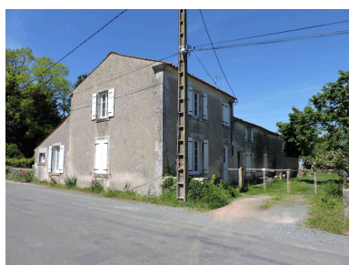
L'ancienne ferme vue depuis le sud. Phot. Yannis Suire IVR52_20198501482NUCA
