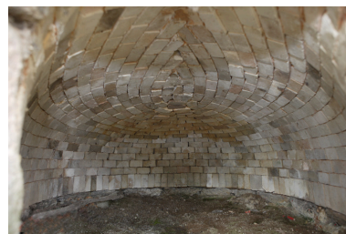
Détail de l'intérieur du four. Phot. Denis Pillet IVR52_20084401649NUCA
