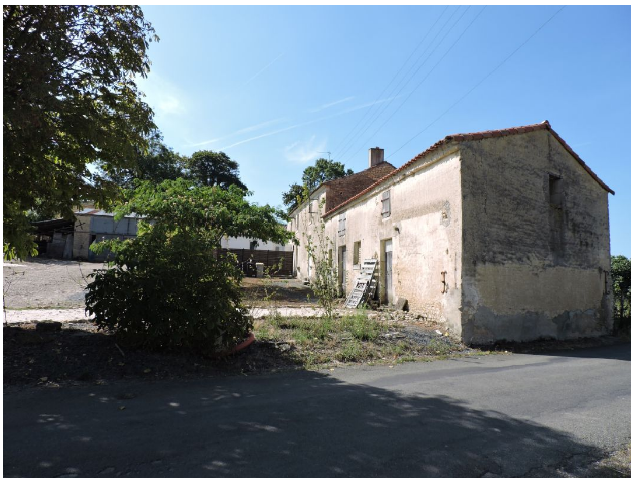
L'ancienne ferme vue depuis le nord-est.
