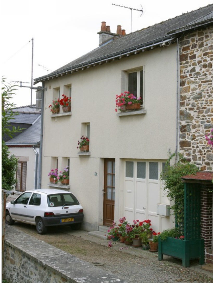
Façade sur rue du corps de bâtiment est.
