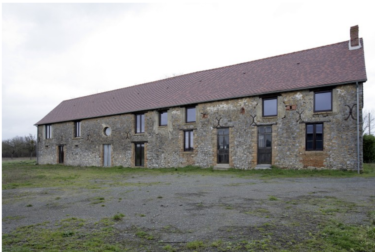
Vue d'ensemble depuis la cour au sud.
