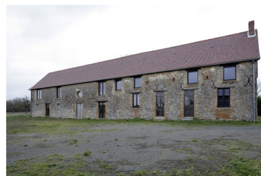
Vue d'ensemble depuis la cour au sud. Phot. François Lasa IVR52_20075301325NUCA
