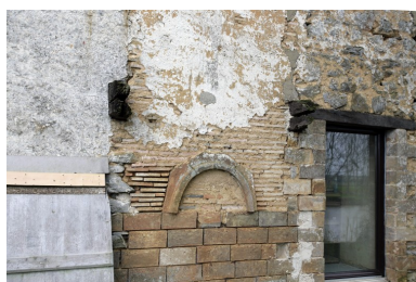
Détail de la façade postérieure : les vestiges du four à pain Phot. François Lasa IVR52_20075301326NUCA
