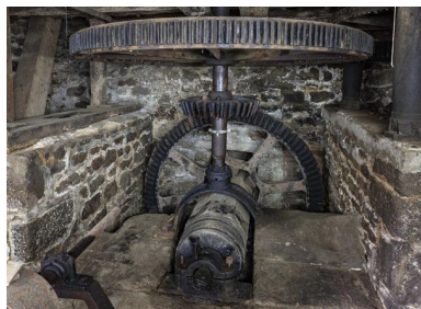
Soubassement, roues et arbres de transmission. Phot. Yves Guillotin IVR52_20205300275NUCA
