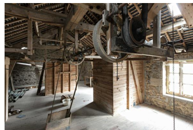
Etage de comble. Phot. Yves Guillotin IVR52_20205300270NUCA
