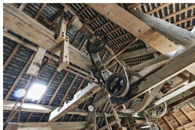
Courroies et axe de transmission, niveau de comble. Phot. Yves Guillotin IVR52_20205300269NUCA
