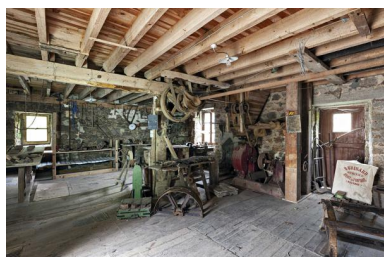
Rez-de-chaussée. Phot. Yves Guillotin IVR52_20205300262NUCA
