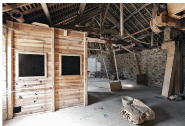
Magasin à farine, étage de comble. Phot. Yves Guillotin IVR52_20205300267NUCA
