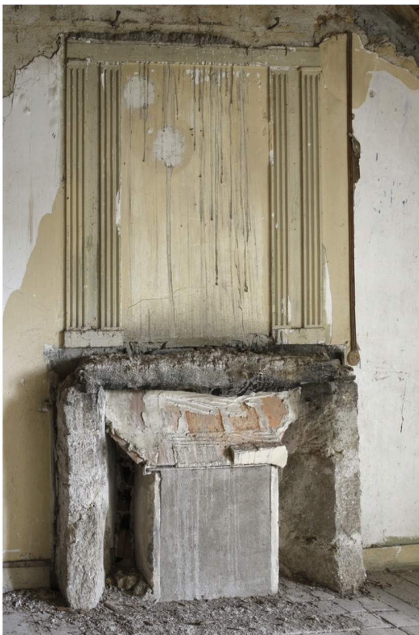
Logis. Aile nord. Étage de comble. Détail de la cheminée du pignon nord.
