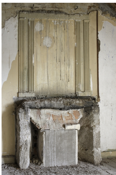
Logis. Aile nord. Étage de comble. Détail de la cheminée du pignon nord. Phot. Denis Pillet IVR52_20094400192NUCA
