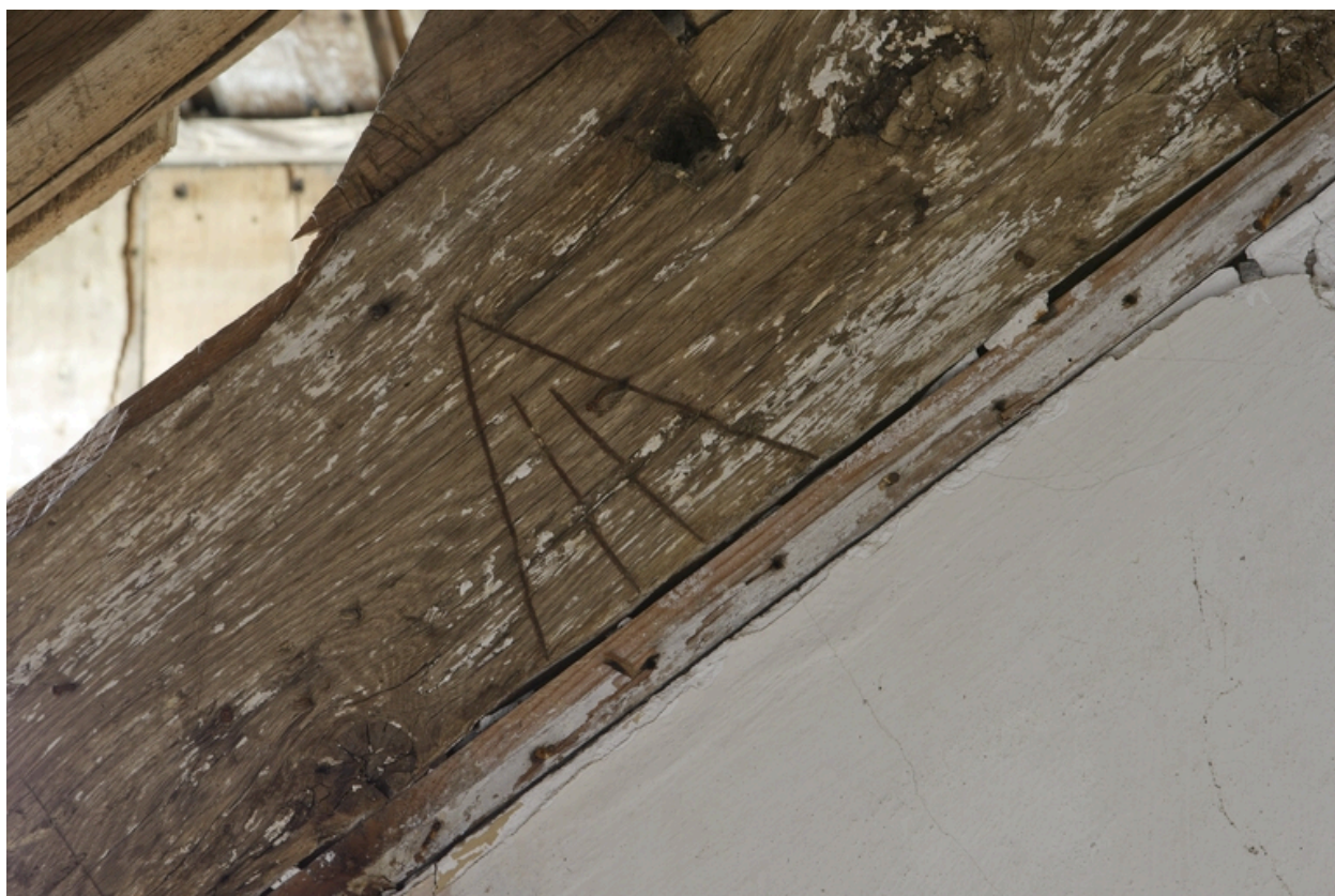
Logis. Aile nord. Étage de comble. Charpente. Marque d'assemblage.
