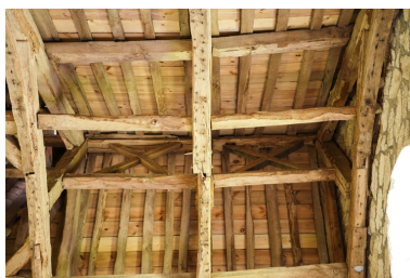
Chapelle. Détail de la charpente. Phot. Denis Pillet IVR52_20094400200NUCA
