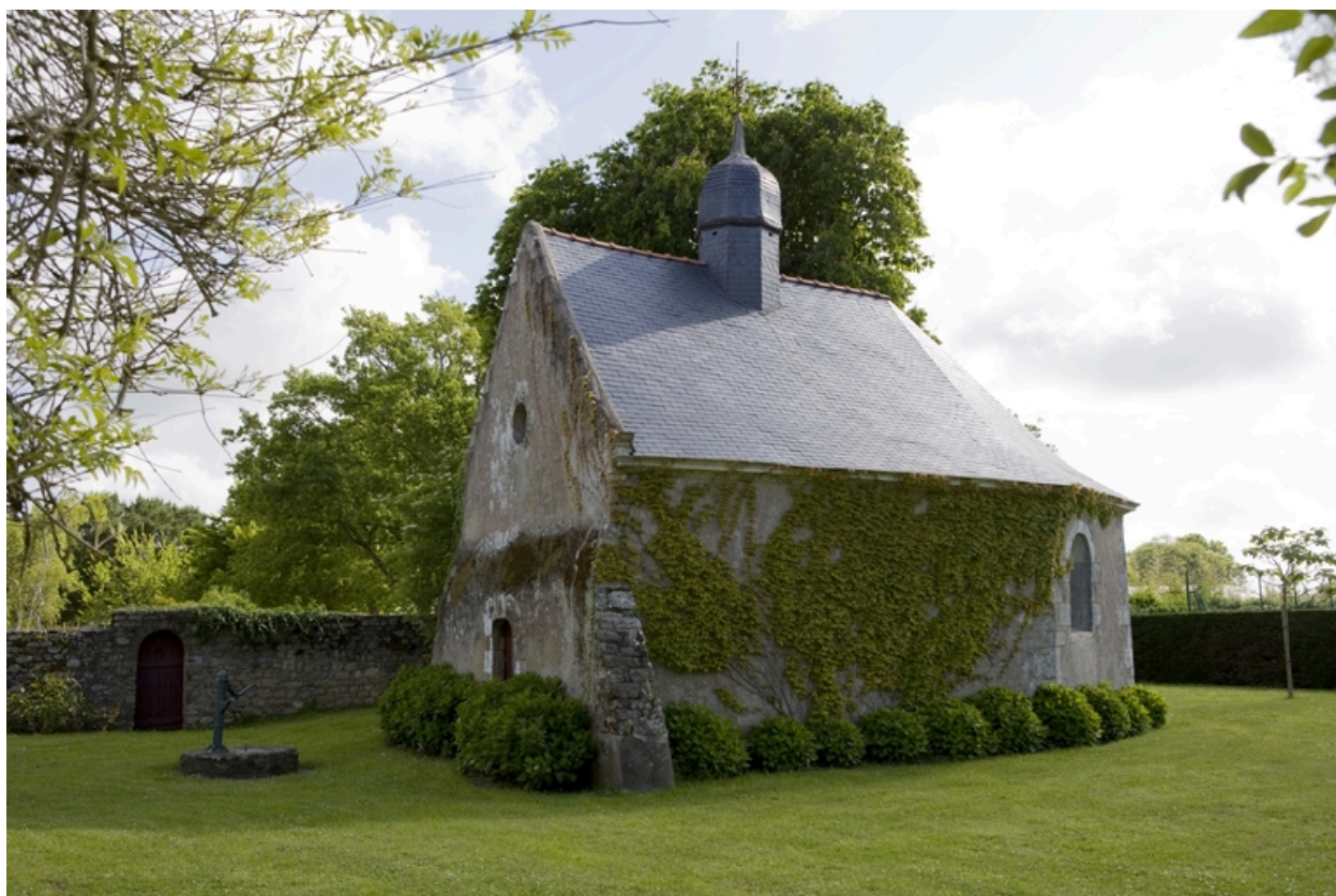
Chapelle. Vue d'ensemble depuis le sud.
