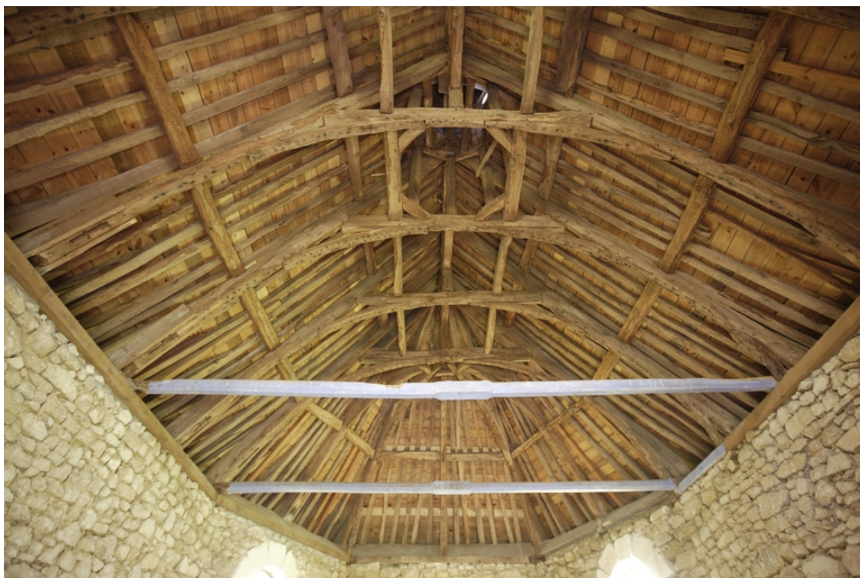
Chapelle. Vue de la charpente depuis l'ouest.
