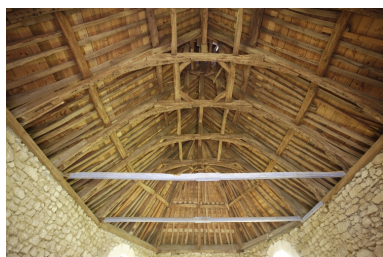
Chapelle. Vue de la charpente depuis l'ouest. Phot. Denis Pillet IVR52_20094400199NUCA
