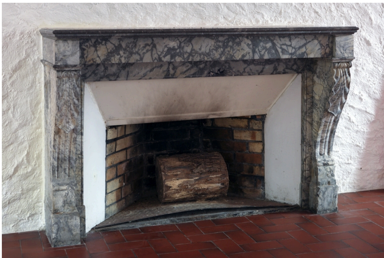
Logis. Aile sud. Détail de la cheminée du pignon est.
