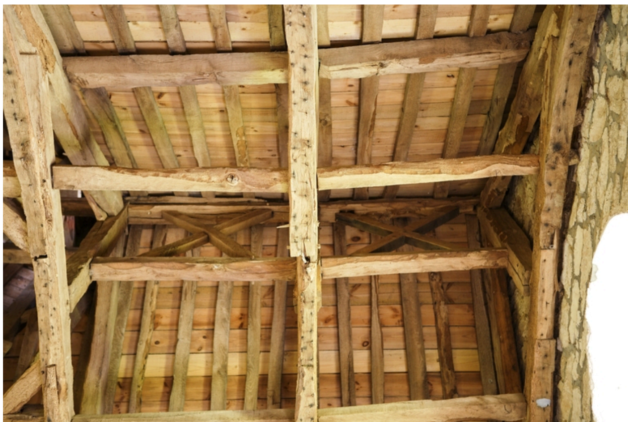
Chapelle. Détail de la charpente.
