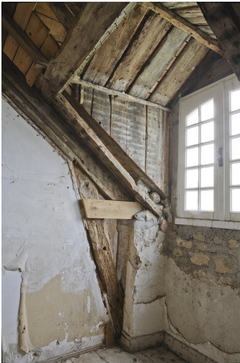
Logis. Aile nord. Étage de comble. Détail de la charpente.
