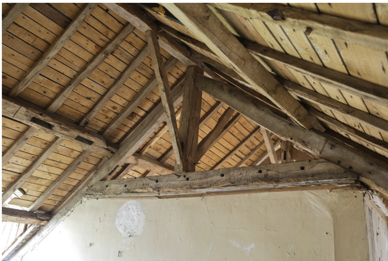
Logis. Aile nord. Étage de comble. Charpente. Détail d'une ferme.
