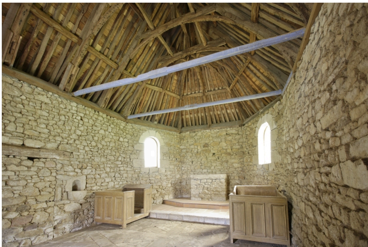
Chapelle. Vue de l'intérieur depuis l'ouest.
