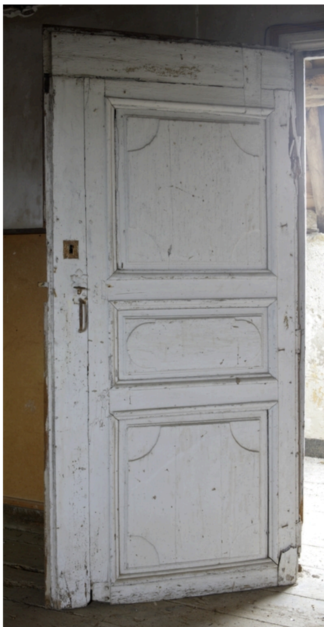
Logis. Aile nord. Étage de comble. Détail d'une porte remployée dans le comble.
