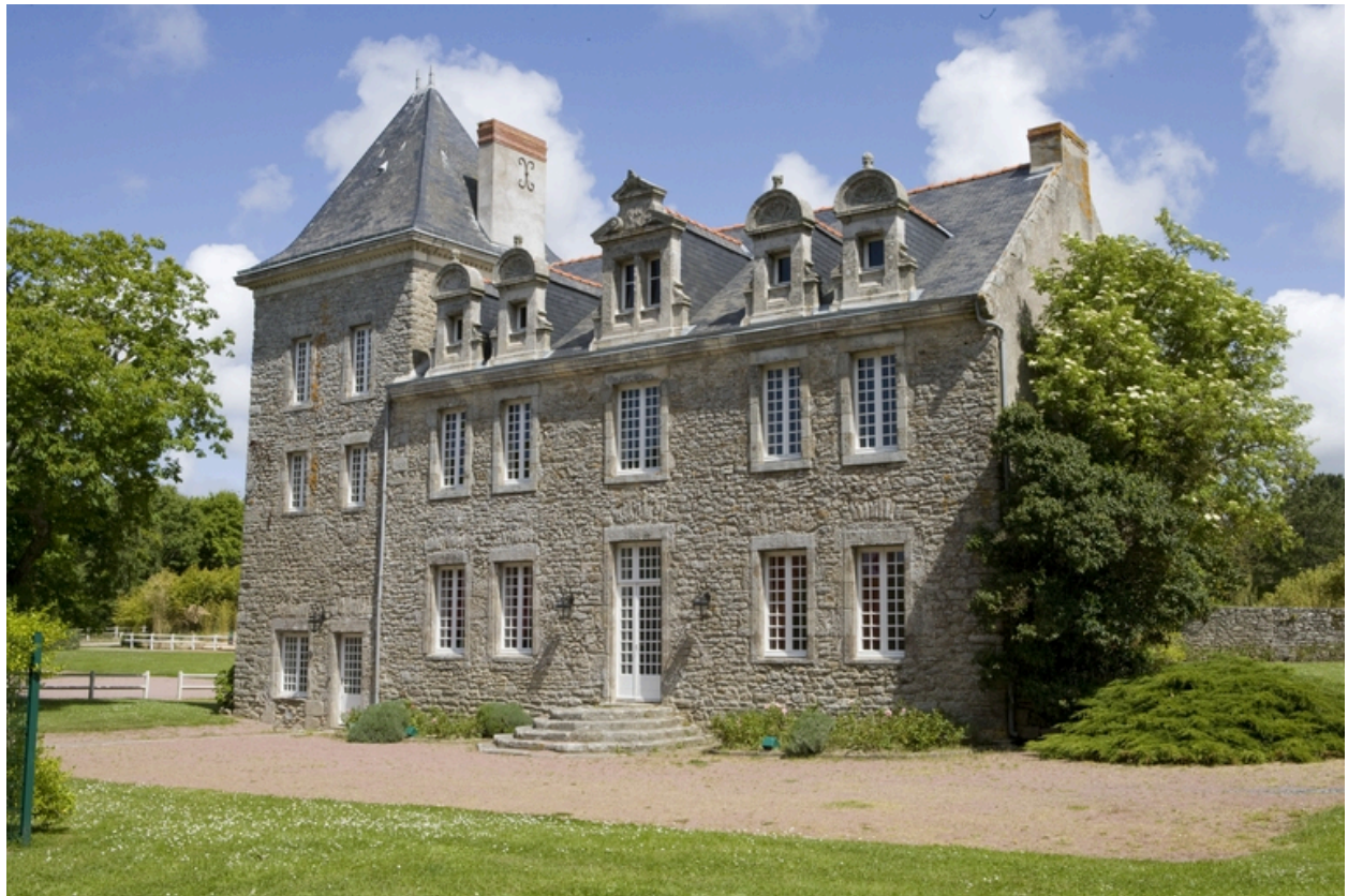
Logis. Vue de la façade sud.
