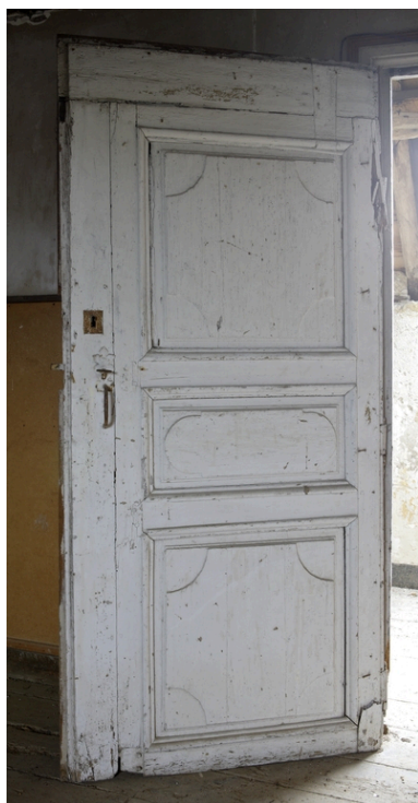
Logis. Aile nord. Étage de comble. Détail d'une porte remployée dans le comble. Phot. Denis Pillet IVR52_20094400197NUCA
