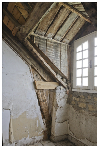
Logis. Aile nord. Étage de comble. Détail de la charpente. Phot. Denis Pillet IVR52_20094400196NUCA
