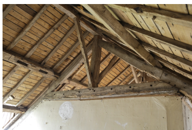
Logis. Aile nord. Étage de comble. Charpente. Détail d'une ferme. Phot. Denis Pillet IVR52_20094400193NUCA
