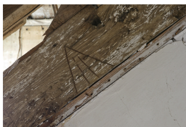
Logis. Aile nord. Étage de comble. Charpente. Marque d'assemblage. Phot. Denis Pillet IVR52_20094400195NUCA
