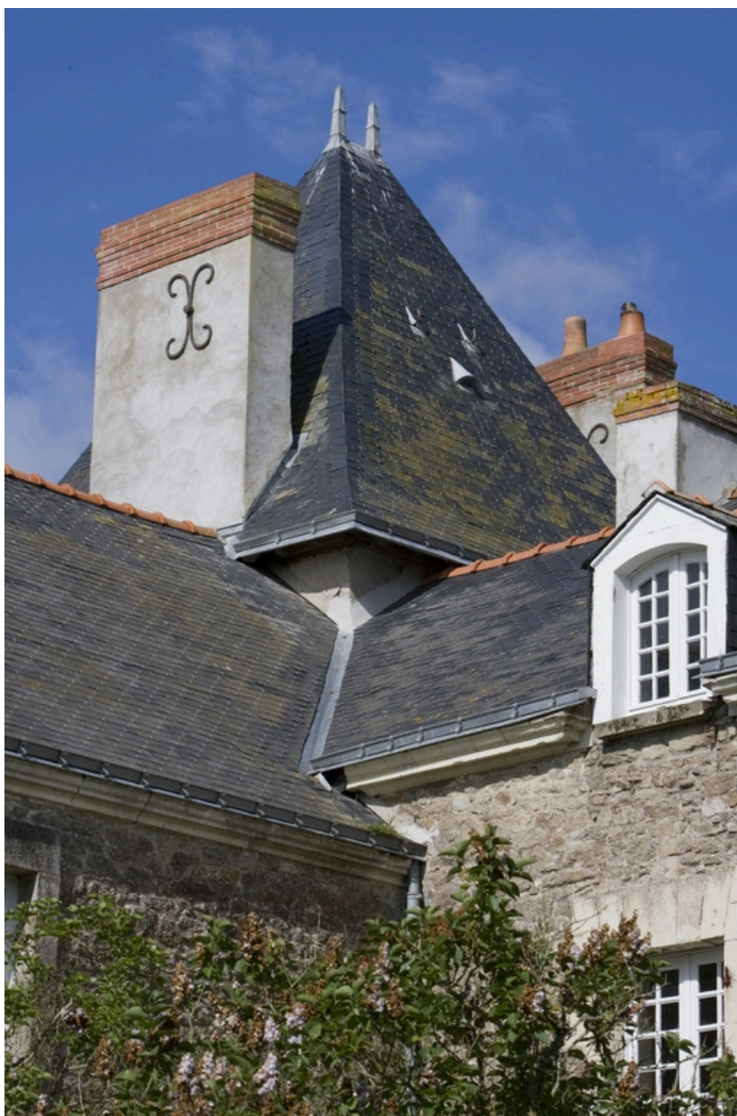
Logis. Détail des pentes de toits dans l'angle nord-est.
