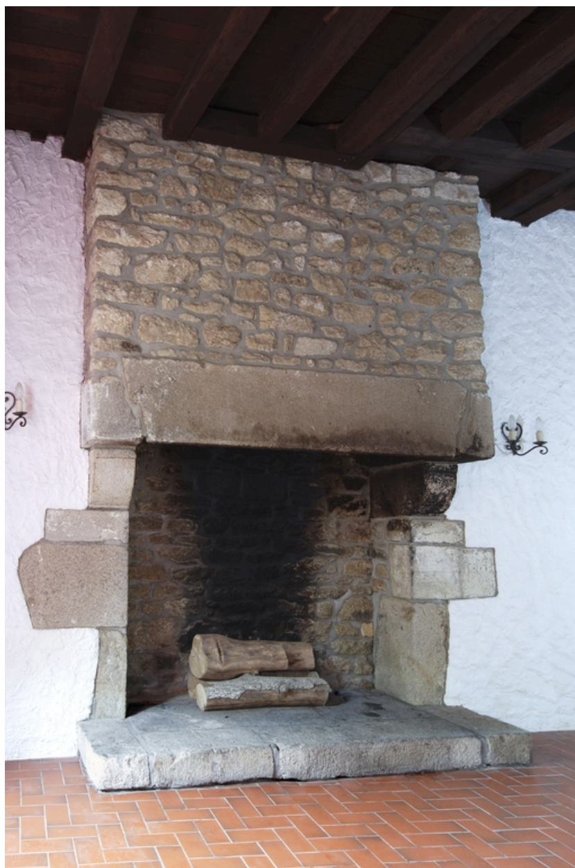
Logis. Aile sud. Détail de la cheminée de la salle ouest du rez-de-chaussée.
