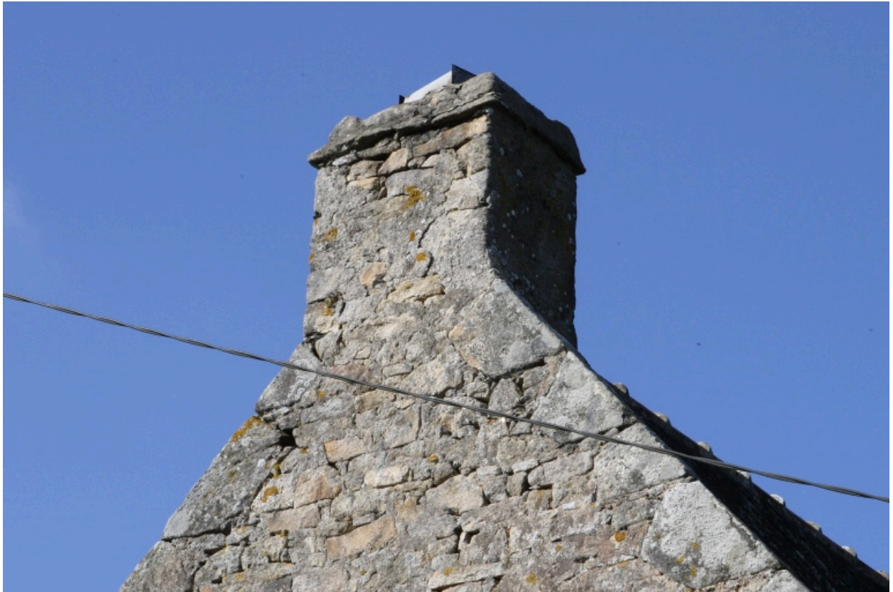
Détail de la souche de la cheminée.
