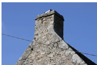
Détail de la souche de la cheminée. Phot. Denis Pillet IVR52_20074401324NUCA
