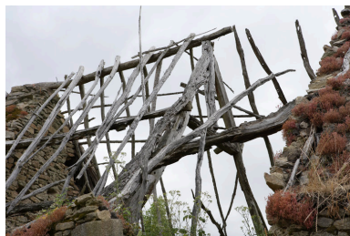
Détail de la charpente. Phot. Denis Pillet IVR52_20084401965NUCA
