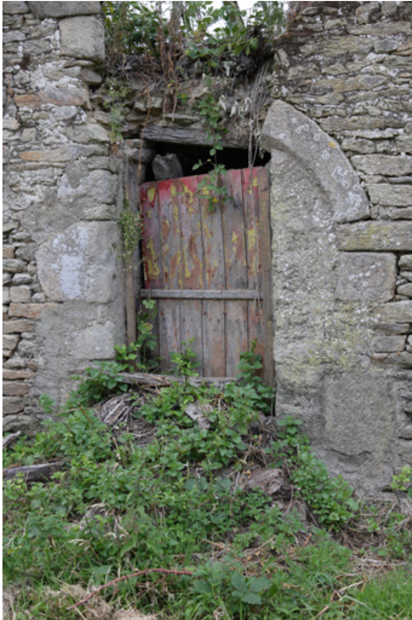
Détail de la porte sud de la façade ouest.
