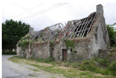
Vue d'ensemble depuis le sud-ouest. Phot. Denis Pillet IVR52_20084401962NUCA
