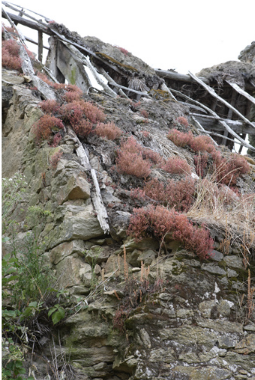
Détail de l'angle du nord-ouest du pignon nord.
