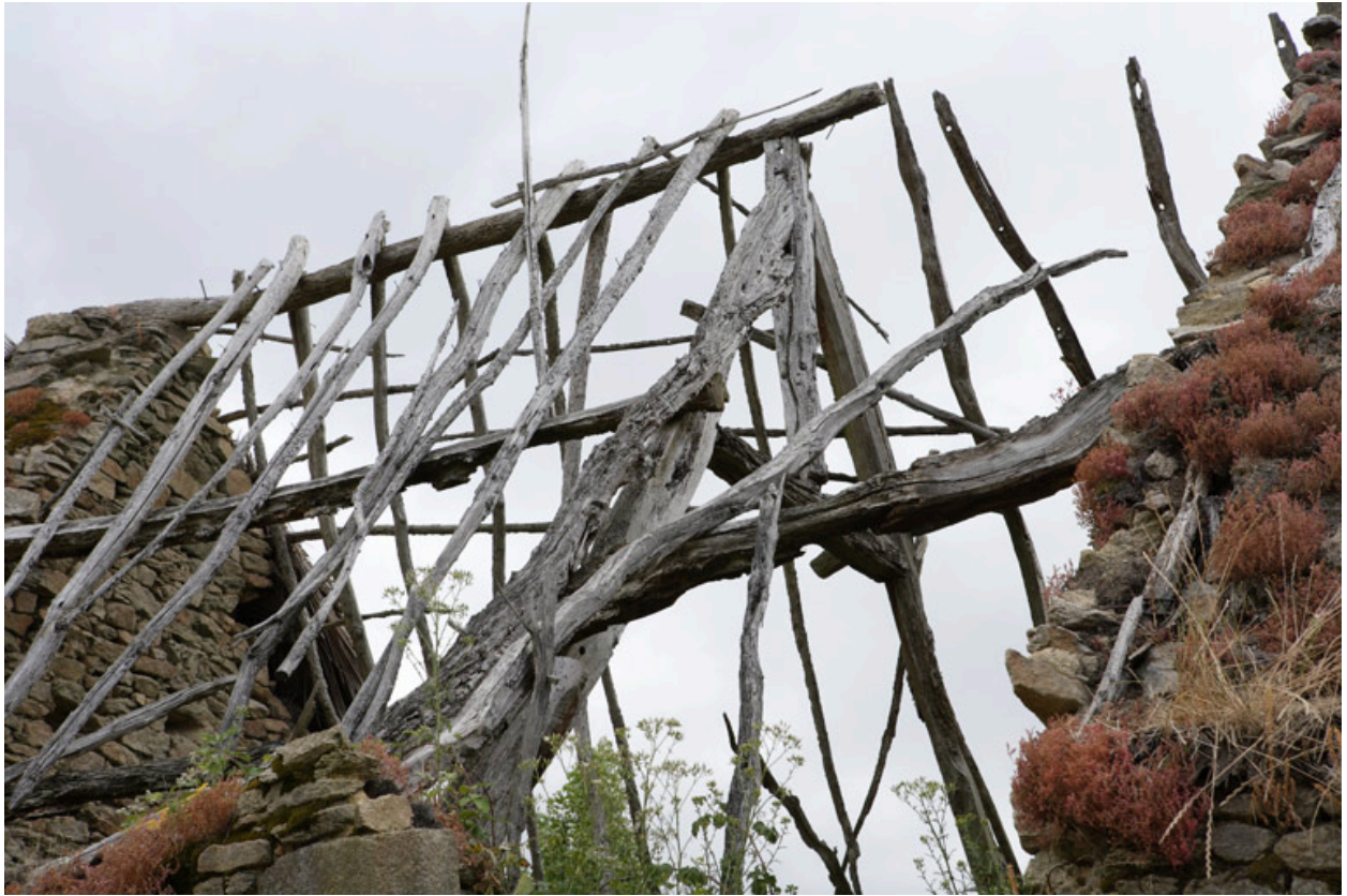
Détail de la charpente.
