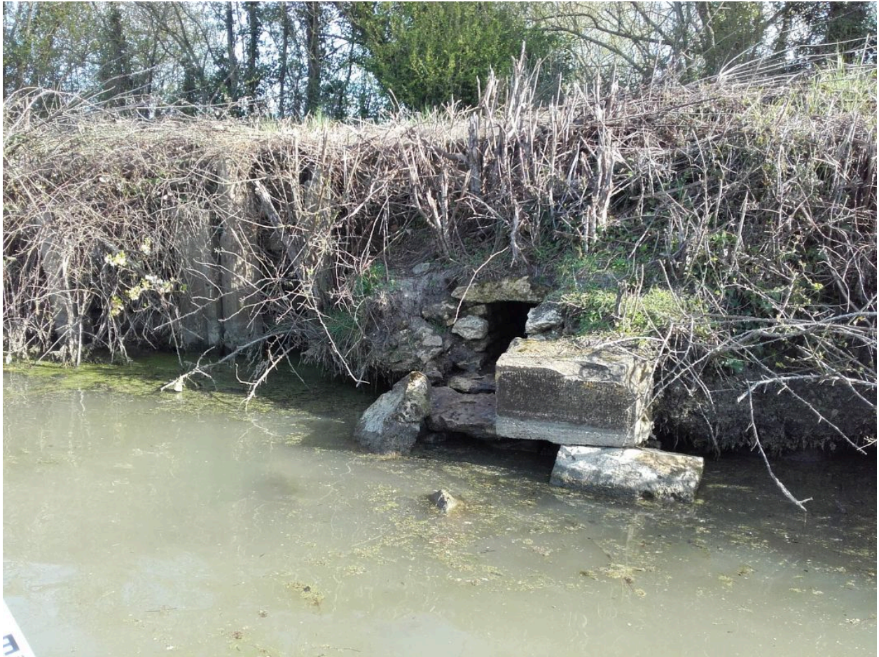
La bonde côté aval, au sud.
