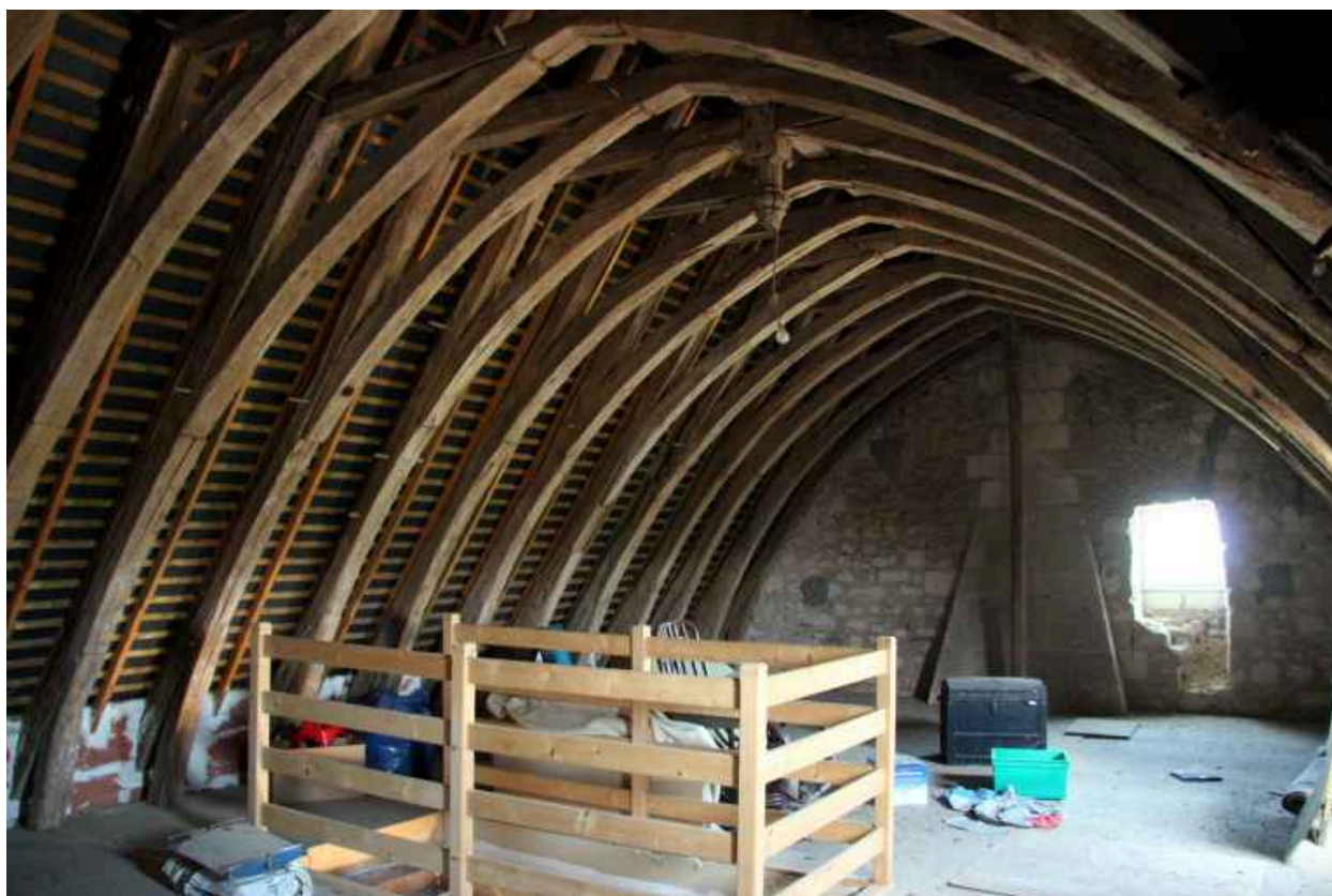
Le logis : charpente à chevron-portant-ferme.
