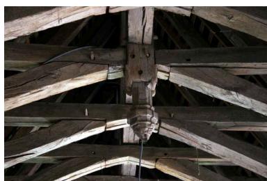
Le logis, charpente : détail. Phot. Jean-Baptiste Darrasse IVR52_20067205952NUCA
