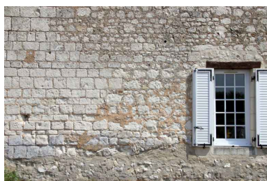
Le logis, façade sur rue : mise en oeuvre des matériaux. Phot. Jean-Baptiste Darrasse IVR52_20067205968NUCA
