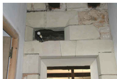
Le logis, pignon O. : vestige d'une baie. Phot. Jean-Baptiste Darrasse IVR52_20067205948NUCA
