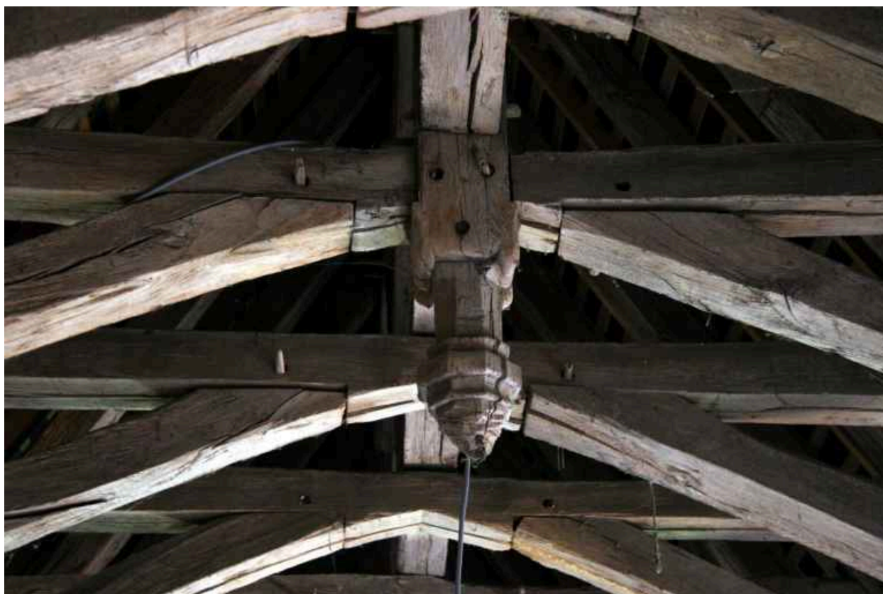
Le logis, charpente : détail.
