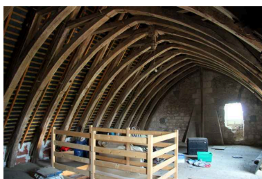
Le logis : charpente à chevron-portant-ferme. Phot. Jean-Baptiste Darrasse IVR52_20067205951NUCA
