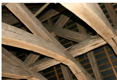
Le logis, la charpente : potelet de décharge en croix-de-Saint-André. Phot. Jean-Baptiste Darrasse IVR52_20067205954NUCA
