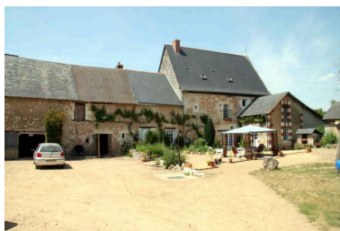
Vue d'ensemble sur la cour. Phot. Jean-Baptiste Darrasse IVR52_20067205944NUCA
