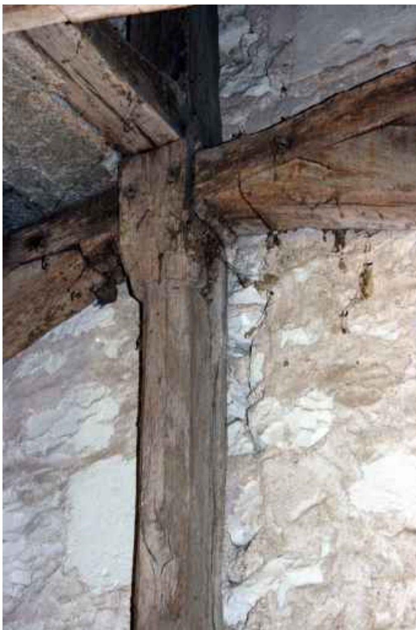
Le logis, charpente : assemblage.
