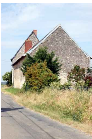
Vue de volume. Phot. Jean-Baptiste Darrasse IVR52_20067205971NUCA
