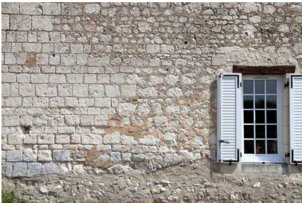
Le logis, façade sur rue : mise en oeuvre des matériaux.
