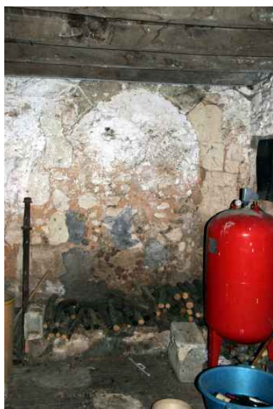
Le logis, pignon mitoyen de l'annexe : porte. Phot. Jean-Baptiste Darrasse IVR52_20067205964NUCA
