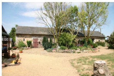
Toits à porcs. Phot. Jean-Baptiste Darrasse IVR52_20067205965NUCA
