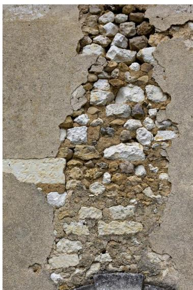
Communs : détail de la maçonnerie sous l'enduit.
