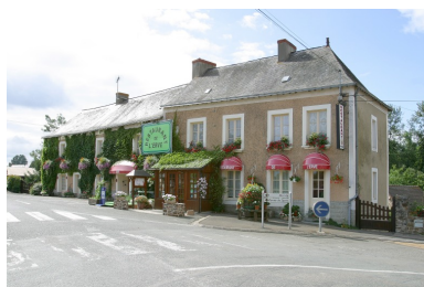
Façade sur rue vue depuis le nord-est. Phot. François Lasa IVR52_20035302333NUCA
