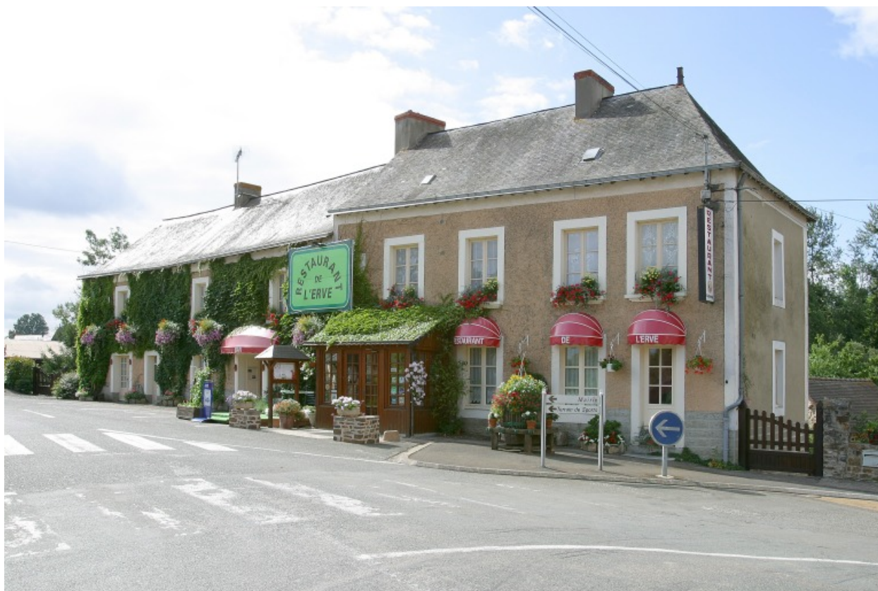
Façade sur rue vue depuis le nord-est.
