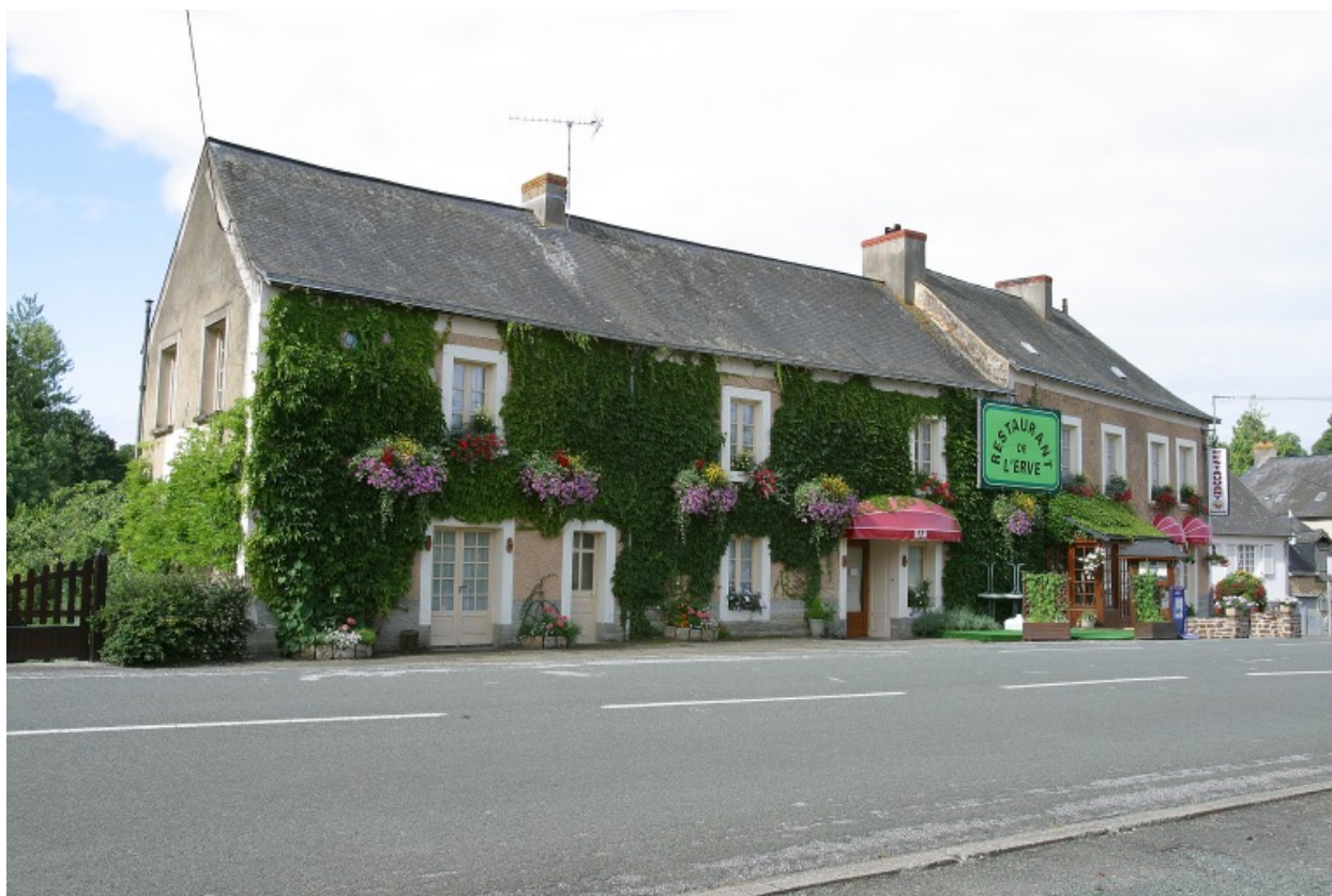
Façade sur rue vue depuis le nord-ouest.
