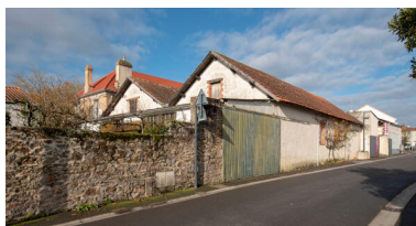
Vue générale des magasin sud. Phot. Pierre-Bernard Fourny IVR52_20224400400NUCA
