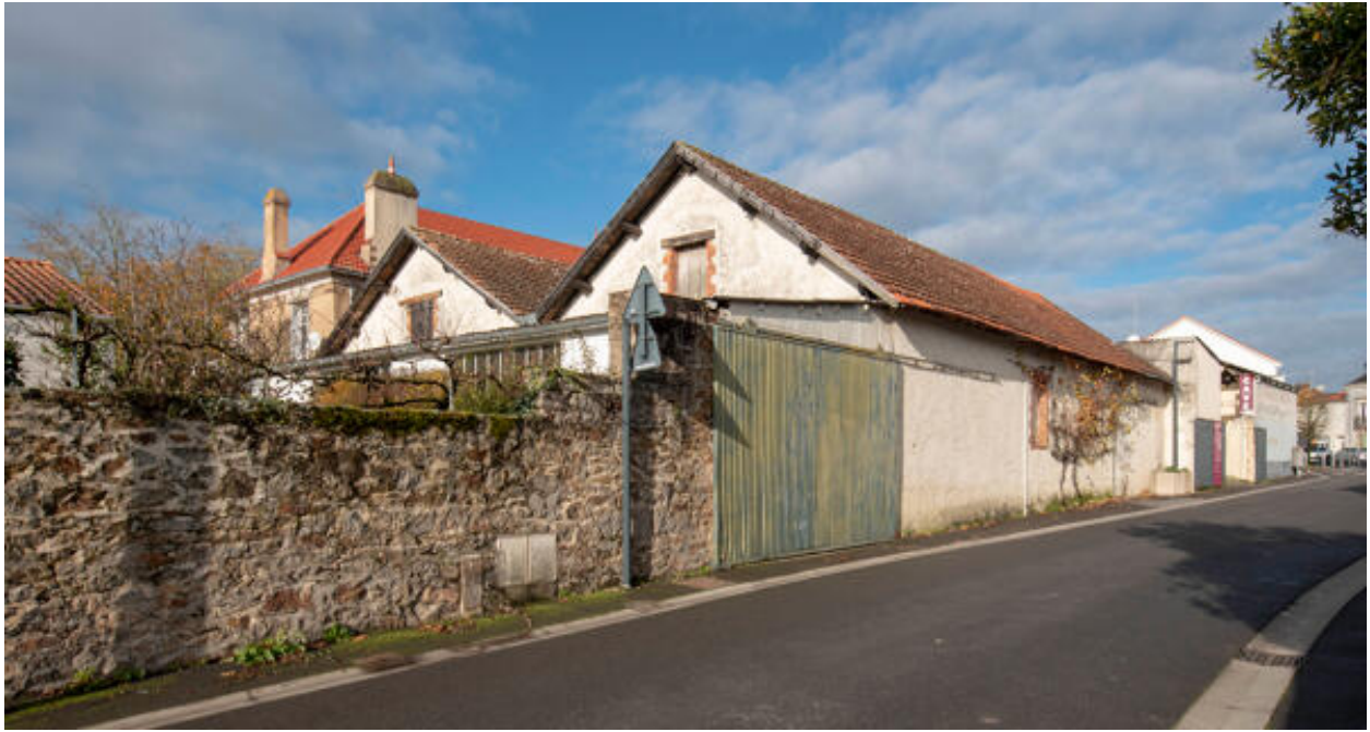
Vue générale des magasin sud.
