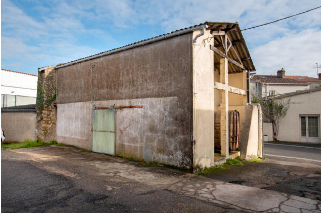
Vue générale du magasin nord ; accès à la cuverie.
