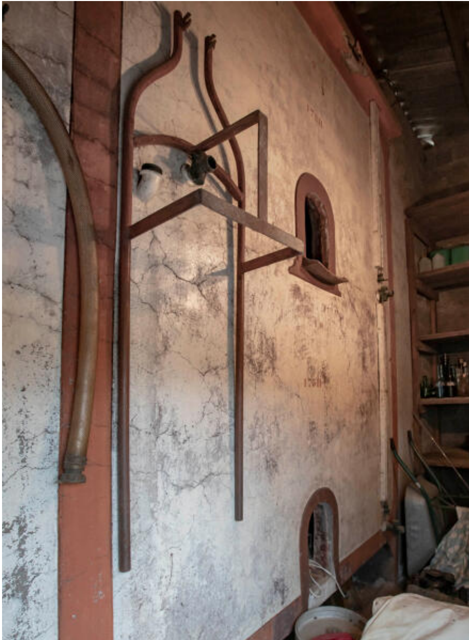
Cuve aérienne, magasin nord.
