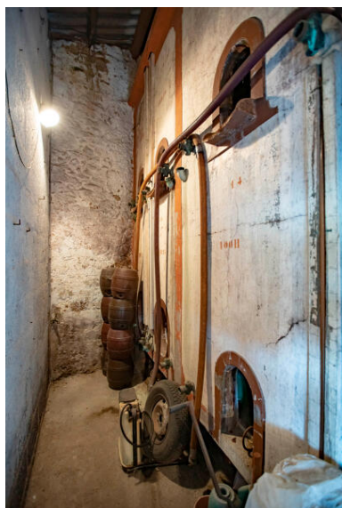
Cuves aériennes et leur couloir de service. Phot. Pierre-Bernard Fourny IVR52_20224400379NUCA
