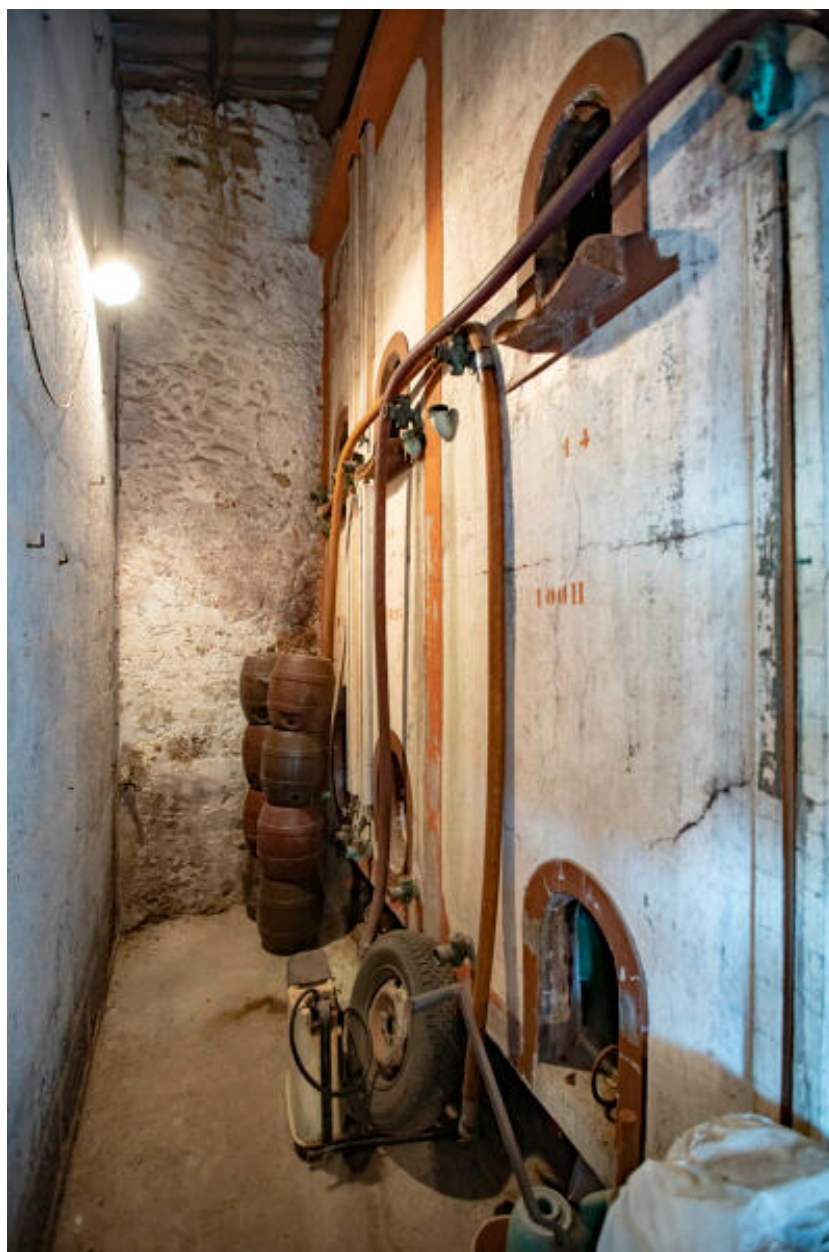
Cuves aériennes et leur couloir de service.
