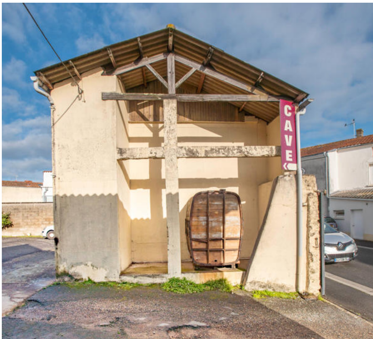
Vue générale du magasin nord et de sa structure béton.
