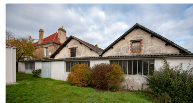
Pignons sud des magasins à vin. Phot. Pierre-Bernard Fourny IVR52_20224400389NUCA
