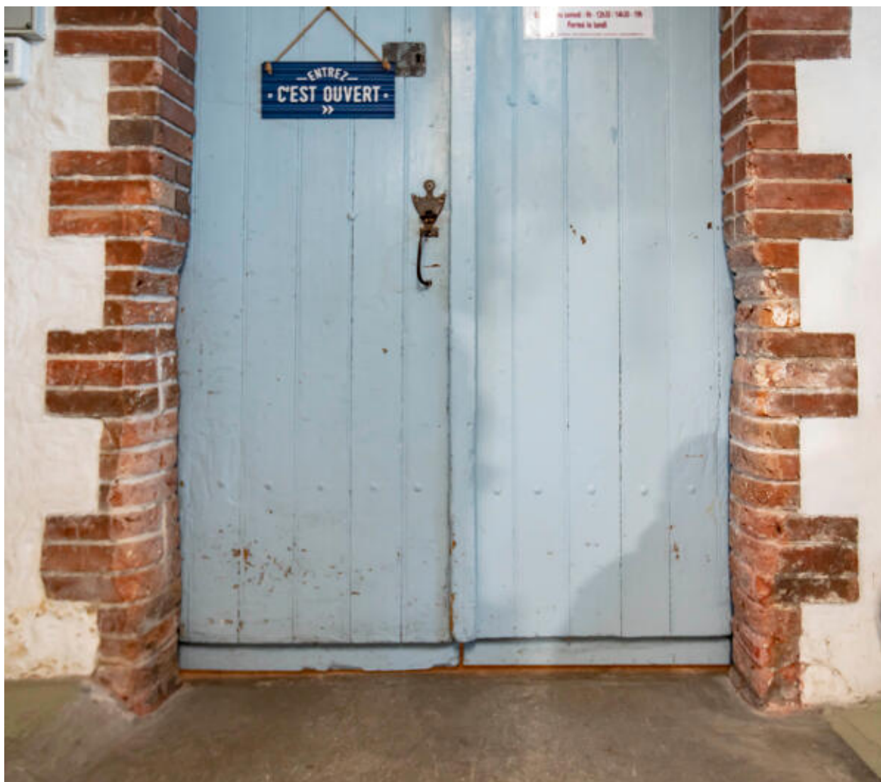
Détail de la partie basse de la porte d'entrée des magasins, élargie pour faciliter le passage des fûts.
