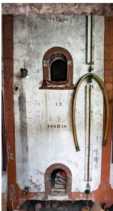
Cuve aérienne, magasin nord. Phot. Pierre-Bernard Fourny IVR52_20224400380NUCA
