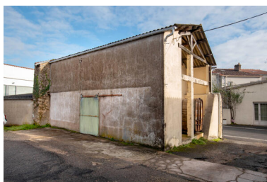
Vue générale du magasin nord ; accès à la cuverie. Phot. Pierre-Bernard Fourny IVR52_20224400403NUCA
