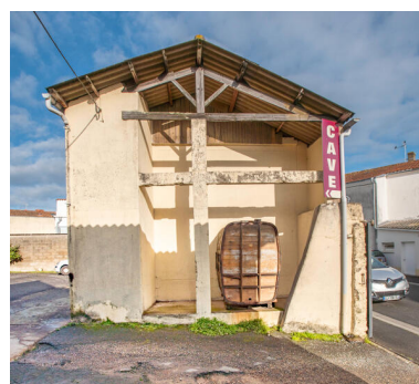
Vue générale du magasin nord et de sa structure béton. Phot. Pierre-Bernard Fourny IVR52_20224400396NUCA
