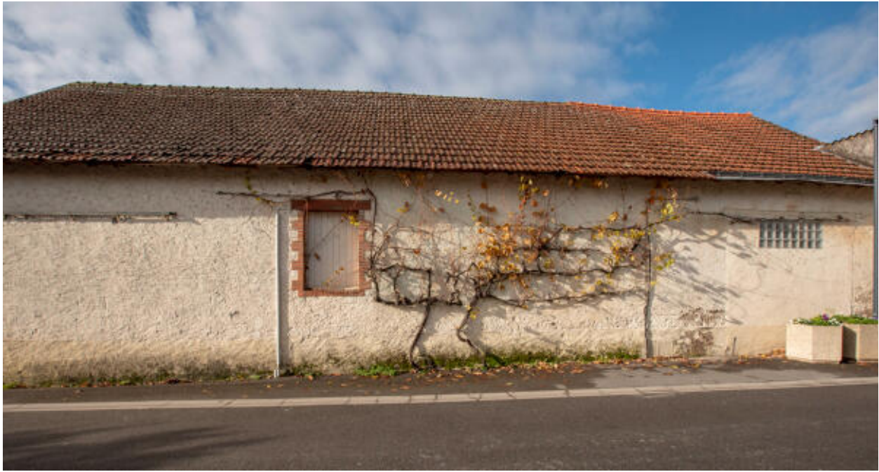
Vue des magasins sud depuis la rue de Vieillevigne ; porte à vendange.
