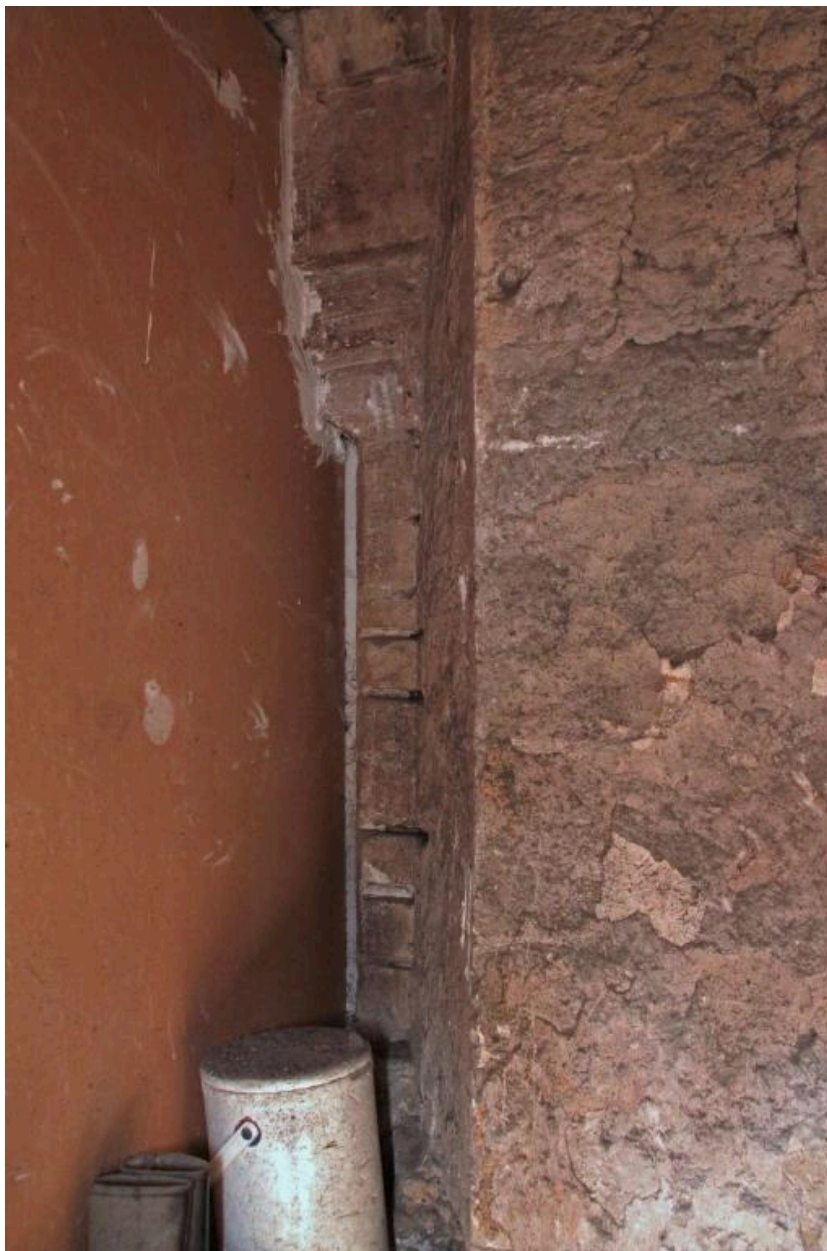
Etage : vestiges d'une cheminée ancienne.
