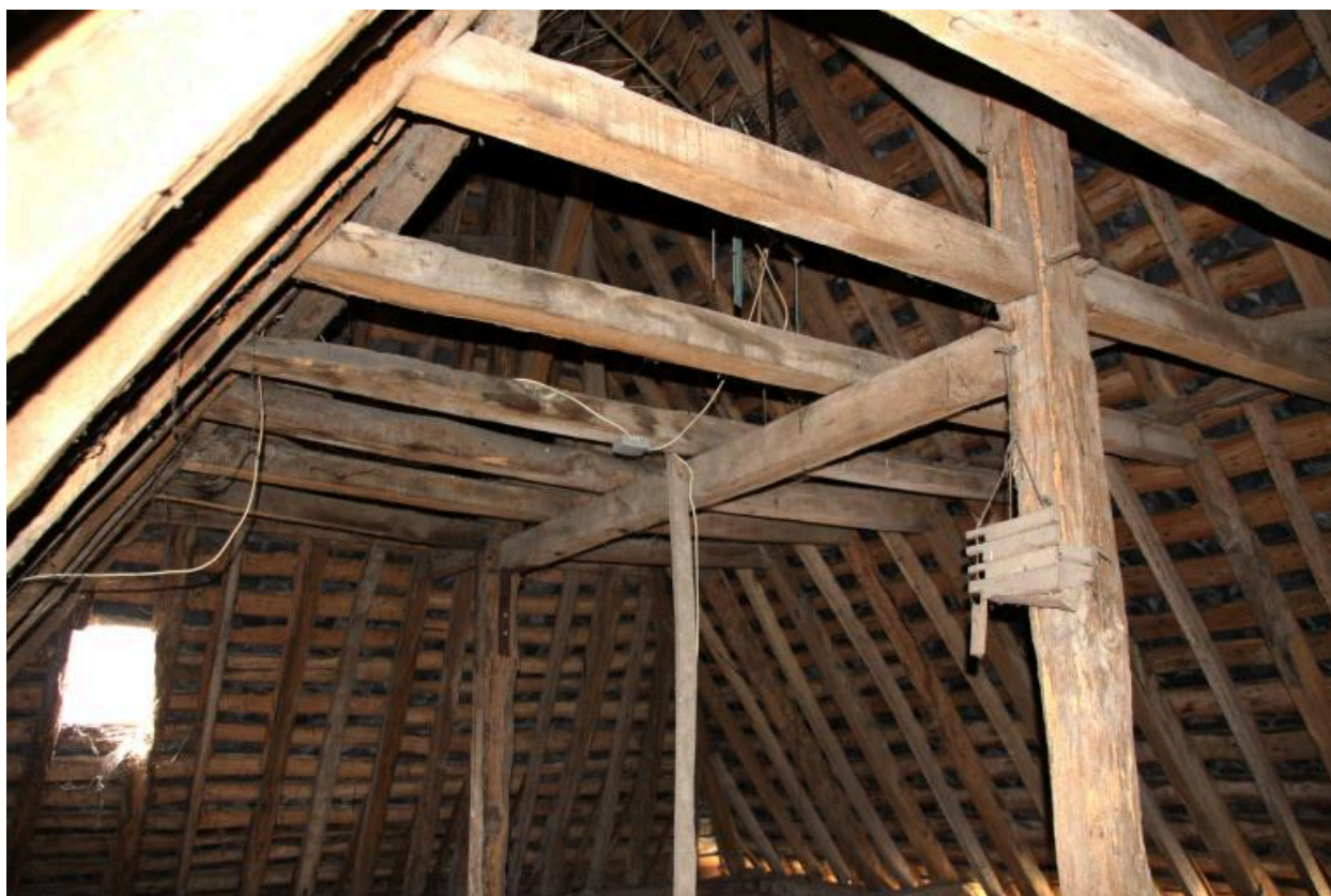
Détail de la charpente.
