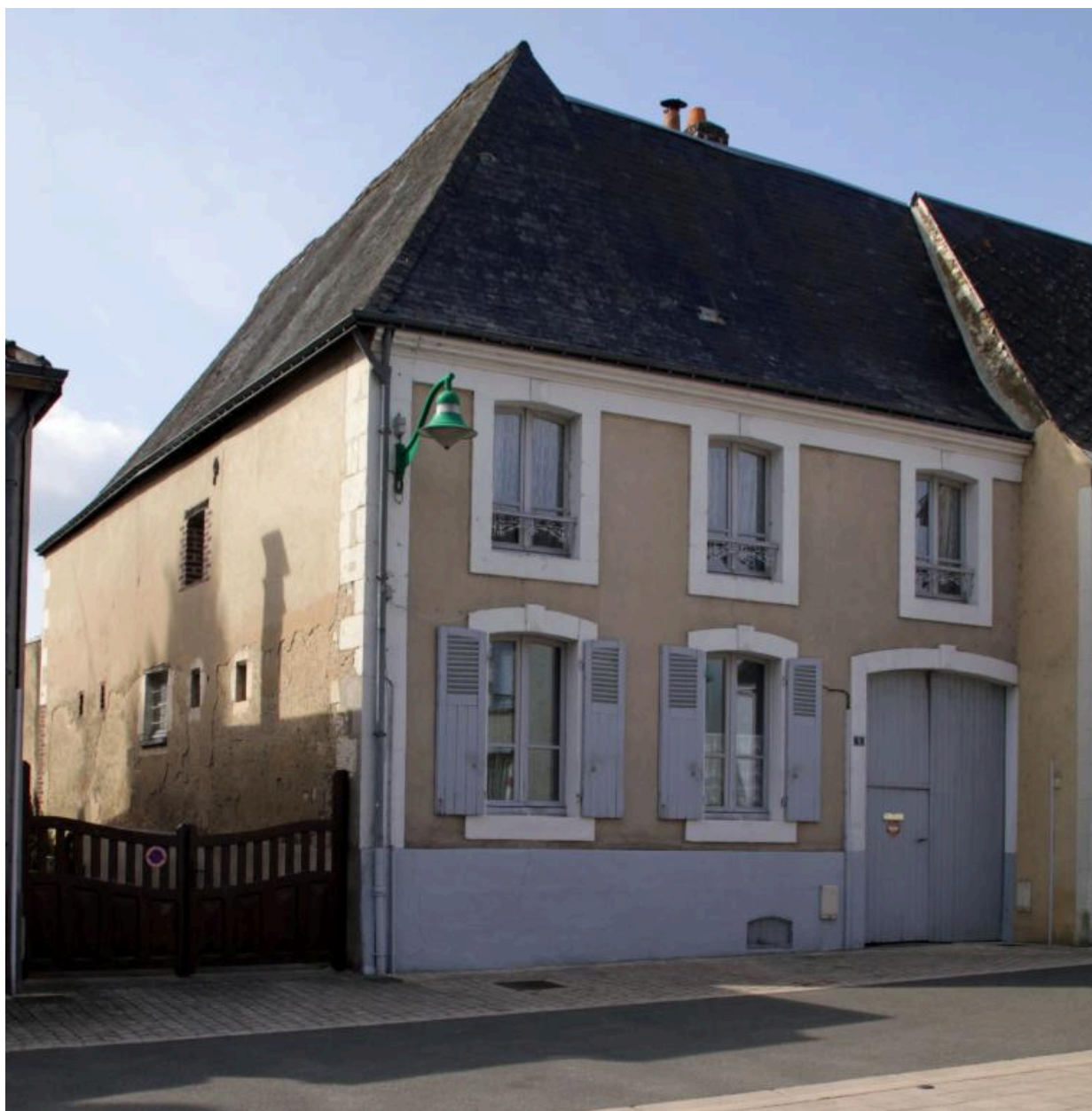
Vue de volume de la maison.
