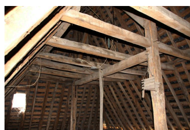
Détail de la charpente. Phot. Jean-Baptiste Darrasse IVR52_20107201120NUCA
