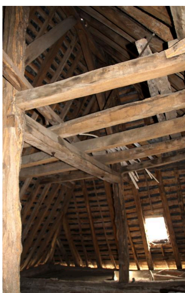
Détail de la charpente. Phot. Jean-Baptiste Darrasse
