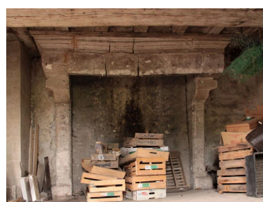
Etage : cheminée. Phot. Jean-Baptiste Darrasse IVR52_20107201118NUCA
