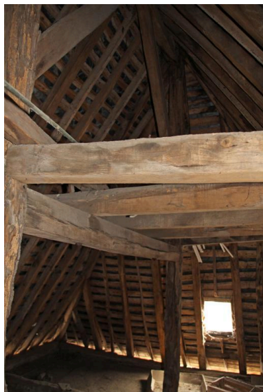
Détail de la charpente. Phot. Jean-Baptiste Darrasse IVR52_20107201121NUCA
