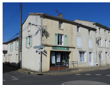
Le bâtiment vu depuis le nord-est. Phot. Yannis Suire IVR52_20198501715NUCA
