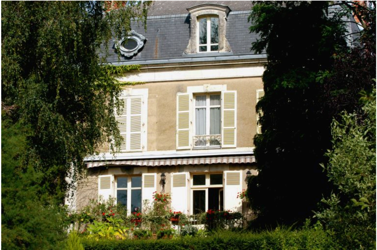
11 rue Basse : détail.
