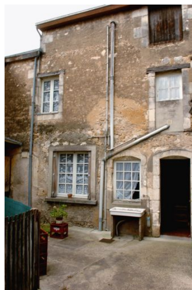
2 place de l'Église : façade postérieure. Phot. David Huard IVR52_20047205557NUCA
