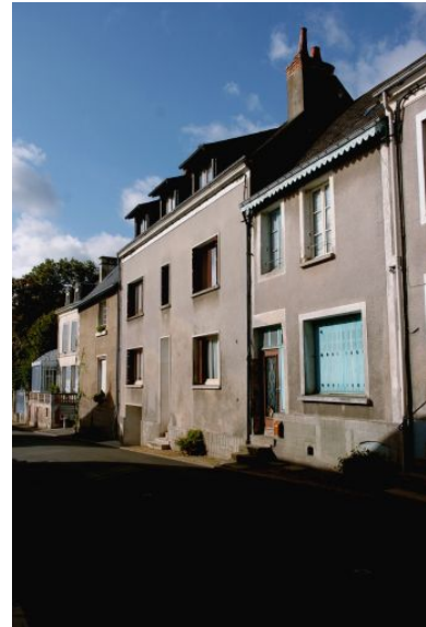
6 à 10 rue des Ponts. Phot. David Huard IVR52_20047205498NUCA
