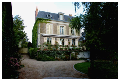
11 rue Basse : vue de volume. Phot. David Huard IVR52_20047205537NUCA
