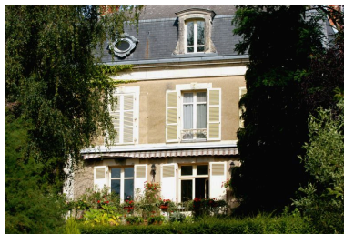
11 rue Basse : détail. Phot. David Huard IVR52_20047205538NUCA
