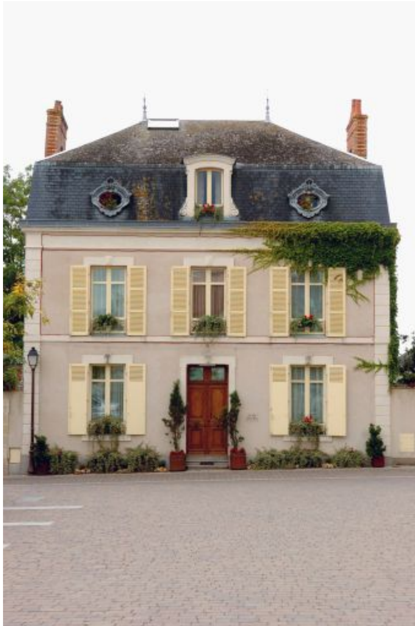
11 rue Basse : façade sur la place.
