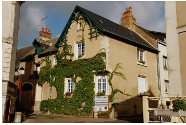
Angle rue Basse et rue des Ponts. Phot. David Huard IVR52_20047205496NUCA
