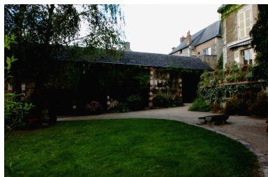
11 rue Basse : dépendances. Phot. David Huard IVR52_20047205540NUCA
