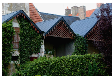
11 rue Basse : dépendances. Phot. David Huard IVR52_20047205539NUCA
