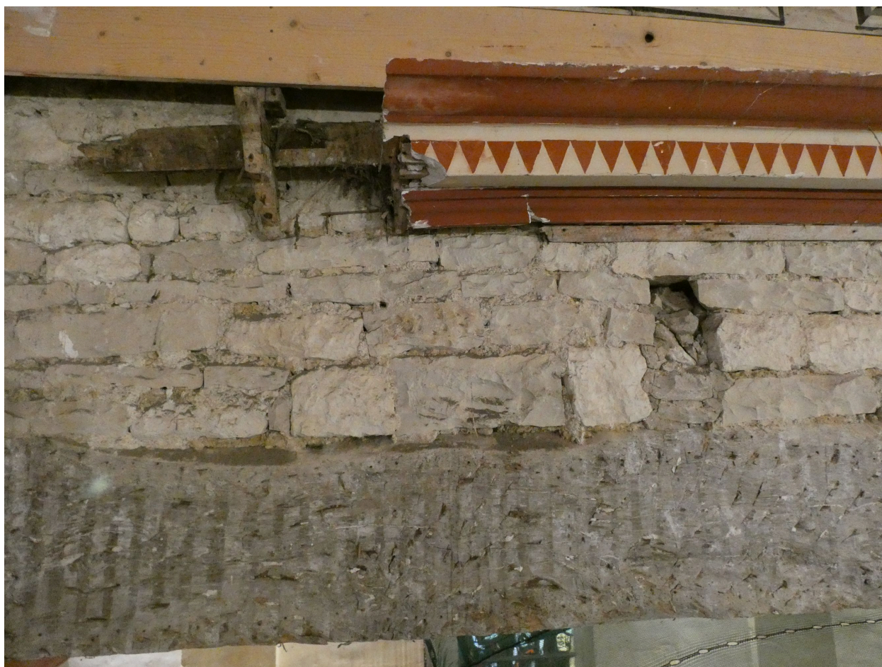
Pierre et bois de l'entablement apparaissant sous le décor en bois, au niveau de la tribune.
