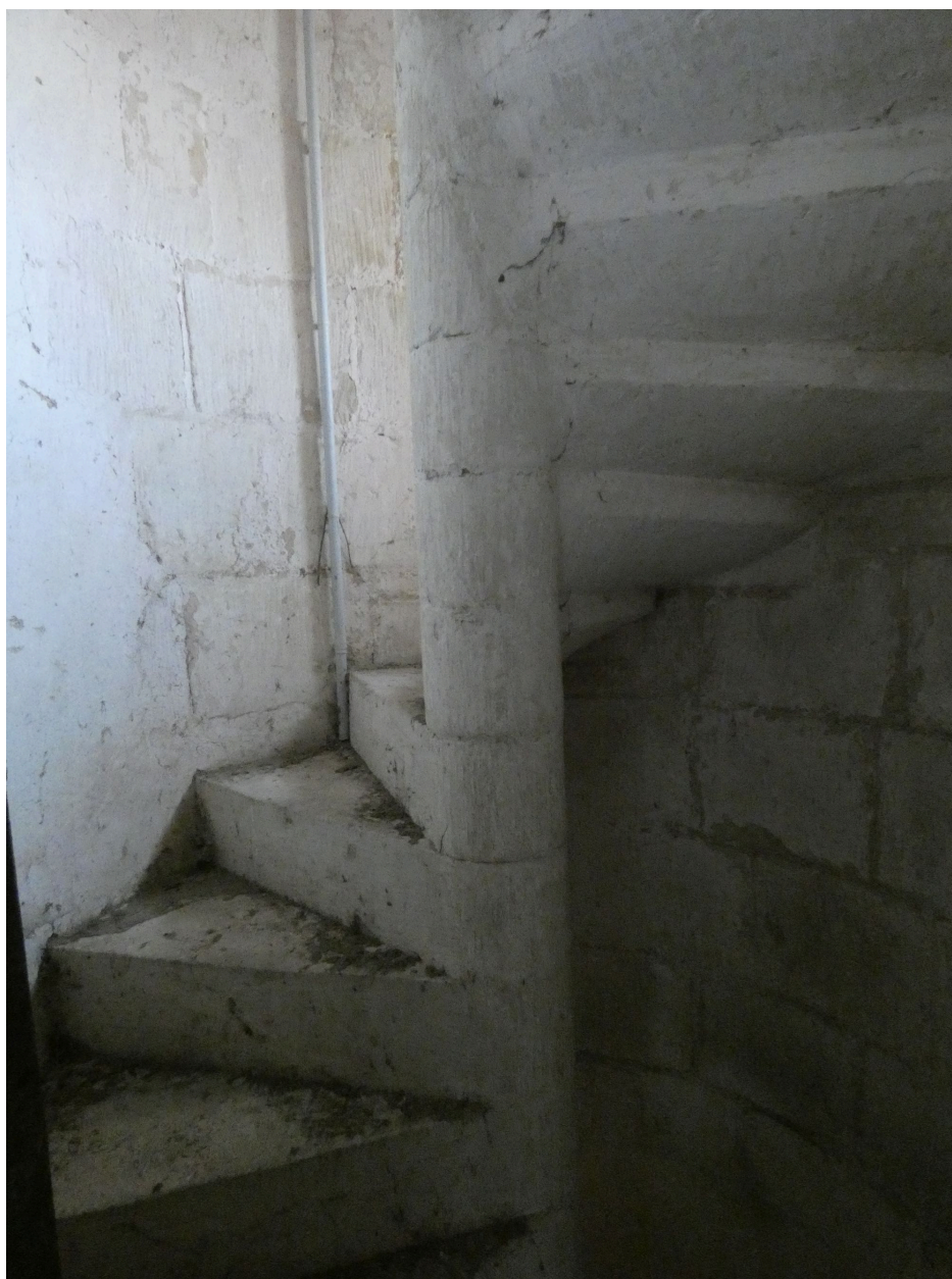
L'escalier en vis du clocher.
