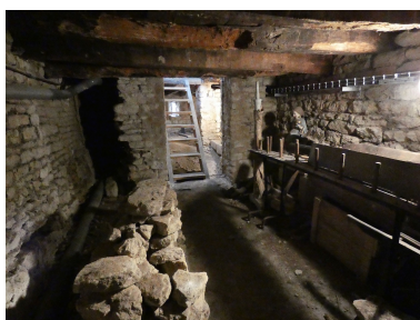
Le soubassement sous la sacristie nord-est. Phot. Yannis Suire IVR52_20228501178NUCA
