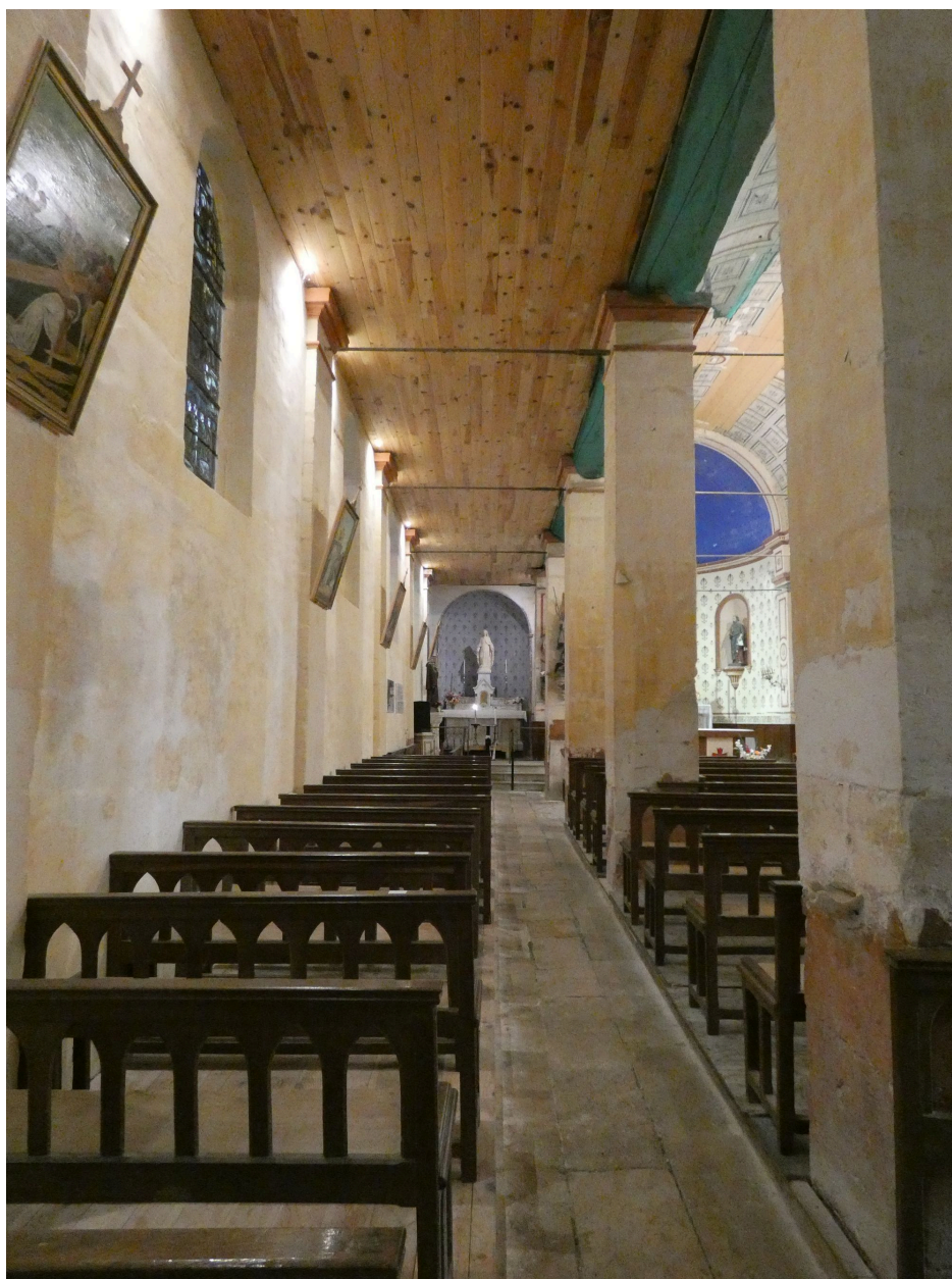
Le bas-côté nord vu depuis l'ouest.
