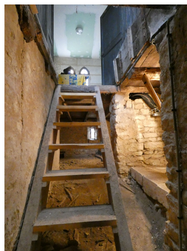
Descente dans les soubassements des sacristies. Phot. Yannis Suire IVR52_20228501179NUCA
