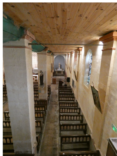
Le bas-côté sud vu depuis l'ouest. Phot. Yannis Suire
