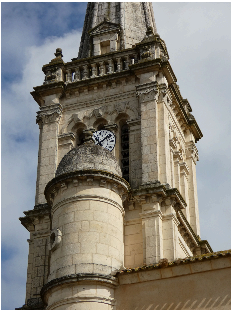
Détail du clocher, vu depuis le sud.
