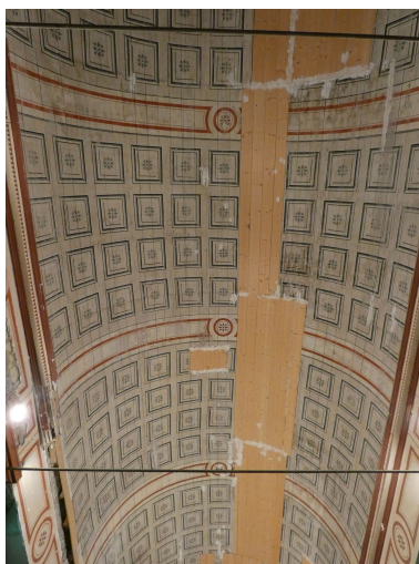
La fausse voûte en berceau de la nef. Phot. Yannis Suire IVR52_20228501195NUCA
