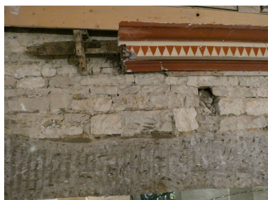
Pierre et bois de l'entablement apparaissant sous le décor en bois, au niveau de la tribune. Phot. Yannis Suire IVR52_20228501203NUCA
