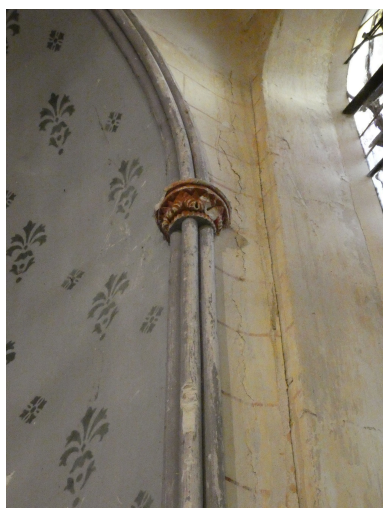
Colonnnettes et chapiteau dans la chapelle latérale sud. Phot. Yannis Suire IVR52_20228501293NUCA
