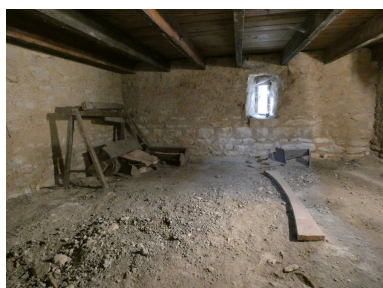
Le soubassement sous la sacristie sud-est. Phot. Yannis Suire IVR52_20228501180NUCA
