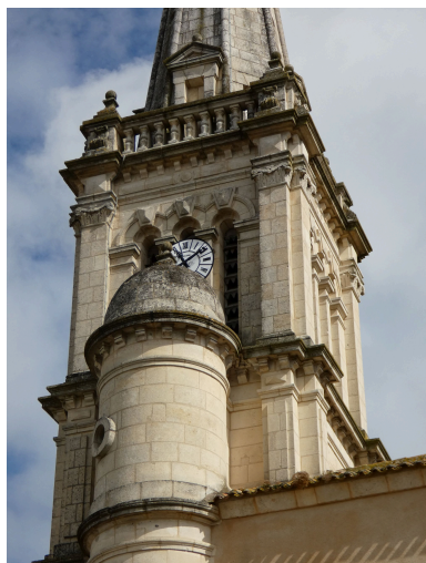
Détail du clocher, vu depuis le sud.
