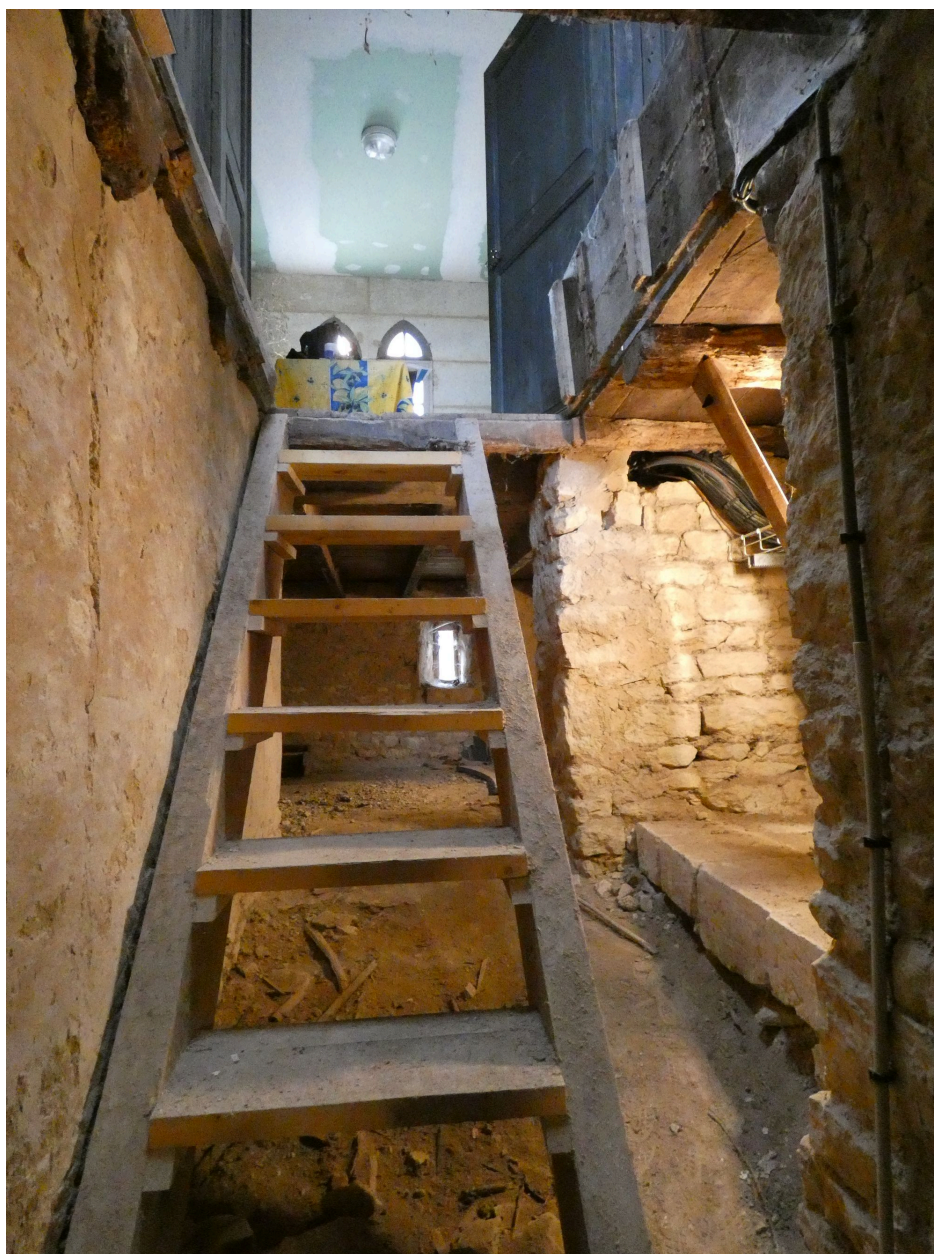
Descente dans les soubassements des sacristies.
