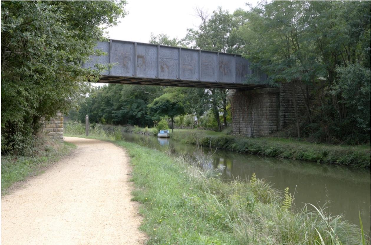
Pont-rail à poutres latérales hautes sur le canal de Nantes à Brest.
