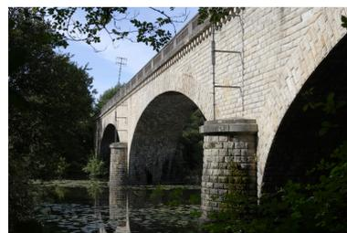
Pont-rail maçonné sur l'Hocmard.
