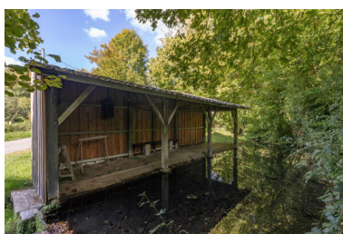
Lavoir de la Fontaine-Marie. Phot. Jeanne Minier IVR52_20257200656NUCA
