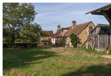
Ferme de la Roustière. Phot. Jeanne Minier IVR52_20257200733NUCA
