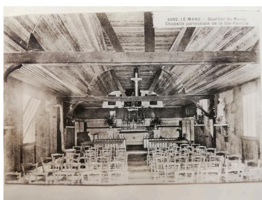
Vue de l'intérieur de la chapelle avant les bombardements de 1944, carte postale ancienne. Repro. Marie Ferey IVR52_20207200081NUCA
