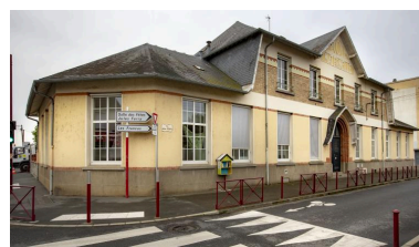
Vue de l'école maternelle. Phot. Pierre-Bernard Fourny IVR52_20197202545NUCA
