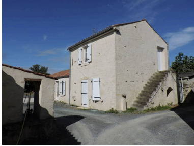
La maison vue depuis l'est. Phot. Yannis Suire IVR52_20198501931NUCA
