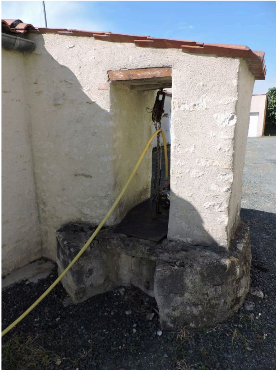
Le puits dans l'angle est de la cour.
