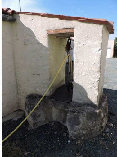
Le puits dans l'angle est de la cour. Phot. Yannis Suire IVR52_20198501932NUCA
