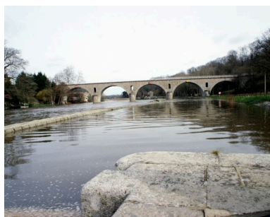
Le pont de Rochefort, reliant les communes d'Andouillé et de Montfleurs. Phot. François Lasa IVR52_20025300402XA
