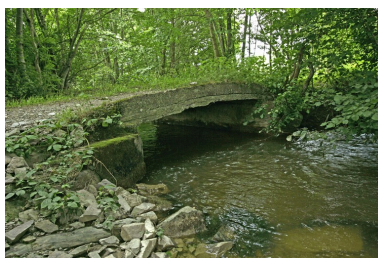
Le pont situé près de l'écart des Petits-Champs à Pré-en-Pail : vue d'amont depuis la rive gauche. Phot. François Lasa IVR52_20075300415NUCA
