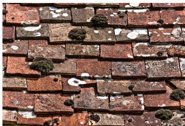
Détail de la couverture de tuiles plates du logis de la ferme 1. Phot. Yves Guillotin IVR52_20147201858NUCA
