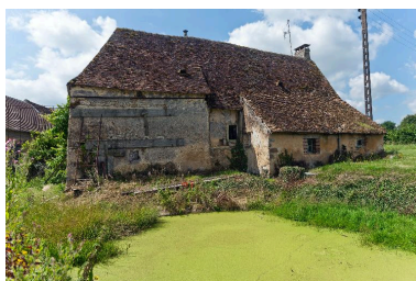
Elévation postérieure du logement de la ferme 2. Phot. Yves Guillotin IVR52_20147201850NUCA
