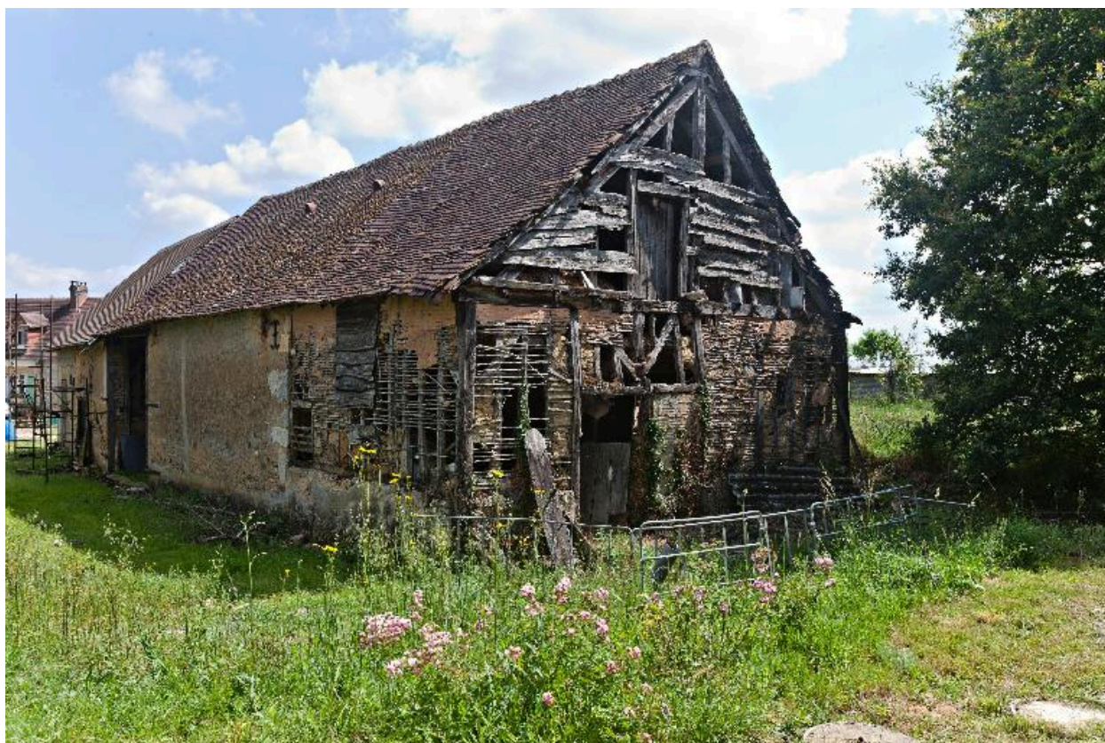
Grange-étables de la ferme 2 vue depuis le sud-ouest.
