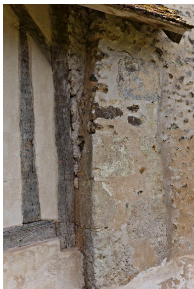
Détail de l'élévation antérieure du logis de la ferme 1 : jonction du mur-pignon portant la cheminée et du pan-de-bois. Phot. Yves Guillotin IVR52_20147201852NUCA
