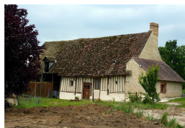
Elévation antérieure du logis de la ferme 1. Phot. Julien Hardy IVR52_20147200027NUCA
