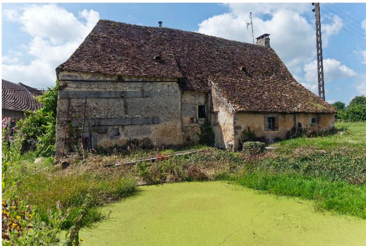
Elévation postérieure du logement de la ferme 2.
