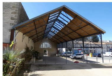
Le préau-halle vu depuis l'est. Phot. Yannis Suire IVR52_20238501328NUCA
