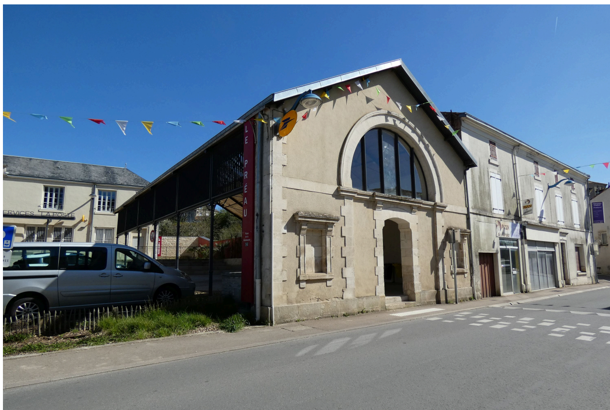
Le préau-halle vu depuis le nord-ouest.
