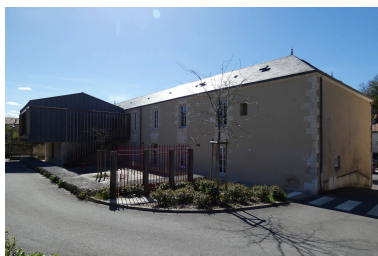
L'ancienne école vue depuis le nord-est. Phot. Yannis Suire IVR52_20238501323NUCA
