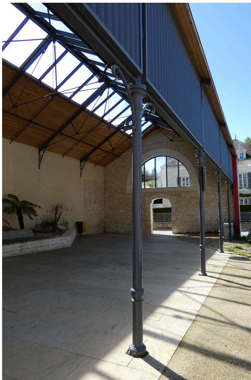
Détail du préau-halle et de son architecture métallique.
