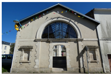
La façade ouest du préau. Phot. Yannis Suire IVR52_20238501336NUCA
