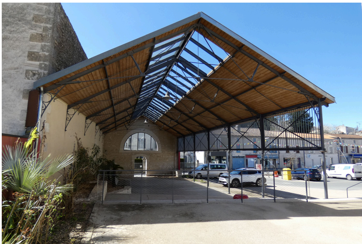
Le préau-halle vu depuis l'est.
