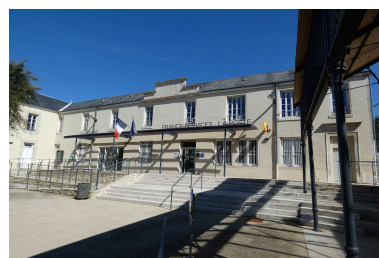
L'ancien bâtiment de classes vu depuis l'ouest. Phot. Yannis Suire IVR52_20238501325NUCA
