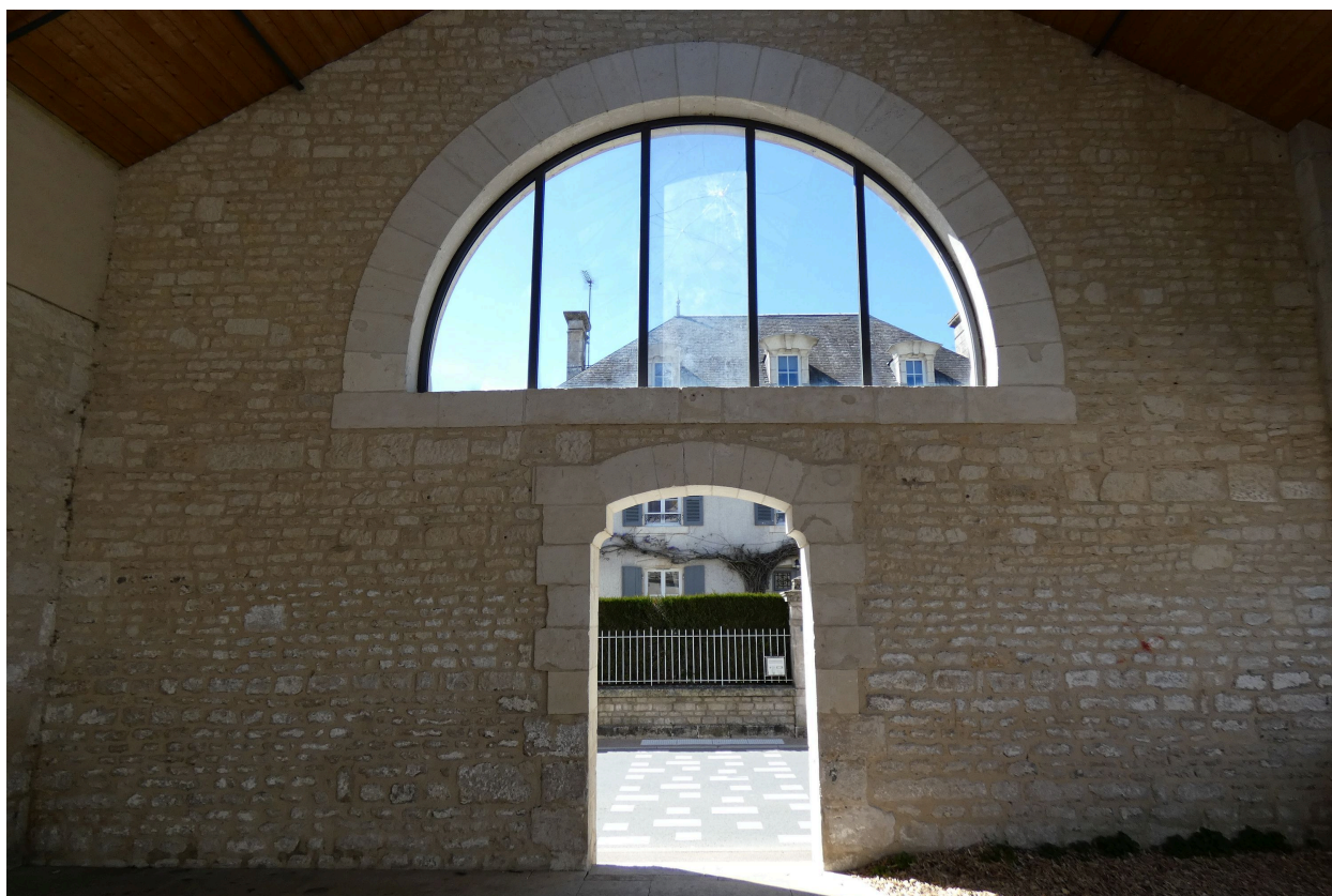
La façade du préau-halle vue depuis l'intérieur.
