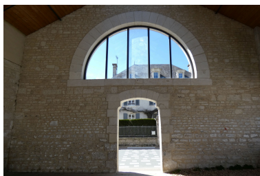
La façade du préau-halle vue depuis l'intérieur. Phot. Yannis Suire IVR52_20238501329NUCA
