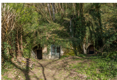
Entrées d'aménagements troglodytiques aux Caves Ridelières. Phot. Jeanne Minier IVR52_20267200355NUCA
