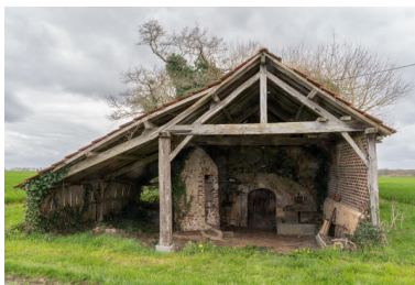
Cellier semi-enterré avec hangar abritant un puits et un pressoir. Phot. Jeanne Minier IVR52_20267200320NUCA
