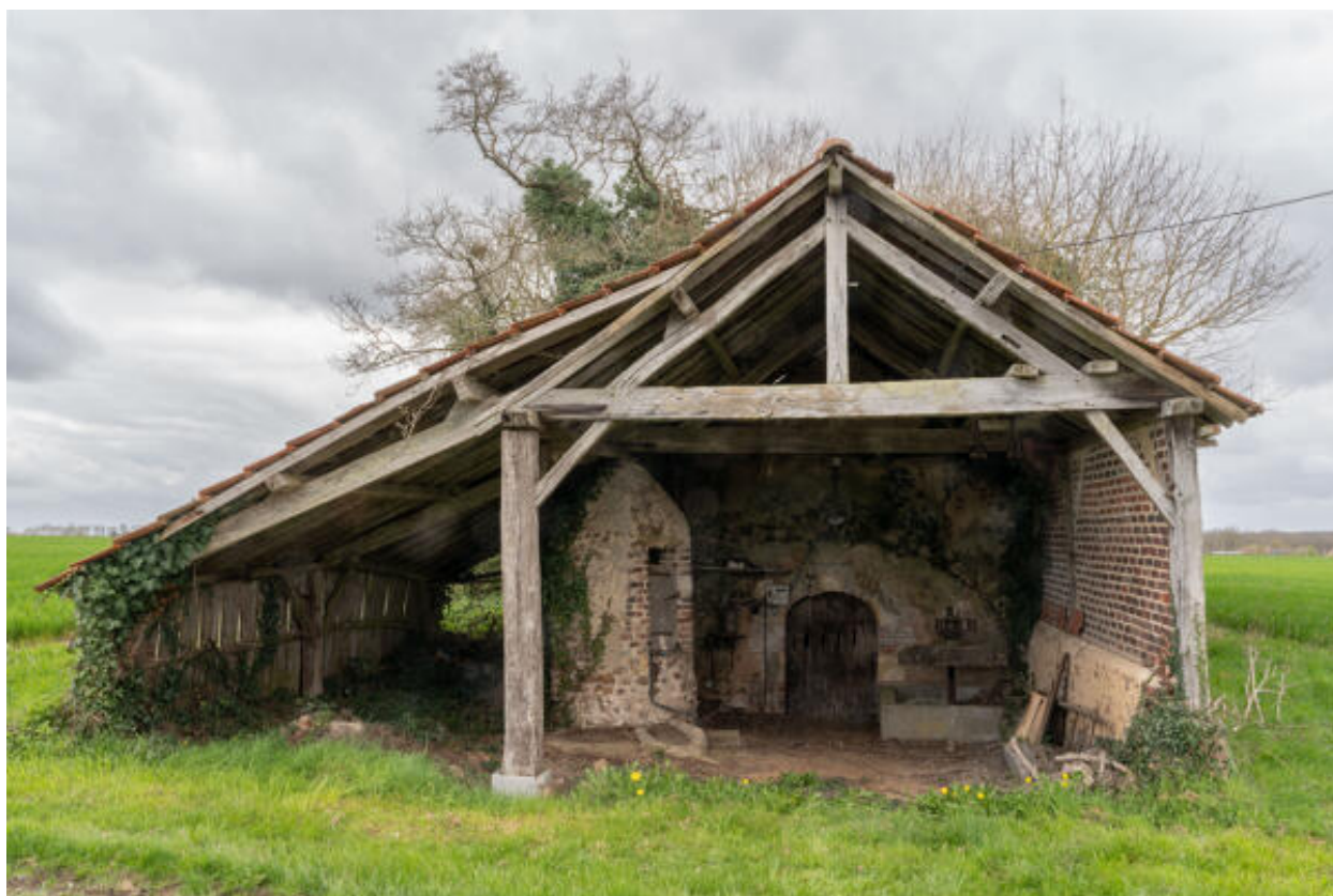
Cellier semi-enterré avec hangar abritant un puits et un pressoir.
