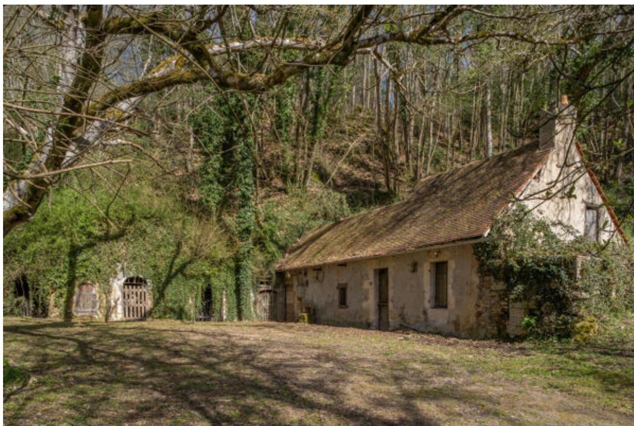
Aménagements troglodytiques et logis ancien aux Caves Ridelières.
