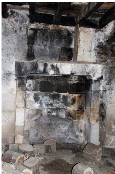
Les toits à porcs, détail : la cheminée.
