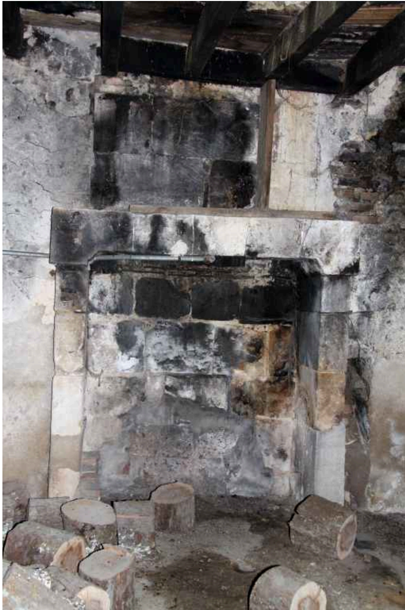
Les toits à porcs, détail : la cheminée.
