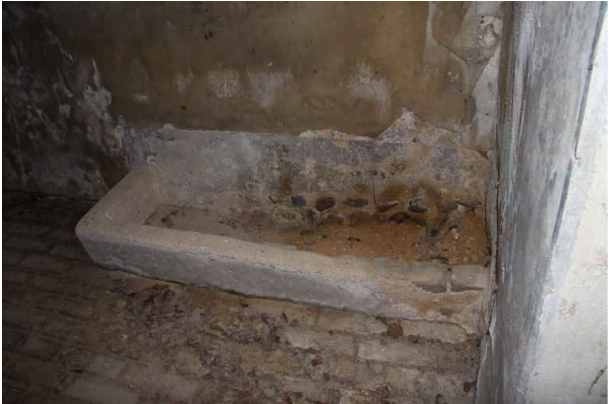
L'extension des toits à porcs : une auge.
