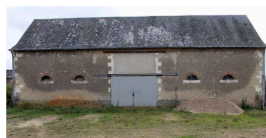
Les étables : façade sur cour. Phot. Jean-Baptiste Darrasse IVR52_20087202261NUCA
