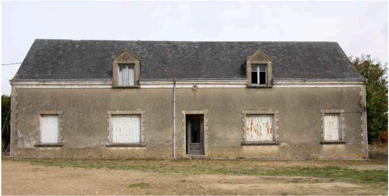
La maison d'habitation : façade sur cour.
