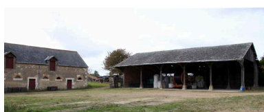
Le hangar face à la grange. Phot. Jean-Baptiste Darrasse IVR52_20087202273NUCA
