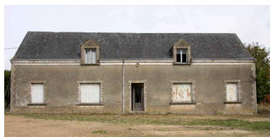
La maison d'habitation : façade sur cour. Phot. Jean-Baptiste Darrasse IVR52_20087202260NUCA
