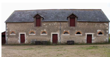
Les étables face à la maison. Phot. Jean-Baptiste Darrasse IVR52_20087202262NUCA
