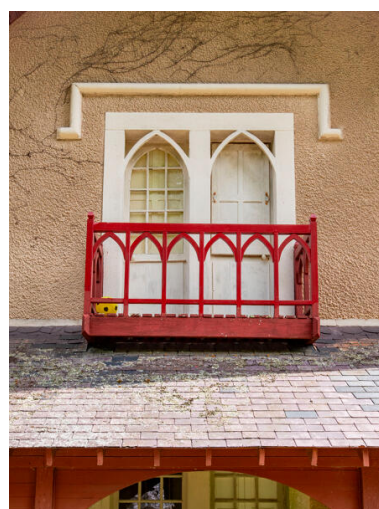
La fenêtre du mur-pignon et son balcon. Phot. Pierre-Bernard Fourny IVR52_20235301050NUCA
