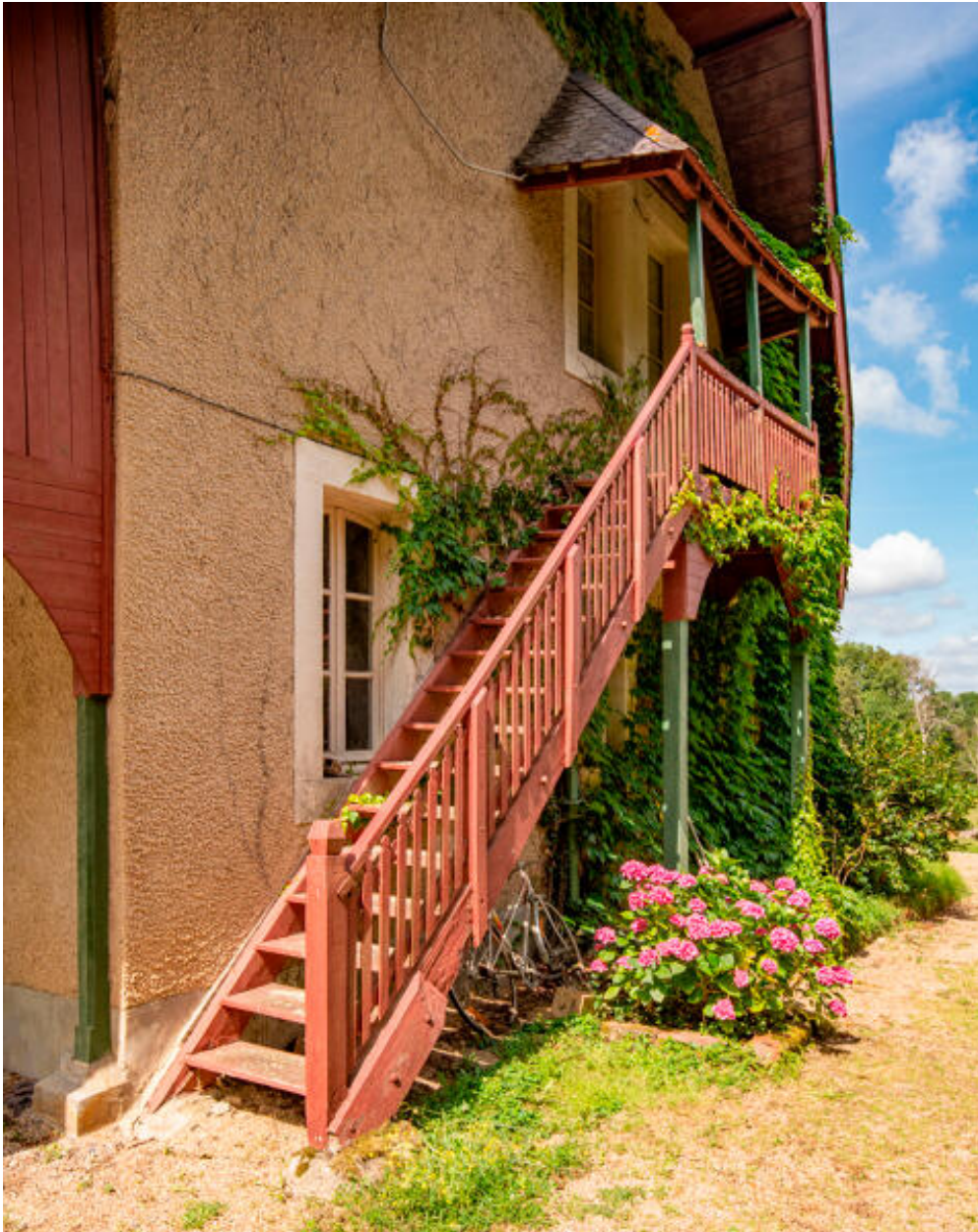
L'escalier du mur-pignon.
