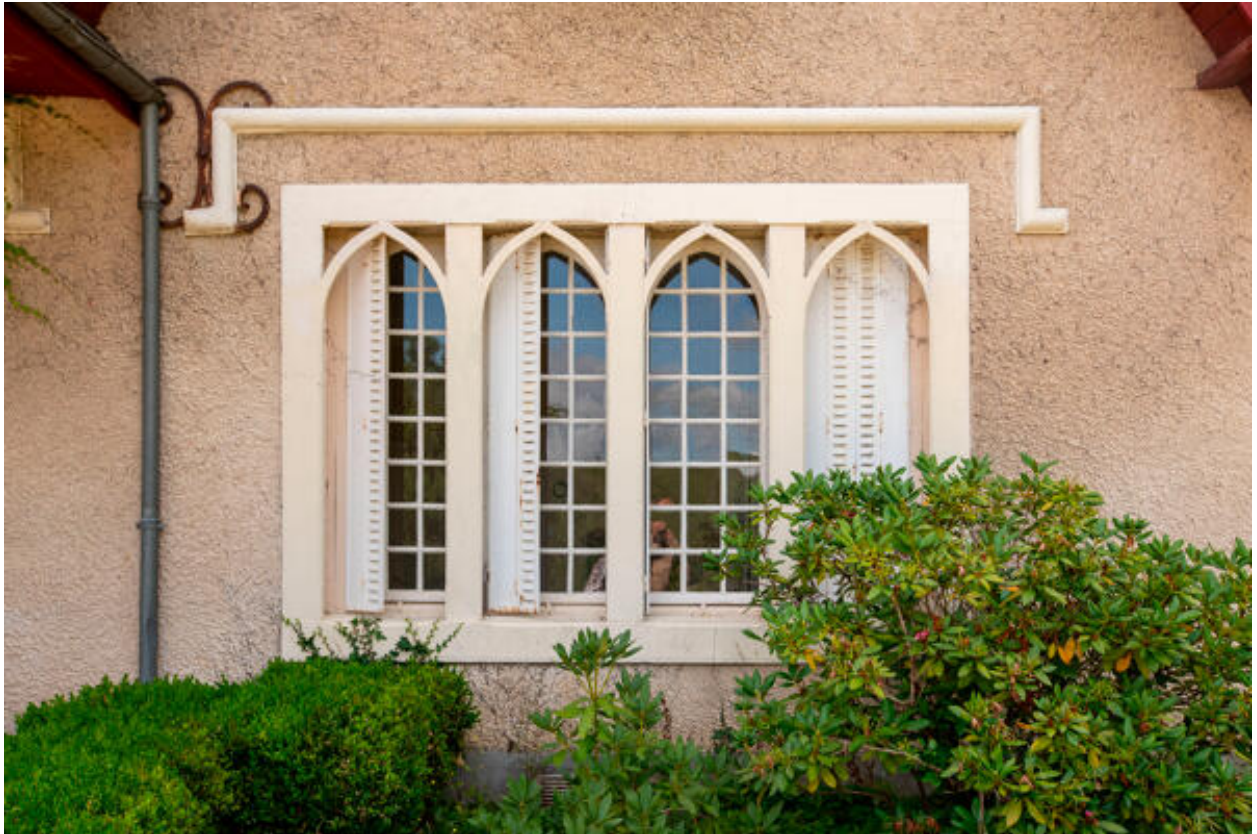
Une fenêtre de la façade antérieure.
