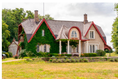
L'élévation antérieure. Phot. Pierre-Bernard Fourny IVR52_20235301059NUCA
