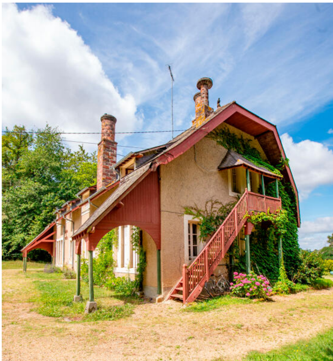
L'escalier du mur-pignon.
