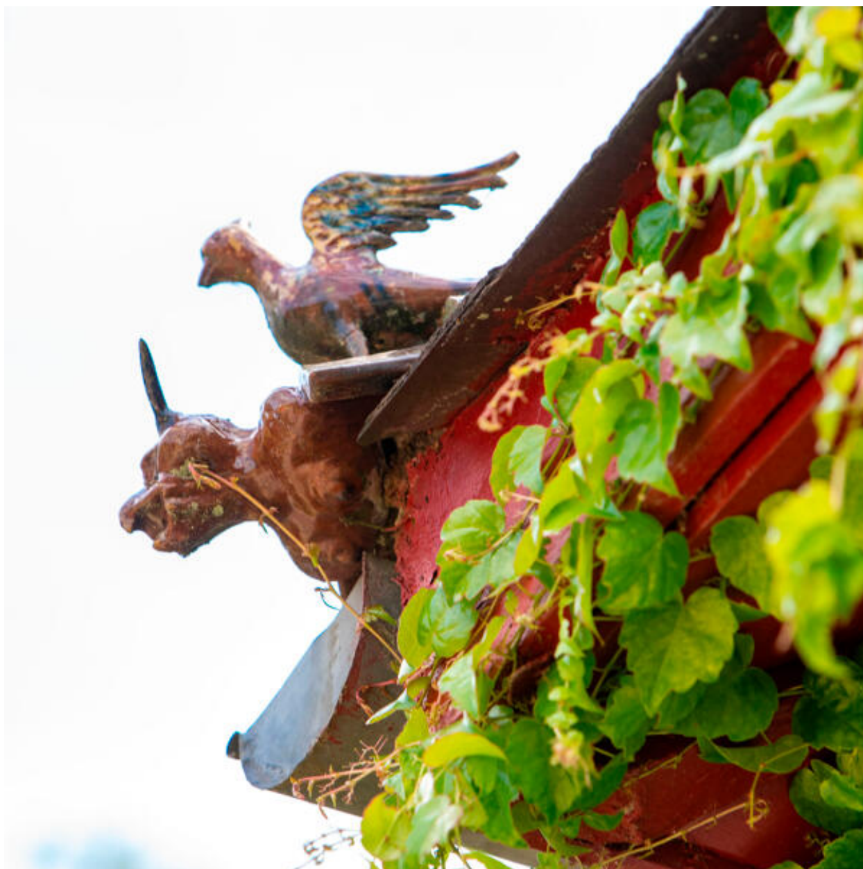
Une acrotère en terre cuite à l'extrémité du toit du porche.
