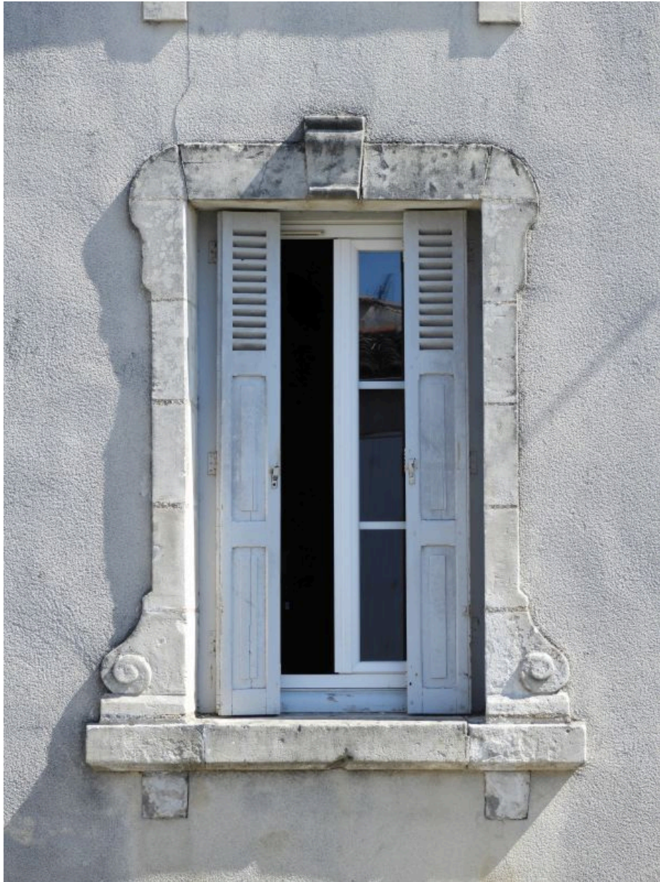
Une des ouvertures avec son encadrement saillant et mouluré.
