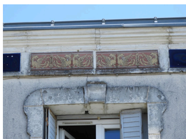
Détail de la frise au sommet de la façade. Phot. Yannis Suire IVR52_20198500026NUCA
