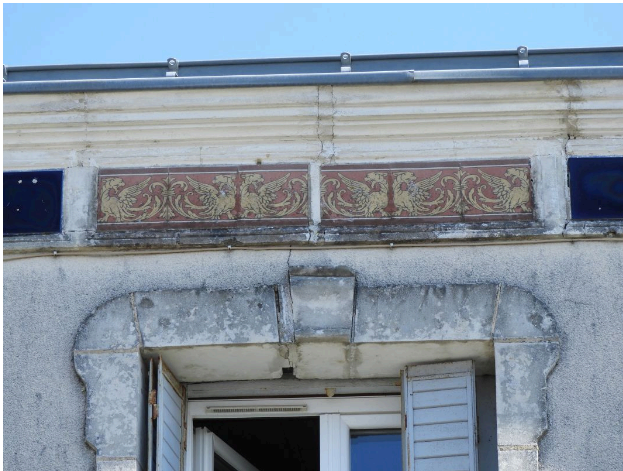
Détail de la frise au sommet de la façade.
