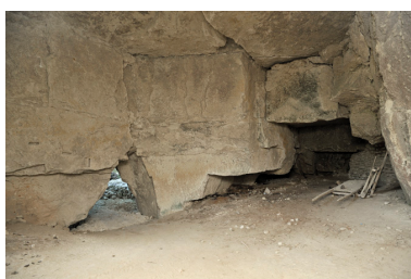
Site principal (11-16, ruelle des Perreyeurs). Fontis est. Vue des strates exploitées et effondrées. Phot. Bruno Rousseau IVR52_20124901659NUCA
