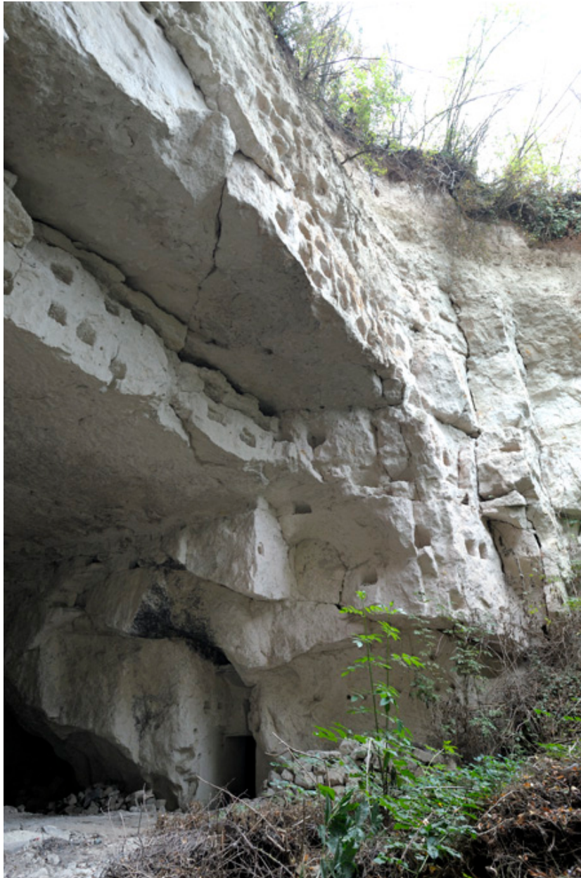
Site principal (11-16, ruelle des Perreyeurs). Fontis est. Vue des strates exploitées et effondrées.
