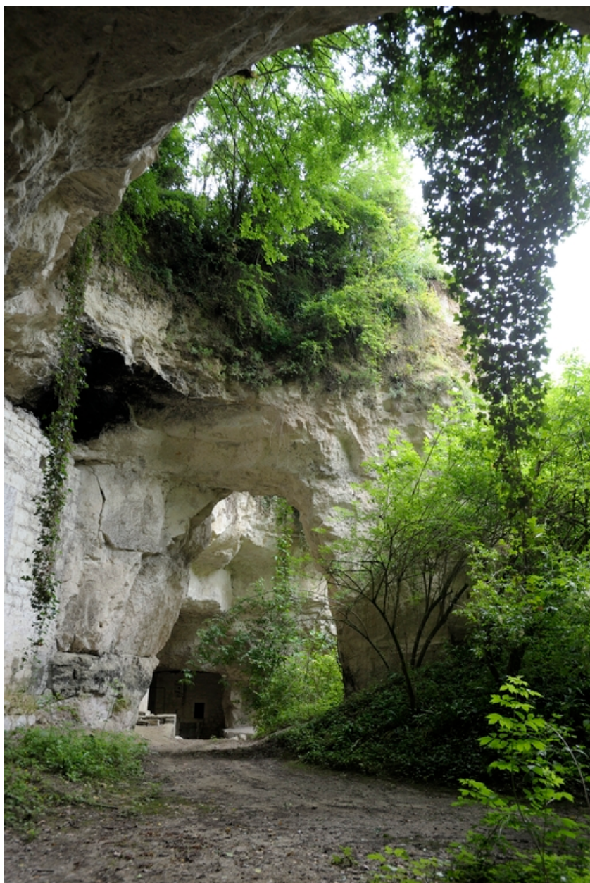
Site principal (11-16, ruelle des Perreyeurs). Fontis ouest. Arche constituée après effondrements de galeries d'extraction entourant un pilier tourné.
