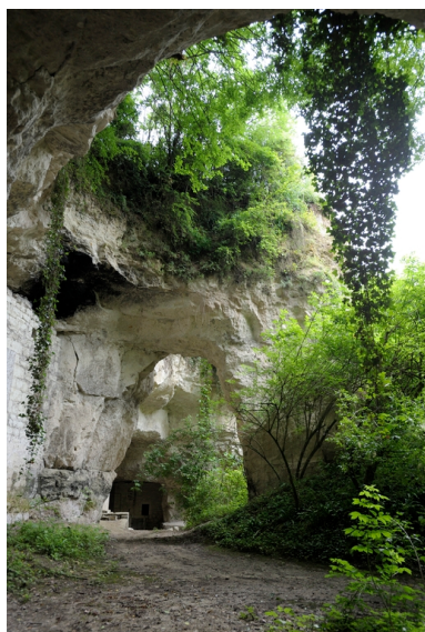
Site principal (11-16, ruelle des Perreyeurs). Fontis ouest. Arche constituée après effondrements de galeries d'extraction entourant un pilier tourné. Phot. Bruno Rousseau IVR52_20134900807NUCA
