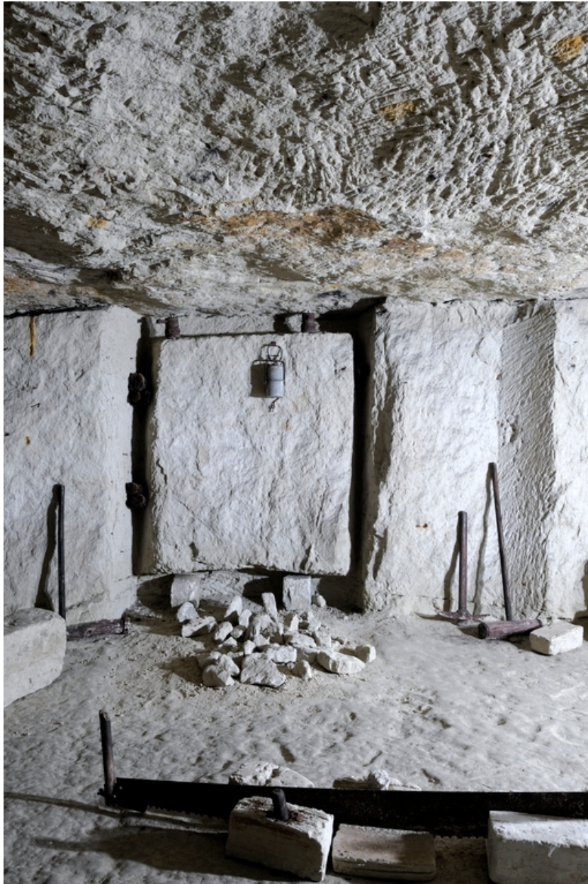
Saut-aux-Loups. Ancienne carrière : scénographie sur l'extraction du tuffeau, dalle dégagé par des saignées, coins, maillet, pic, scie, lampe.
