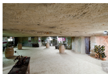
7, chemin des Caves. Galeries d'exploitation du XIXe siècle. Extraction régulière en grande chambre quadrangulaire et piliers longs. Phot. Bruno Rousseau IVR52_20124900016NUCA
