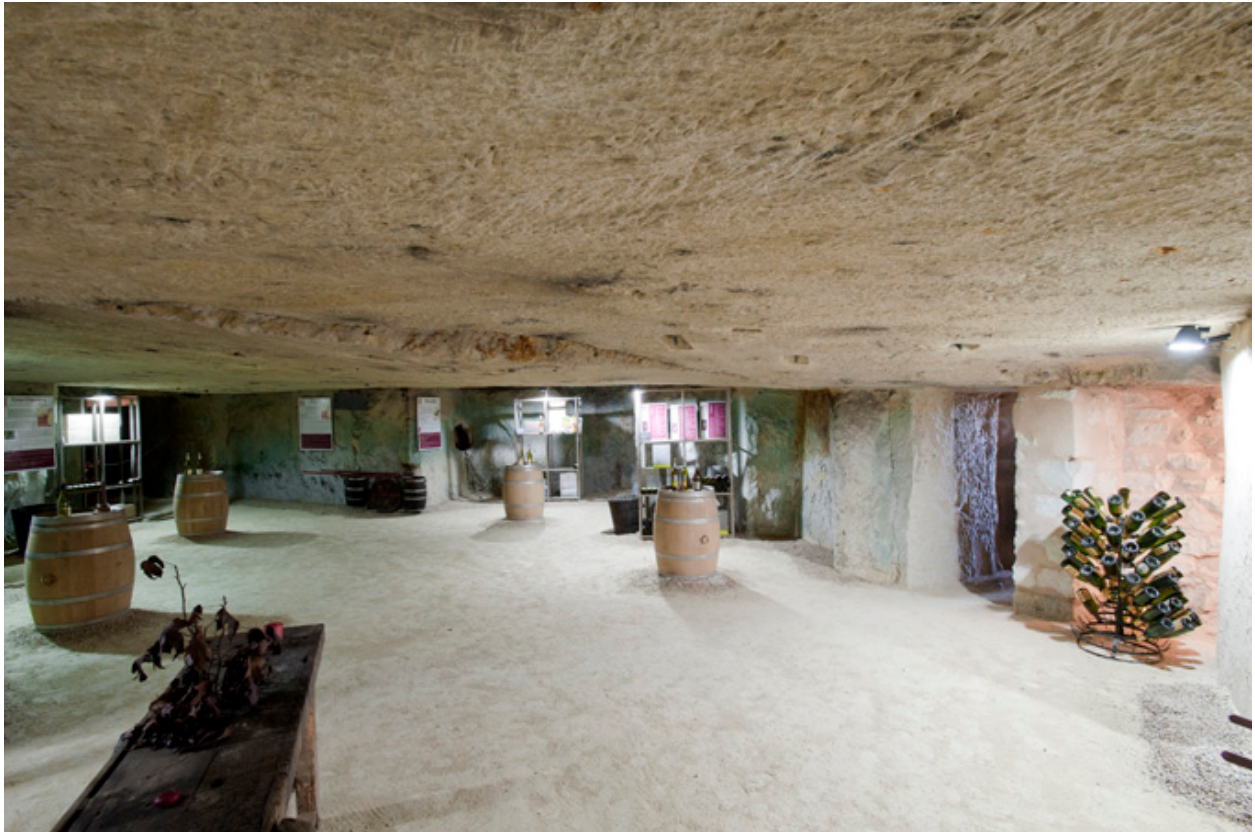
7, chemin des Caves. Galeries d'exploitation du XIXe siècle. Extraction régulière en grande chambre quadrangulaire et piliers longs.
