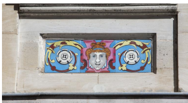
Détail des carreaux de céramique en façade. Phot. Pierre-Bernard Fourny IVR52_20197202147NUCA
