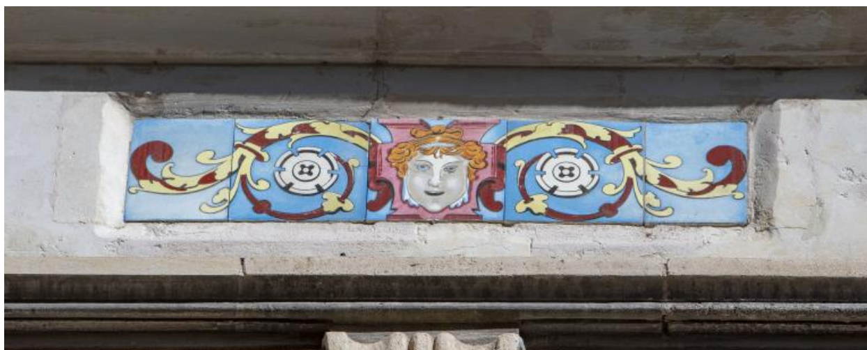
Détail des carreaux de céramique en façade.
