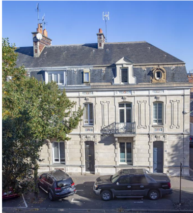
Vue de la maison est de la série de maisons. Phot. Pierre-Bernard Fourny IVR52_20197202108NUCA
