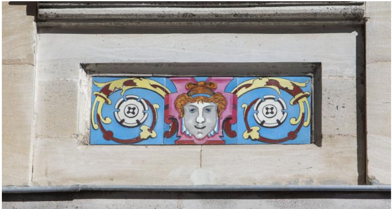
Détail des carreaux de céramique en façade.
