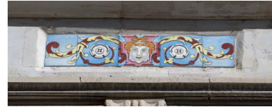
Détail des carreaux de céramique en façade. Phot. Pierre-Bernard Fourny IVR52_20197202148NUCA
