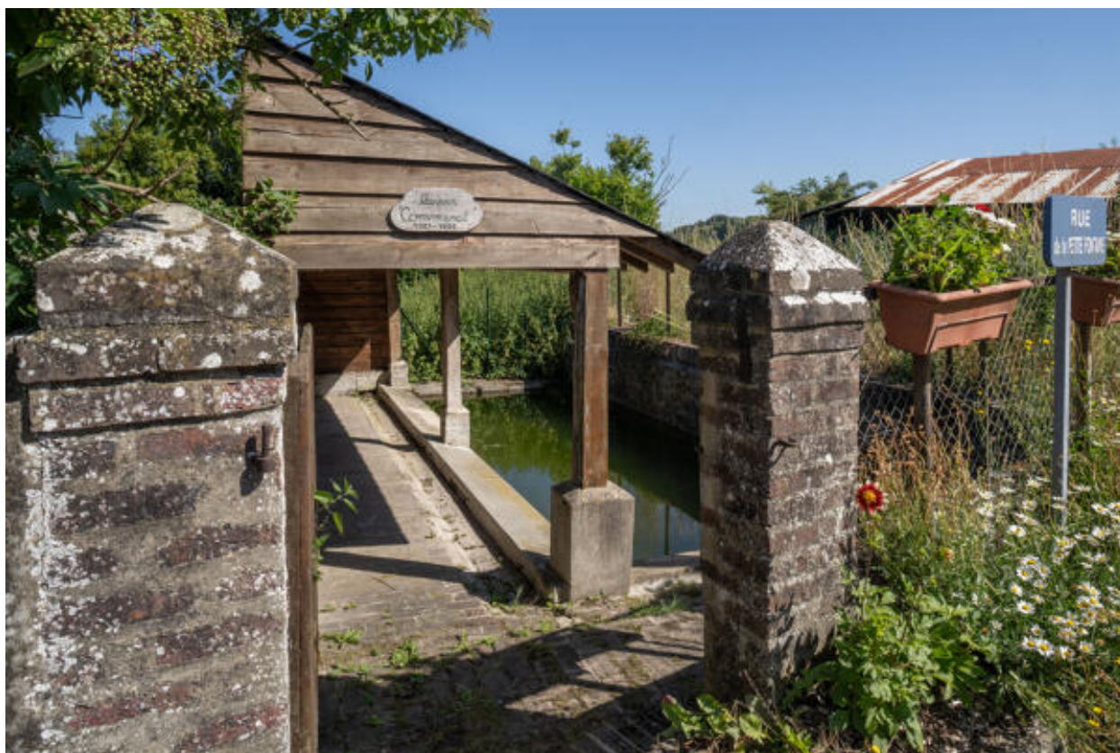
Vue d'ensemble depuis la rue.
