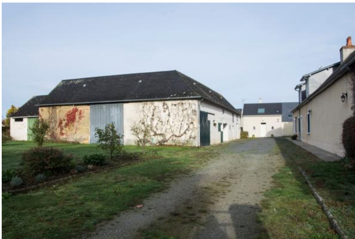
Vue d'un ensemble agricole rue Prémartine.
