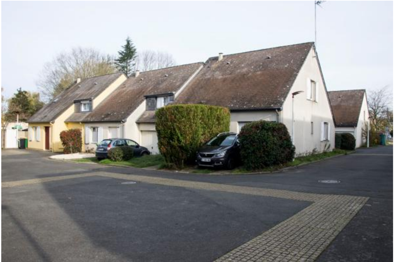
Vue du lotissement rue des Sternes.
