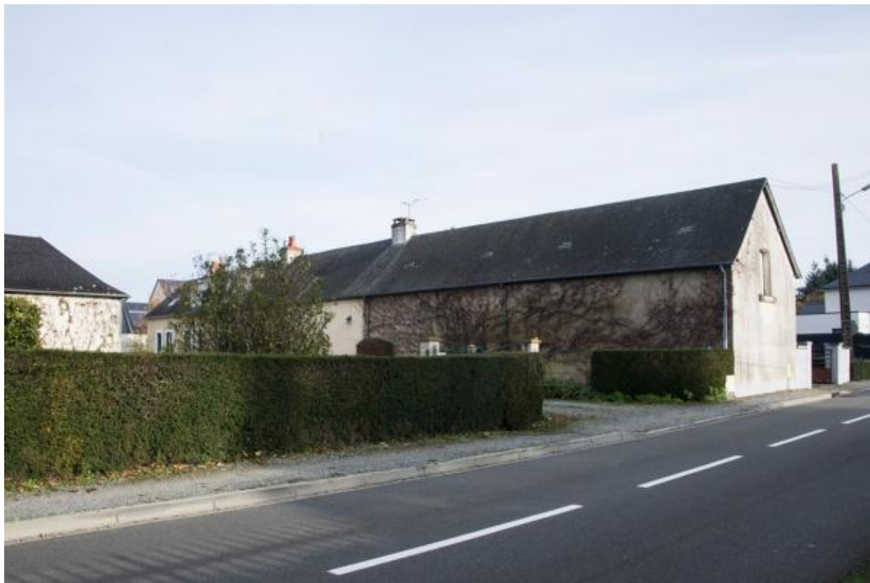
Vue d'un corps de ferme au croisement de la rue Prémartine et du chemin des Homelets.
