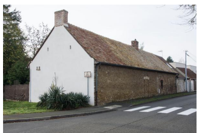
Vue d'un corps de ferme transformé en maison à l'est de la rue Prémartine. Phot. Bruno Rousseau IVR52_20207200933NUCA
