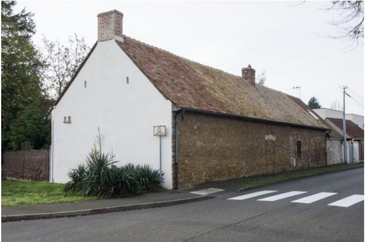
Vue d'un corps de ferme transformé en maison à l'est de la rue Prémartine.
