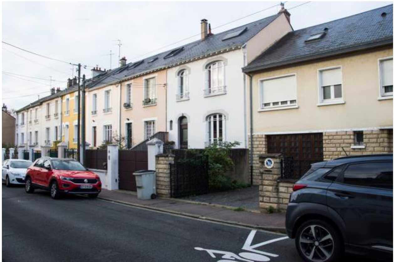
Vue de la partie ouest de la rue Mazagran.
