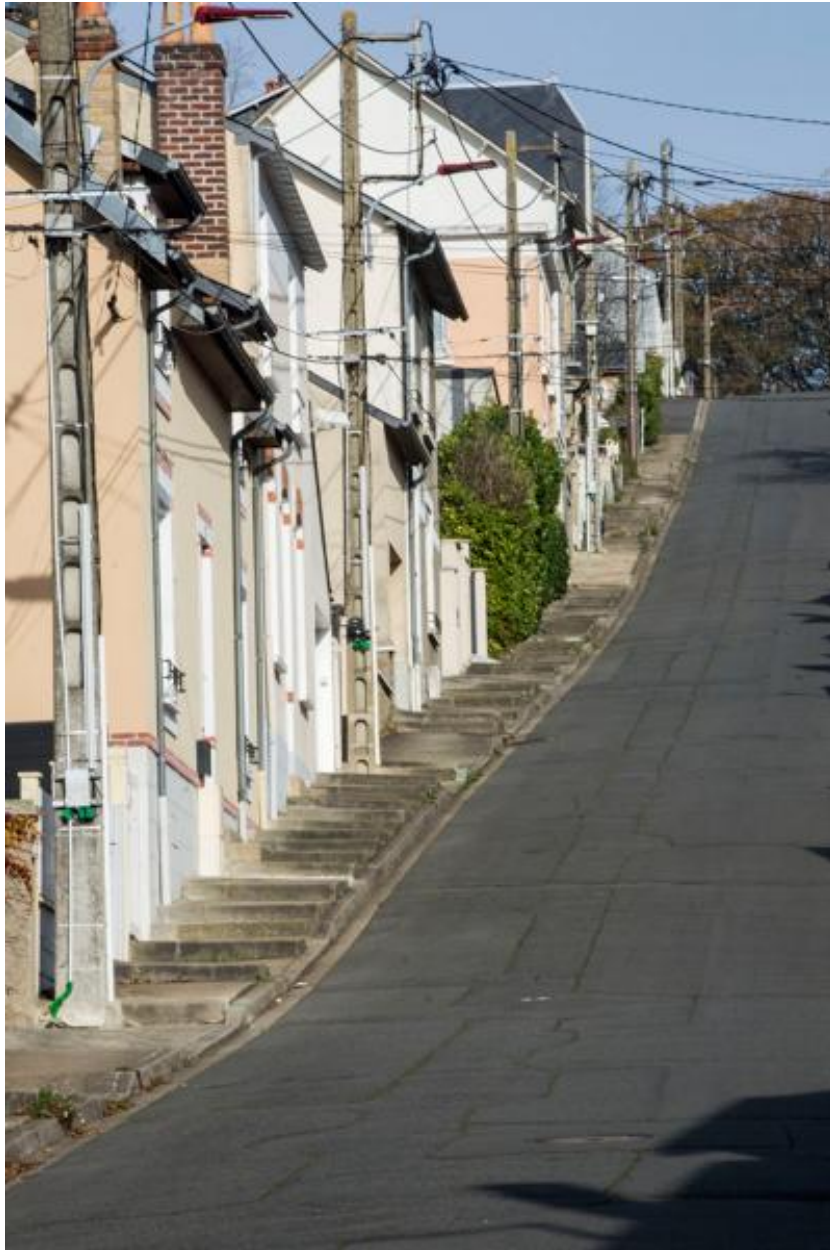
Vue des maisons ouest de la rue Gazonfier.
