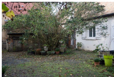
Cour commune et bâtiments à usage agricole rue de la vallée Saint-Blaise.
