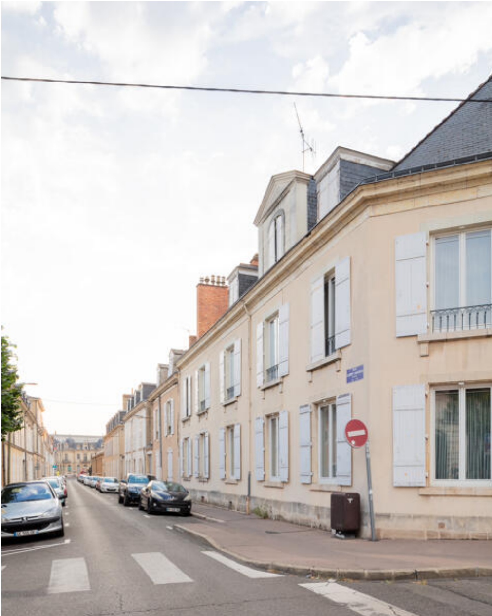
Vue de la partie sud de la rue Sainte-Croix.
