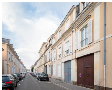
Vue de la rue Albert- Maignan depuis l'ouest. Phot. Paul Hamelin IVR52_20227200896NUCA
