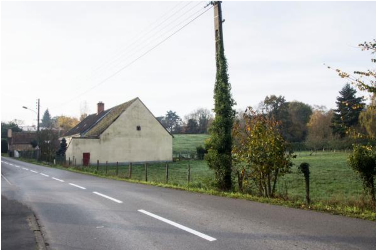
Vue de la maison dite du clos Saint-Louis rue de l'Eventail.
