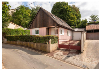
Vue d'une maison en bois et métal impasse du Tyrol. Phot. Thierry Seldubuisson IVR52_20227200936NUCA
