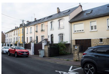
Vue de la partie ouest de la rue Mazagran. Phot. Bruno Rousseau IVR52_20207201018NUCA
