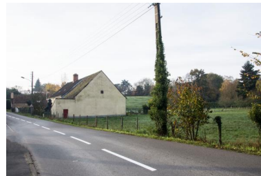
Vue de la maison dite du clos Saint-Louis rue de l'Eventail. Phot. Bruno Rousseau IVR52_20207200925NUCA
